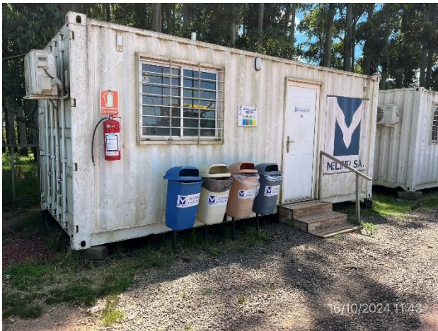
Foto 12.1-1, P03. Obrador y planta asfáltica de Meliter SA. Faja pública de Ruta 6 progresiva 274K400 a (+).
