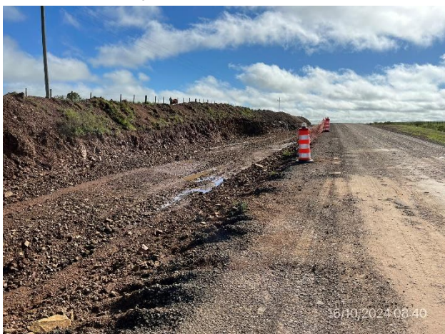
Foto 12.2-3, Ruta 6. Sector con excavación realizada para ensanche de base.
