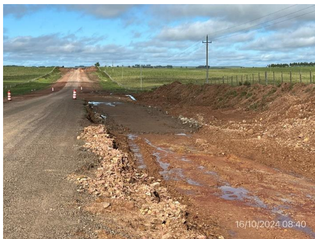
Foto 12.2-4, Ruta 6. Sector con excavación realizada para ensanche de base y perfilado de subrasante.
