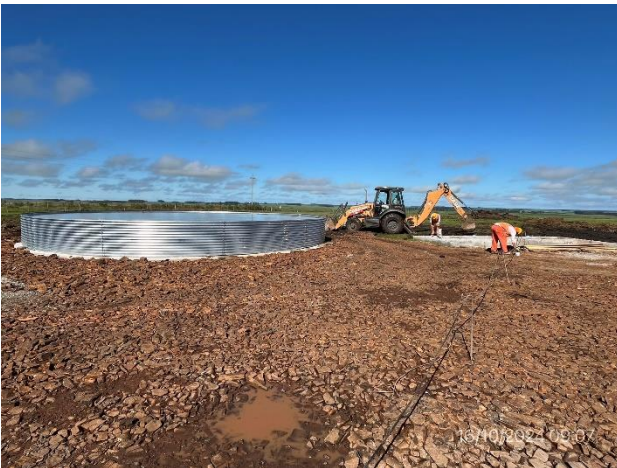
Foto 12.1-9, P03. Obrador, tajamar para acopio de agua.
