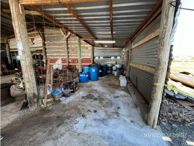
Foto 12.1-7, P03. Obrador, local techado y envallado Para acopio de lubricantes. El envallado no está completo.
