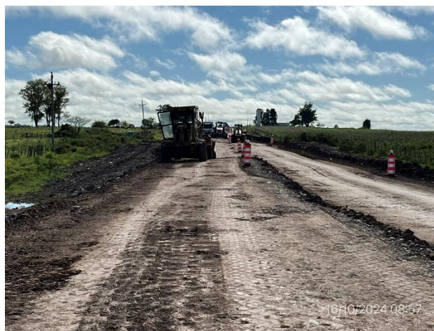
Foto 12.2-10, P04. Frente de obras, trazado ensanchado y perfilado de sub base granular en ejecución.
