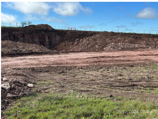
Foto 12.2-7, P05. Préstamo de material granular. Faja pública de Ruta 6, progresiva 313K800 (*) a (+).
