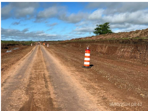
Foto 12.2-5, Ruta 6. Sector con excavación realizada para ensanche de base y perfilado de subrasante.
