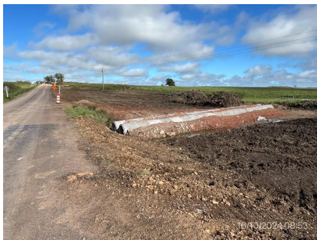
Foto 12.2-6, Ruta 6. Alcantarillas en ejecución.
