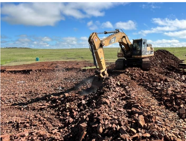
Foto 12.1-11, P03. Cantera, Maquinaria en tareas de destape y acopio de material triturado.
