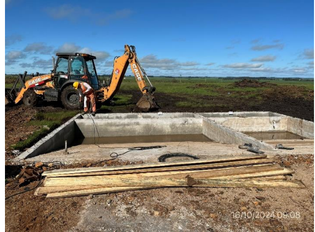
Foto 12.1-8, P03. Obrador, pileta de lavado de camiones mixer en construcción.
