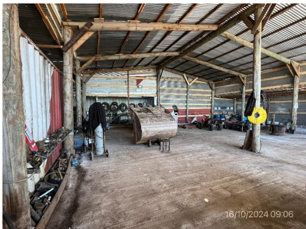
Foto 12.1-5, P03. Obrador, taller mecánico correctamente techado y con pavimento impermeable.
