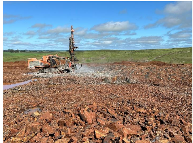
Foto 12.1-10, P03. Cantera, perforaciones en ejecución para futuras voladuras en yacimiento.
