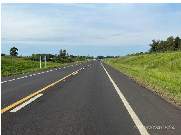
Foto 12.2-5. Obras terminadas y abiertas al tránsito en Ruta 3. Recapado ejecutado y obras de señalización terminadas.
