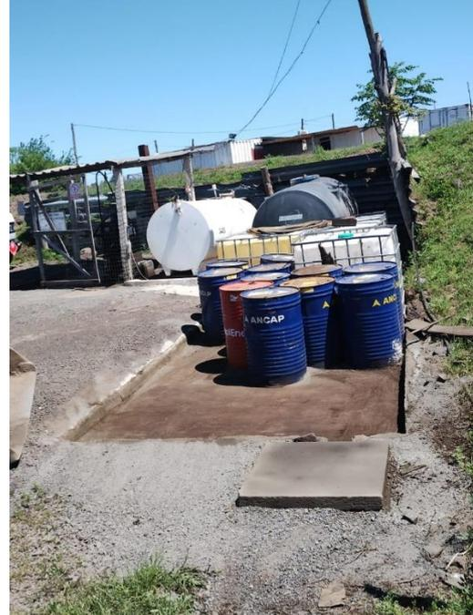
Foto 12.3-2, P03. Obrador, se recogieron las arenas contaminadas con hidrocarburos y se limpió la zona.
