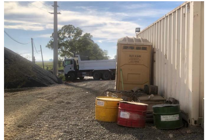
Foto 12.3-4, P03. Taller mecánico, se replicó la infraestructura para el acopio temporal de residuos.
