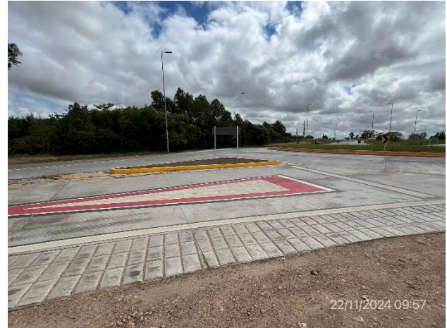
Foto 12.2-2, P02. Fin de tramo. Nueva rotonda de empalme con By Pass Young.
