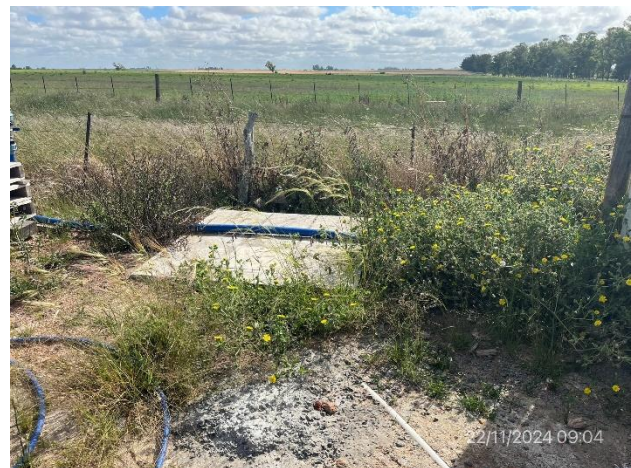
Foto 12.1-10, P03. Pozo impermeable para captación de aguas servidas.
