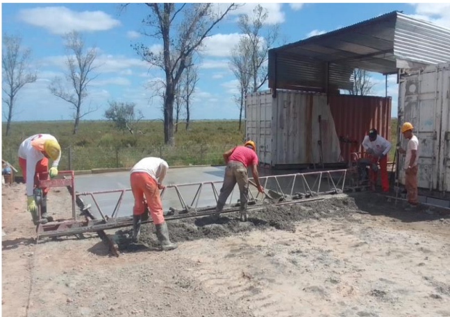
Foto 12.3-3, P03. Obrador, se construyó pavimento impermeable en zona de taller mecánico.
