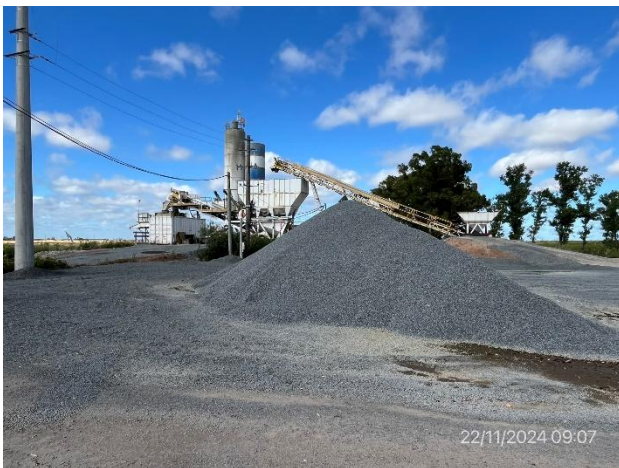
Foto 12.1-9, P03. Explanada de maniobras y acopio de áridos en sector de planta de hormigón, buenas condiciones de orden y limpieza.
