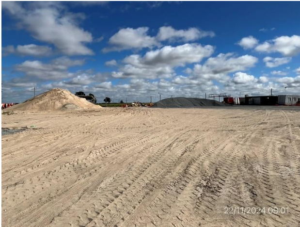
Foto 12.1-5, P03. Obrador y planta de hormigón sin actividad. Ruta 25 progresiva 12K500 a (-).
