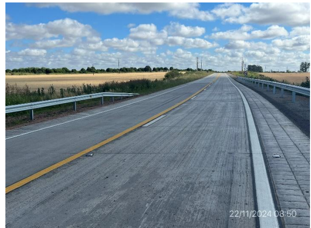
Foto 12.2-4, Ruta 25. Obras de señalización horizontal y defensas metálicas terminadas.
