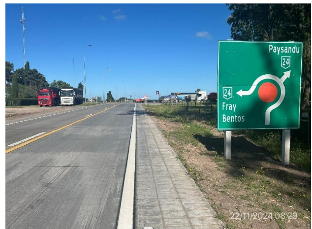
Foto 12.2-6, P01. Inicio de tramo. Ruta 25 progresiva 0K000. Empalme con Ruta 24.
