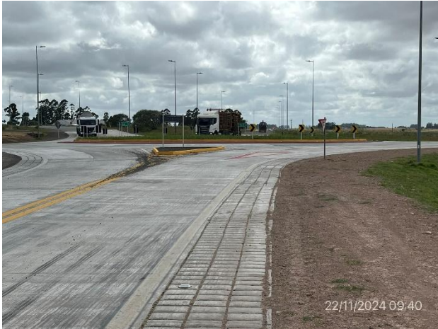
Foto 12.2-1, P02. Fin de tramo, Ruta 25 Progresiva 25K150. Empalme con By pass de acceso a Young.
