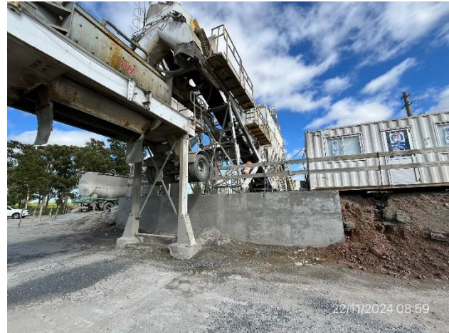
Foto 12.1-6, P03. Planta de hormigón sin actividad.
