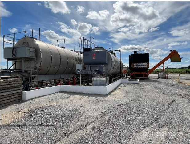
Foto 12.1-3, P03. Planta asfáltica, envallados correctos. Buenas condiciones de orden y limpieza.
