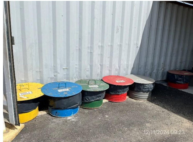
Foto 12.1-4, P03. Obrador, estación para acopio temporal de residuos segregados por corriente de generación.
