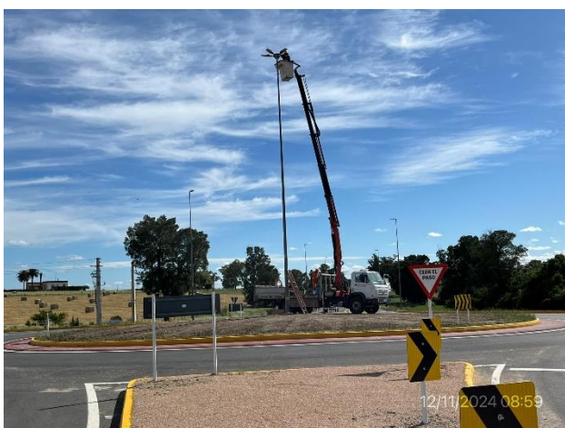
Foto 12.2-3. P06. Frente de obras. Ruta 45 progresiva 62K800 a (+), empalme con C° Fernandez Crespo. Obras de iluminación en fase de terminación.
