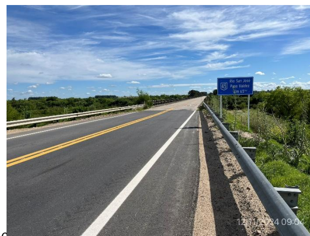
Foto 12.2-6, P02. Fin de tramo. Ruta 45 progresiva 65K500. Río San José, Paso Valdez. Obras de defensas metálicas terminadas.
