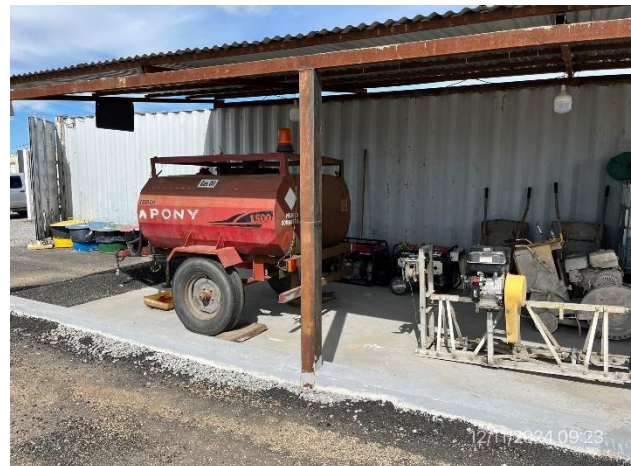
Foto 12.1-6, P03. Obrador, depósito de lubricantes en sector envallado y techado.
