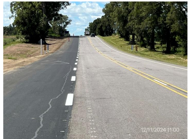
Foto 12.2-6. Sector de Ruta 23, con tercera vía terminada y abierta al tránsito.
