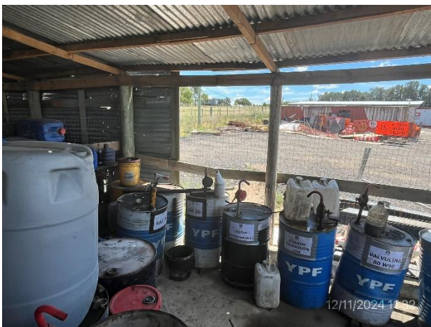
Foto 12.1-7, P03. Obrador, sector envallado para acopio de aceites usados y residuos contaminados con hidrocarburos.
