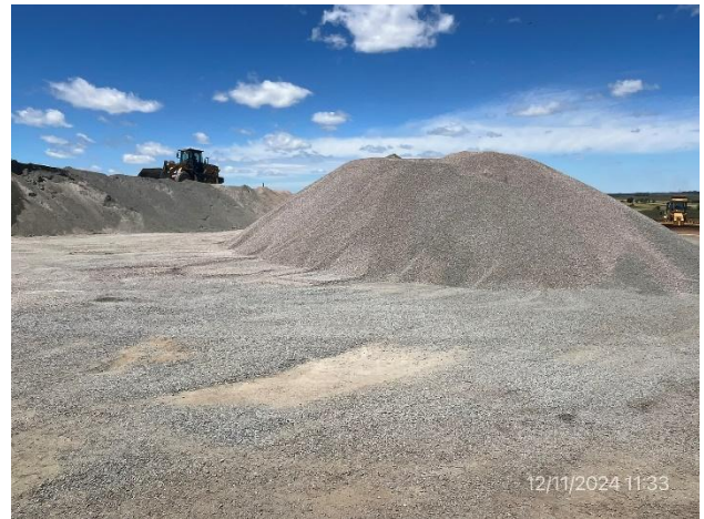
Foto 12.1-12, P03. Planta asfáltica, explanada para acopio de áridos.
