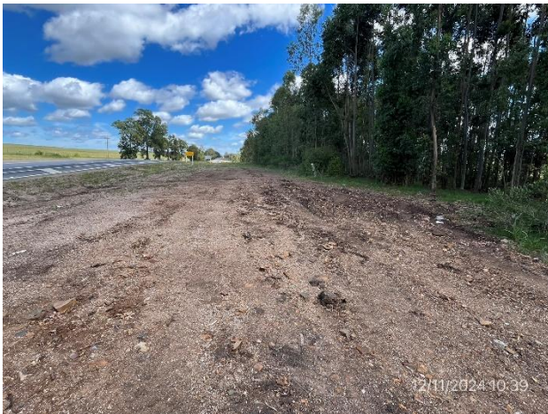
Foto 12.2-9, P06. Ruta 23 progresiva 126K600, sector de faja pública sin cobertura vegetal.
