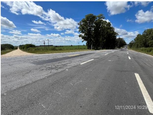
Foto 12.2-5, P05. Empalme con camino municipal terminado y abierto al tránsito. Ruta 23, progresiva 118K600 a (+).
