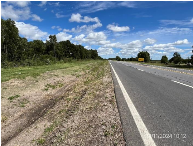
Foto 12.2-3, Ruta 23. Cuneta y faja pública con pendientes adecuadas y tapiz vegetal en crecimiento.
