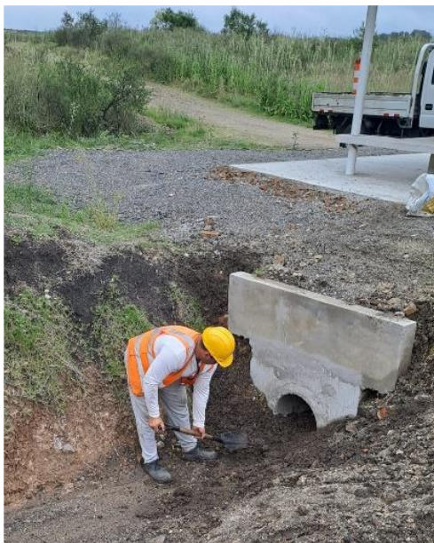
Foto 12.3-3, P07. Ruta 23 progresiva 120K000 senda a (-). Se reconfirmaron las pendientes a la salida de la alcantarilla.
