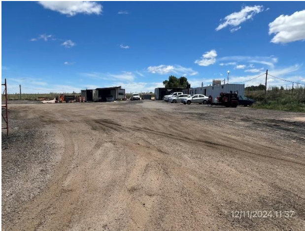
Foto 12.1-1, P03. Obrador y planta asfáltica de José Cujó S.A. Padrón 24448 de la 5ª. SC de Colonia. Vista general.
