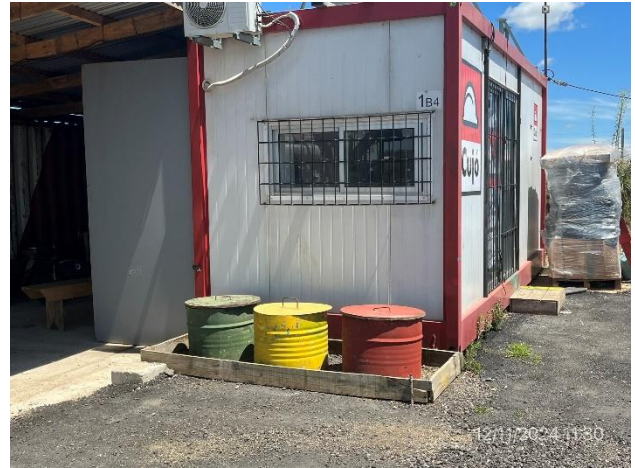
Foto 12.1-2, P03. Obrador, estación de acopio transitorio de residuos segregados por corriente de generación.
