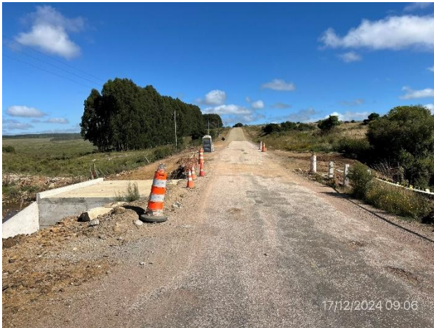
Foto 12.2-7, P07. Alcantarilla tipo Z construida. Ruta 12 progresiva 360K800
