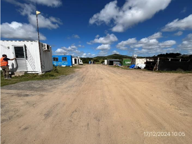
Foto 12.1-1, P03. Obrador. Padrón 3809, 4ª SC de Maldonado. Ruta 12 progresiva 374K800 a (+).
