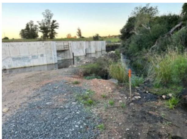
Foto 12.4-5, P01. Ruta 12 progresiva 374K650. Alcantarilla H, se demarcó la cota de máxima inundación.
