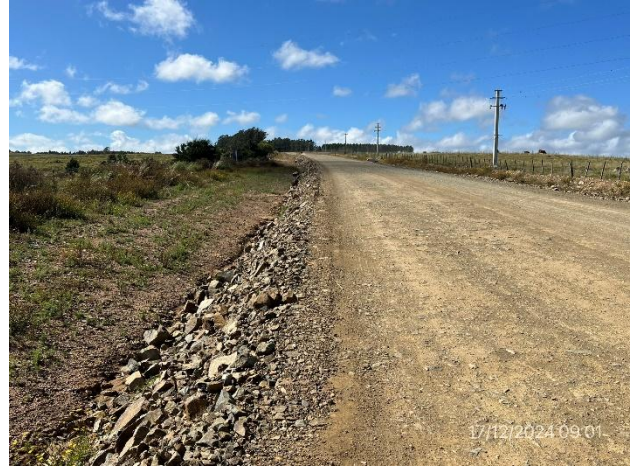
Foto 12.2-2, Ruta 12. Tramo con ensanche y recargo granular ejecutado. Drenajes correctos.
