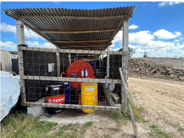
Foto 12.1-5, P03. Obrador, sector techado y con envallado impermeable y bandejas para alojar combustibles.
