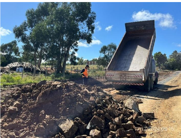
Foto 12.2-5 .P05, Frente de obra, aporte de material granular desde cantera
