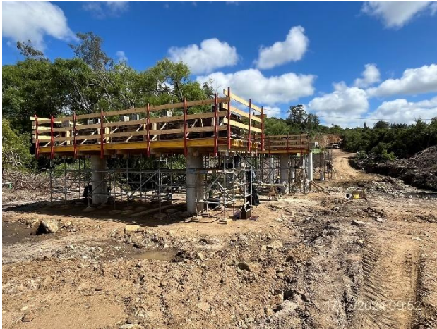
Foto 12.3-1, P06. Puente en construcción sobre A° Mataojo. Ruta 12 progresiva 373K100.
