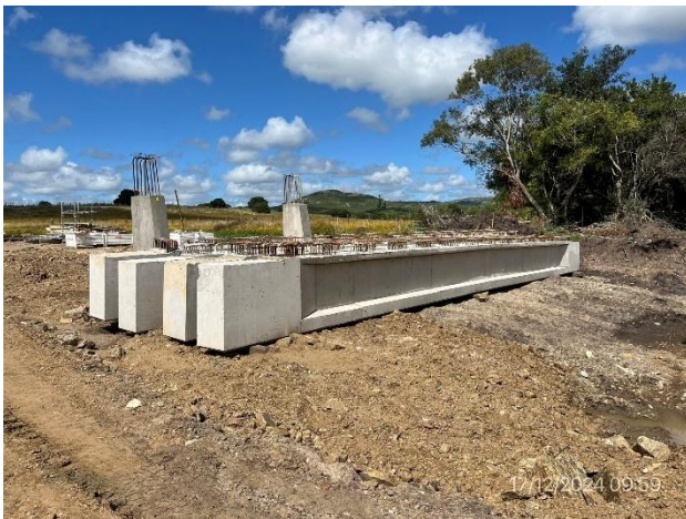
Foto 12.3-3, P06. Acopio de vigas prefabricadas.
