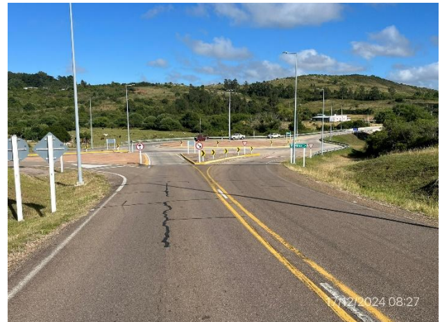
Foto 12.2-10, P02. Fin de tramo. Ruta 12 progresiva 351K910, empalme con Ruta 60.
