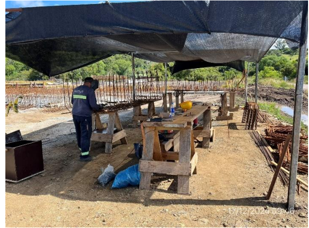
Foto 12.3-8, P06. Obrador de Ventus SA. Banco de fabricación de armaduras, buenas condiciones de limpieza
