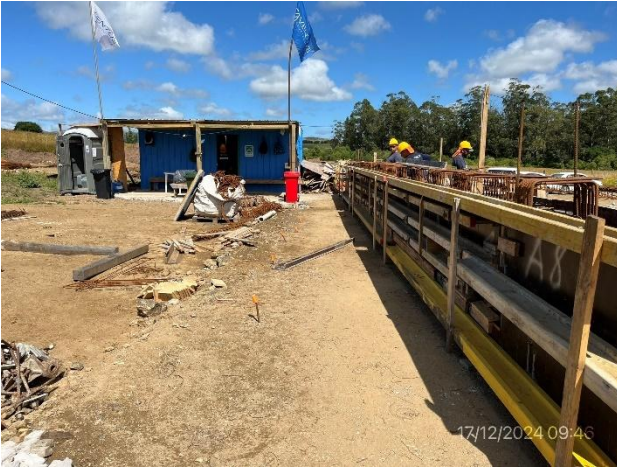
Foto 12.3-7, P06. Obrador de Ventus SA. Ruta 12 progresiva 373K100
