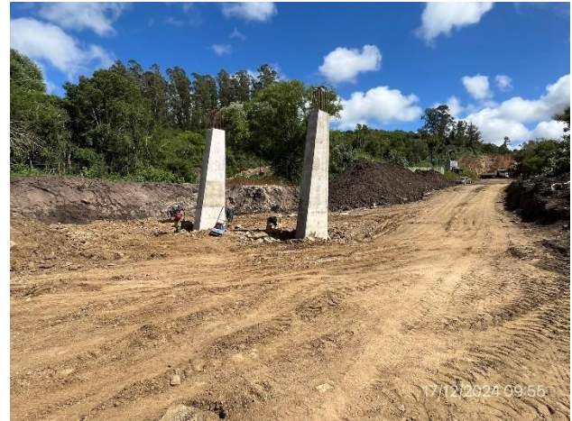
Foto 12.3-2, P06. Pilas de estribos construidas sobre ataguía granular
