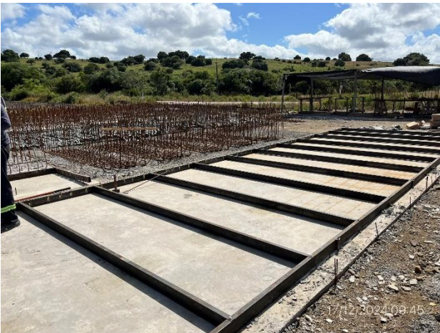
Foto 12.3-9, P06. Obrador de Ventus SA. Explanada de prefabricación de hormigón.
