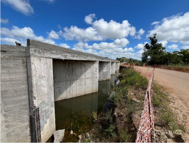
Foto 12.2-1, P01. Inicio de tramo. Variante sobre A° Canelones, alcantarilla H. Ruta 12 progresiva 374K650.
