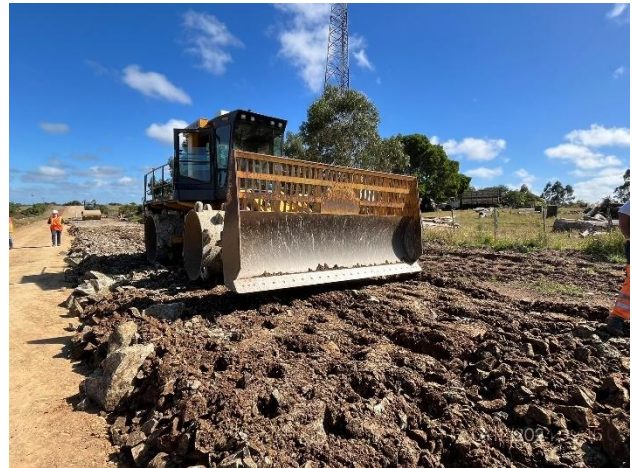
Foto 12.2-4, P05, Frente de obra de recargo granular. Ruta 12 progresiva 363K600.
