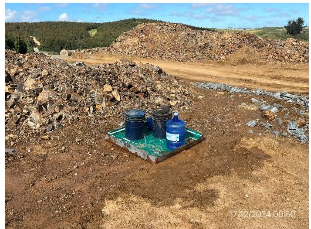
Foto 12.1-12, P04. Cantera, bandeja impermeable para alojar tarrinas de lubricantes, sin tapa.
