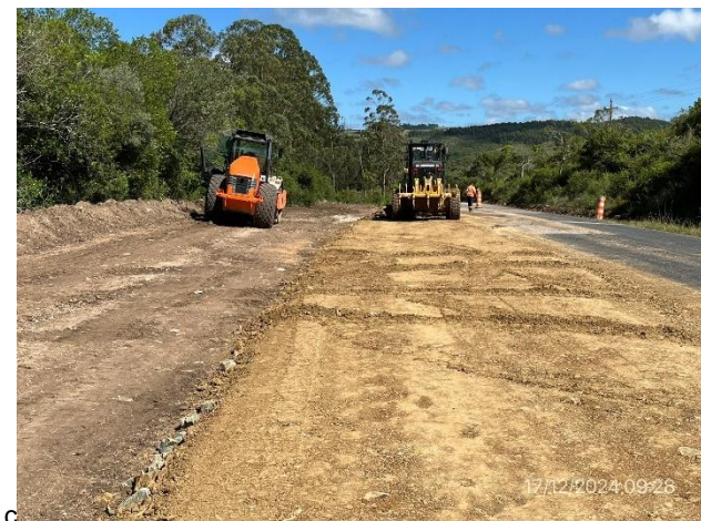
Foto 12.2-6, P05. Frente de obra, compactación y perfilado en construcción.
