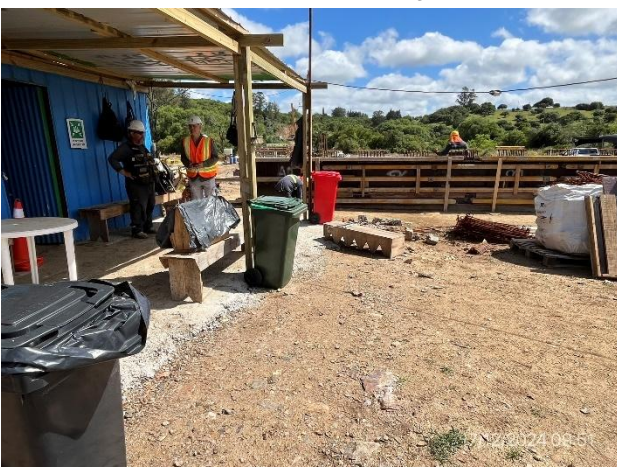
Foto 12.3-11, P06. Obrador de Ventus SA. Sector de acopio de encofrados, buenas condiciones de orden y limpieza.
