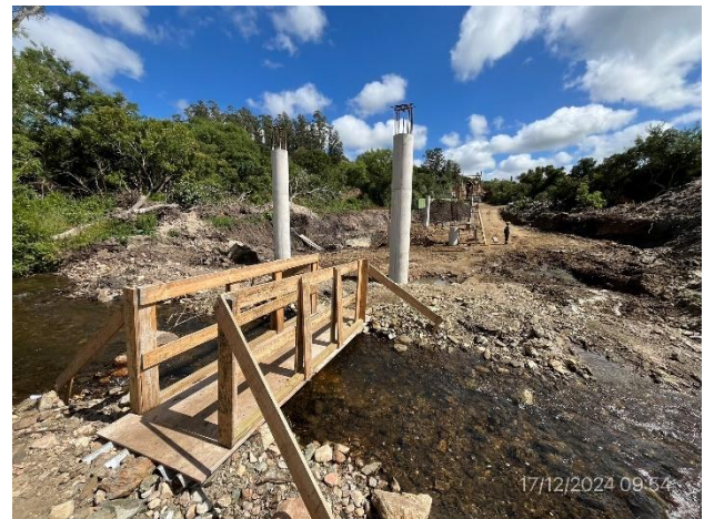
Foto 12.3-4, P06. Curso del A° Canelones limpio, sin presencia de ROCs
