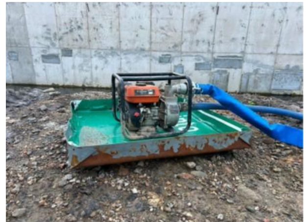
Foto 12.4-4, P07. Se instaló bandeja bajo motobomba.
