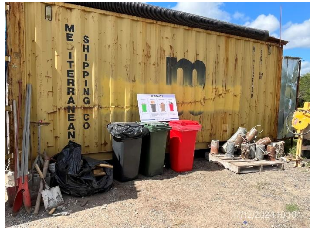
Foto 12.1-6, P03. Obrador, tarrinas para gestión de residuos segregados por origen y corriente de generación.
