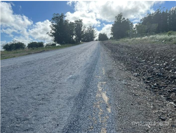
Foto 12.2-3, Ruta 12. Tramo con ensanche y recargo granular ejecutado e imprimado.
