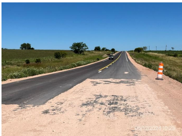
Foto 12.1-11, P02. Fin de tramo, Ruta 90 progresiva 33K000.
