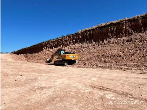
Foto 12.2-1, P04. Cantera de balasto. padrón N°6561,2ª S.C. de Paysandú. Ruta 90 progresiva 24K900 a (+).
