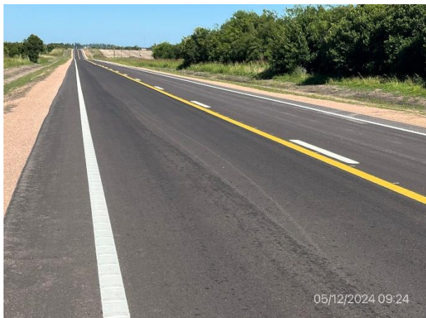
Foto 12.1-9, Ruta 90. Tramo reacondicionado, con ensanche de calzada realizado y obras de señalización horizontal terminadas.
