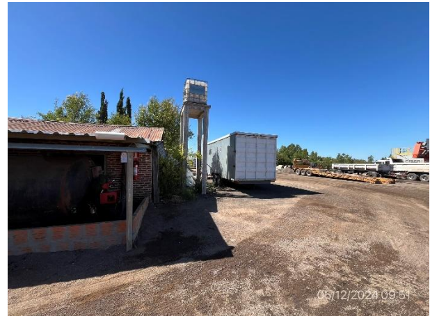
Foto 12.2-16, P03. Obrador, tanque de agua no potable.
