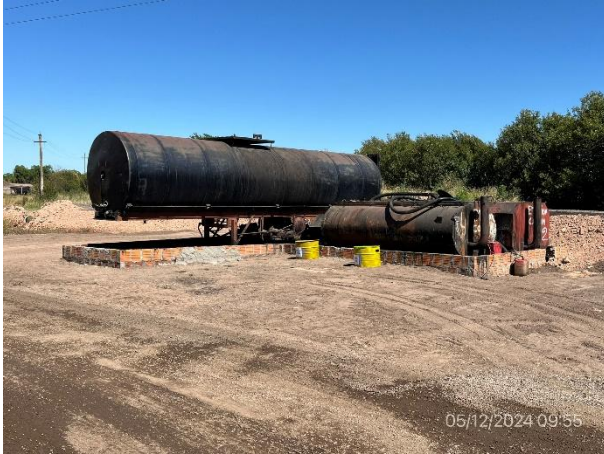
Foto 12.2-7, P03. Planta asfáltica, cisternas de emulsión con envallados perimetrales correctos.
