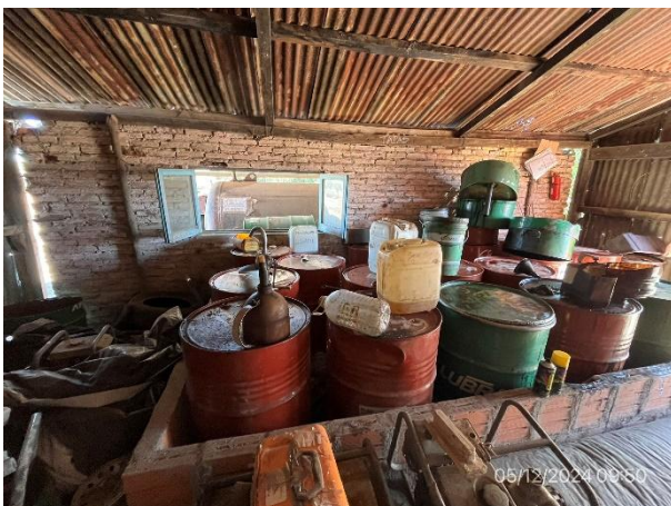
Foto 12.2-11, P03. Obrador, recinto cerrado techado y envallado para alojar tarrinas con hidrocarburos. Una tarrina de keroseno está alojada fuera del recinto.
