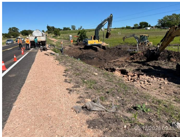
Foto 12.1-4, P08. Frente de obra, alargue de alcantarilla en ejecución. Ruta 90 progresiva 16K000 a (-).
