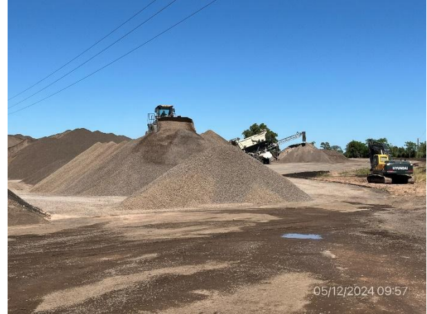
Foto 12.2-8, P03. Planta asfáltica, explanada para maniobras y acopio de áridos.
