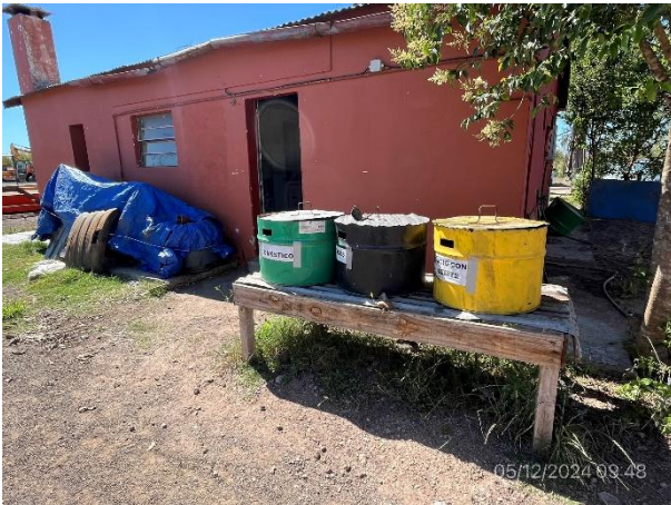
Foto 12.2-15, P03. Obrador, estación para acopio temporal de residuos segeados por corriente de generación.
