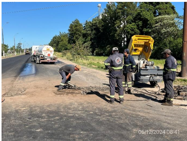
Foto 12.1-3, P07. Frente de obra. No está presente la infraestructura para acopio temporal de residuos.
