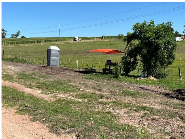
Foto 12.1-5, P08. Frente de obra, servicios de bienestar acordes a normativa.
