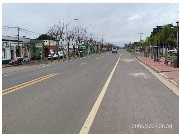
Foto 12.2-11. Obras obligatorias terminadas de Ruta 23 en planta urbana de Ismael Cortinas, obras de señalización culminadas.
