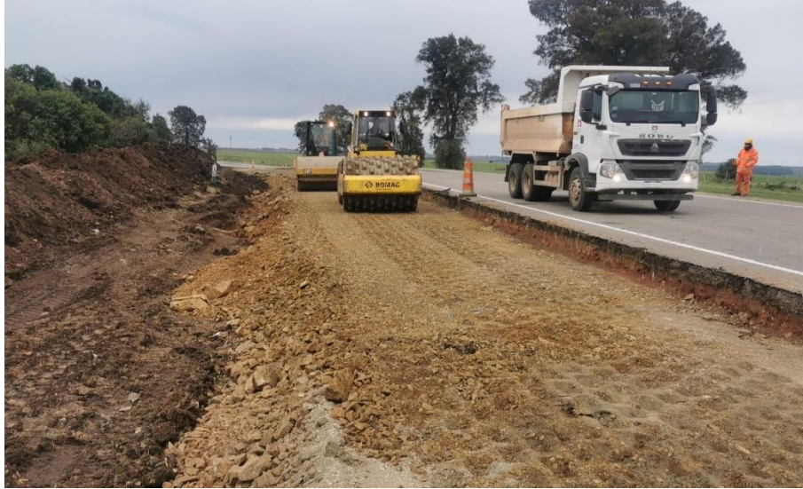
Imagen N°11: Tendido y compactación de subrasante.
