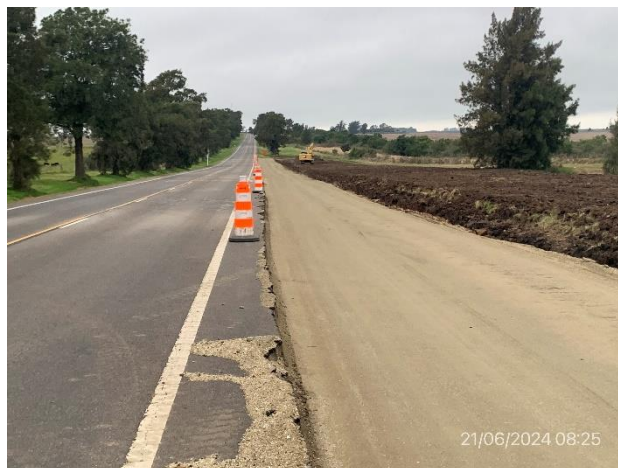
Foto 12.2-8, P06. Frente de obras, ejecución de terceros carriles, Ruta 23, progresiva 139K000 a (-)
