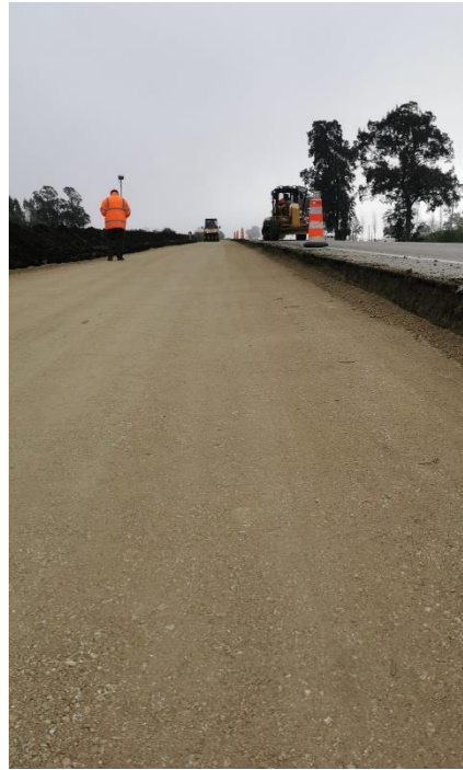
Imagen N°13 y 14: Tendido y compactación de subbase.
