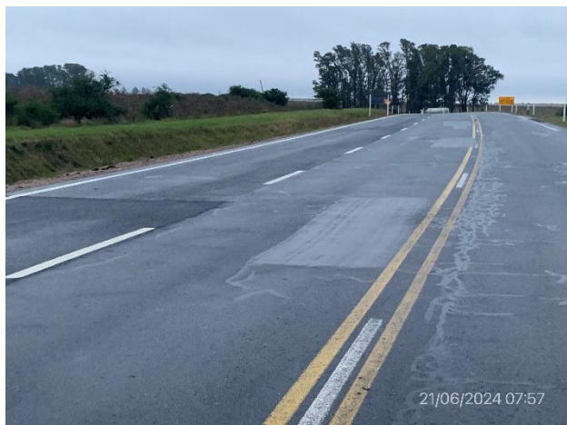
Foto 12.2-7. Sector de Ruta 23, con terceras vías abiertas al tránsito con carpeta asfáltica terminada, senda a (-).
