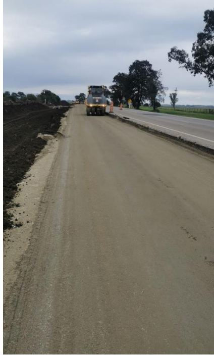
Imagen N°13 y 14: Tendido y compactación de subbase.
