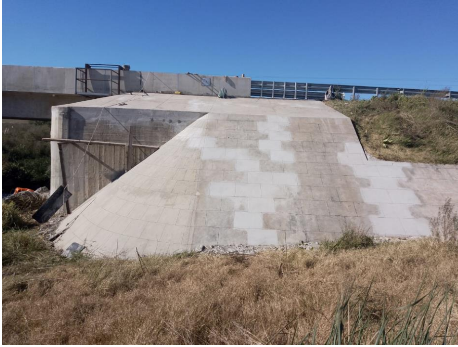
Imagen N°16: Reparación de puentes A° Sauce y A° Encierro.
