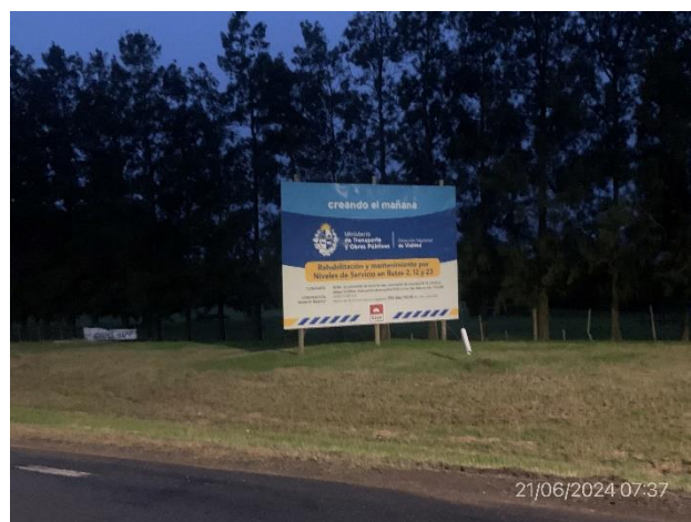
Foto 12.2-1, P01. Inicio de obra, Ruta 23, progresiva 100K000, empalme con Ruta 11.
