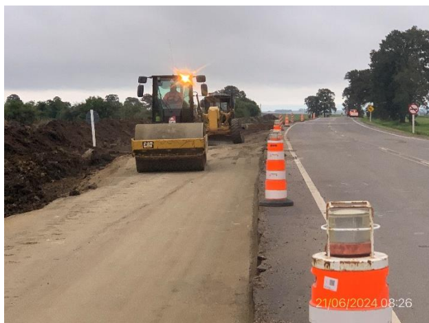
Foto 12.2-9, P06. Ensanche y compactación de base granular para terceros carriles en ejecución.
