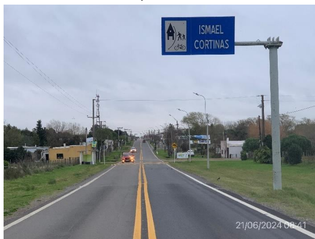
Foto 12.2-12, P02. Fin de obras en Ruta 23, progresiva 152K200, acceso Este a Ismael Cortinas.
