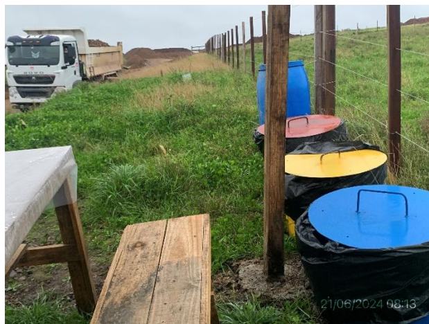
Foto 12.1-12, P04. Estación de acopio temporal de residuos en buenas condiciones, para segregación por corriente de generación.
