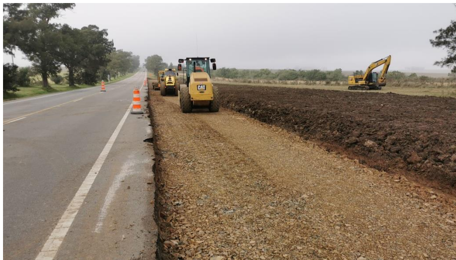
Imagen N°10: Ejecución de subbase ensanche 9.
