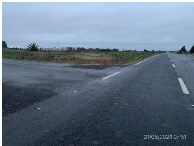
Foto 12.2-3, P05. Empalme con camino municipal terminado. Ruta 23, progresiva 118K600 a (+).
