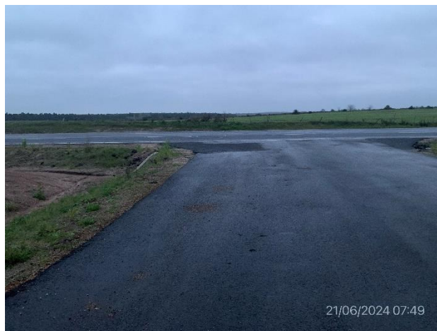
Foto 12.2-4, P05. Altimetría corregida y empalme rectificado.
