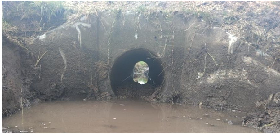
Imagen N°9: Mantenimiento de alcantarillas obstruidas.
