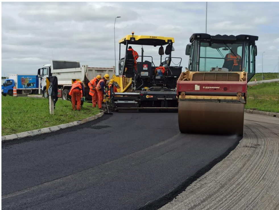
Imagen N° 11: Carpeta asfáltica en la rotonda en ruta N° 81 y 33.
