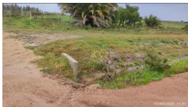
Foto 12.1-1 Erosión en entorno de alcantarilla.
