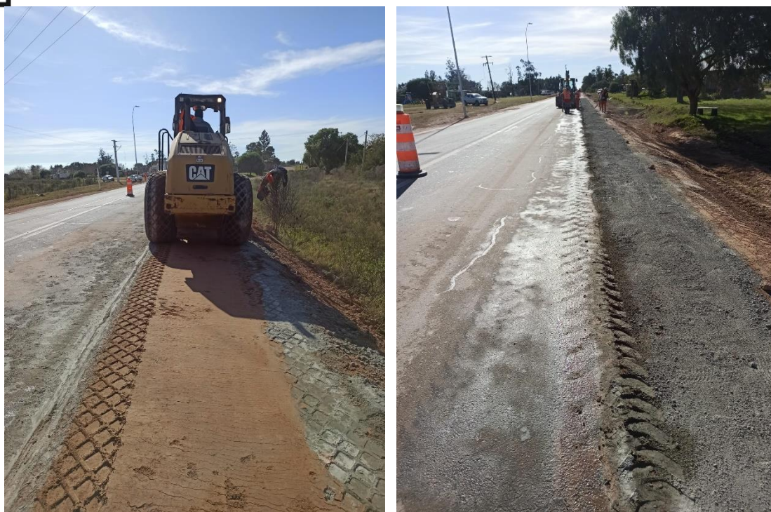
Imagen N° 15 y 16: Estabilizado con cemento de banquetas.
