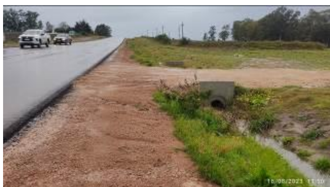
Foto 12.1-1 Erosión en entorno de alcantarilla.
