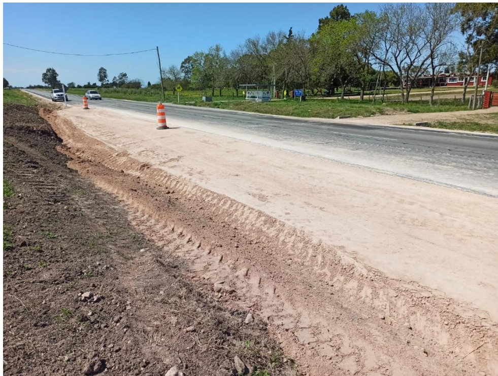
Imagen N° 10: Dársena para refugio peatonal frente a escuela N°74.
