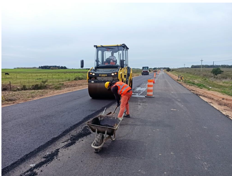
Imagen N° 13 y 14: Ejecución de Carpeta asfáltica.
