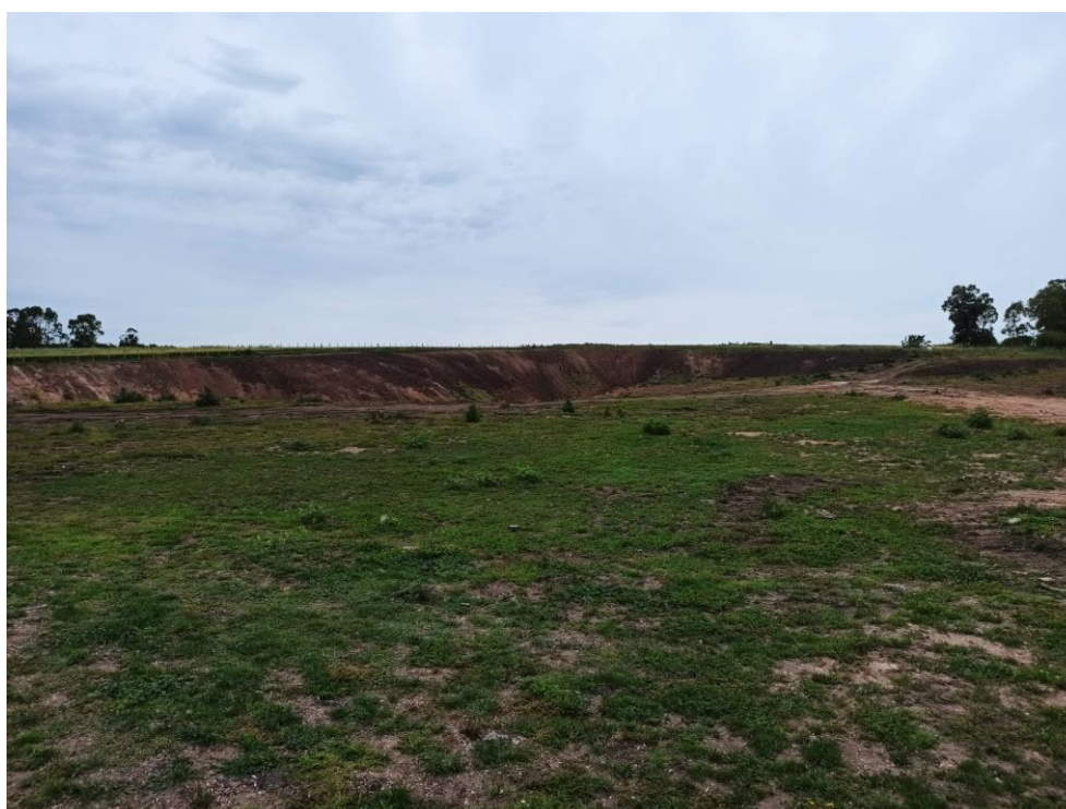
Imagen N°3: Adecuación de taludes en Cantera padrón N° 17653.
