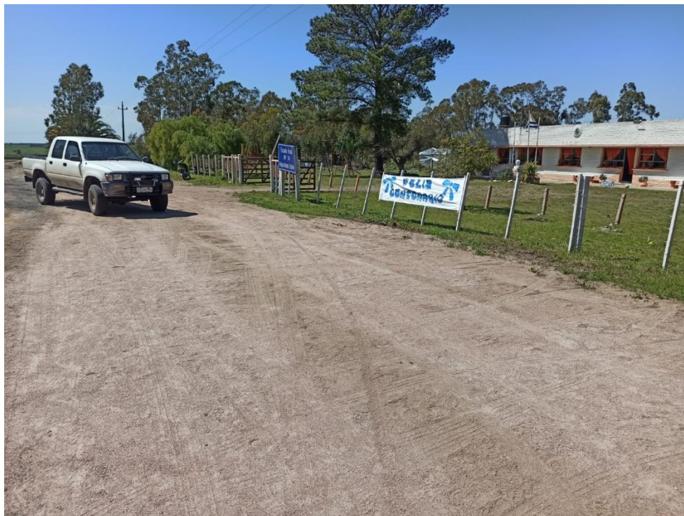
Imagen N° 9: Regularización de estacionamiento con material granular en escuela N°74.
