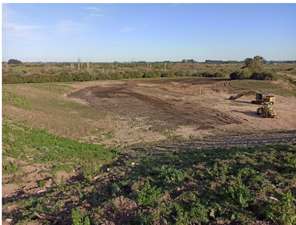
Imagen N°2: Adecuación de taludes en Cantera padrón N° 4108.
