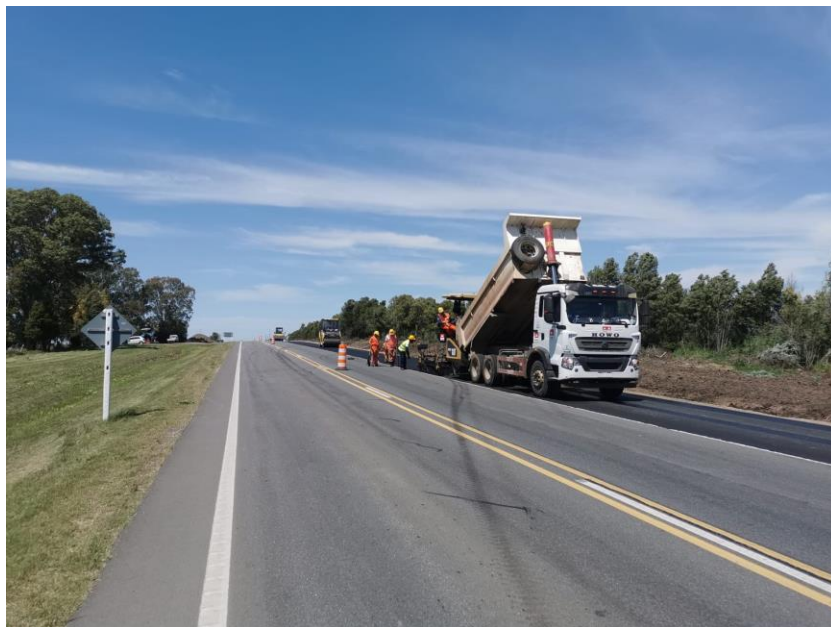
Imagen N°7: Imprimación ensanche 1 (progresiva 103900 a 105100).
