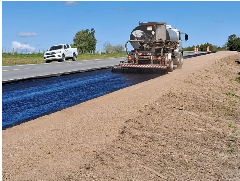
Imagen N°7: Imprimación ensanche 1 (progresiva 103900 a 105100).
