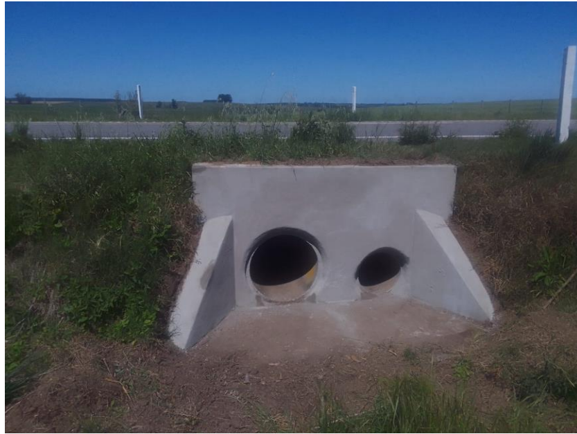
Imagen N°13 y 14: Adecuación de alcantarillas que estaban con roturas.
