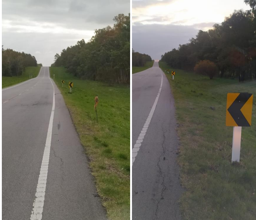
Imagen N°11 y 12: Sustitución de chevrones rotos.
