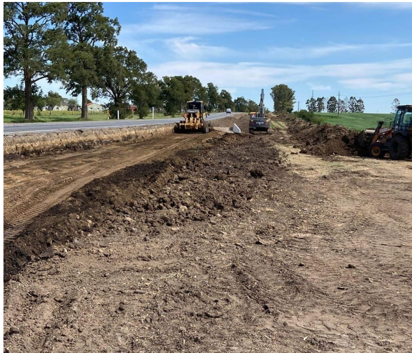
Imagen N°15: Conformación de la subrasante 3er carril.
