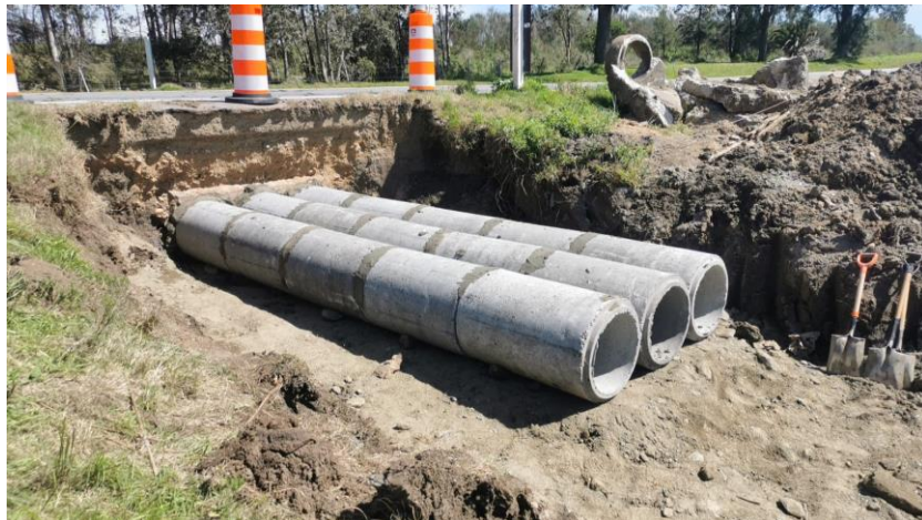
Imagen N°17: Alargue de alcantarillas en los terceros carriles.
