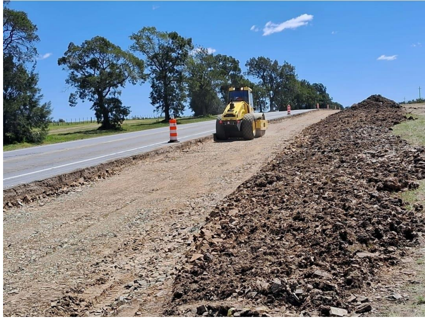
Imagen N°16: Tendido de Subbase.
