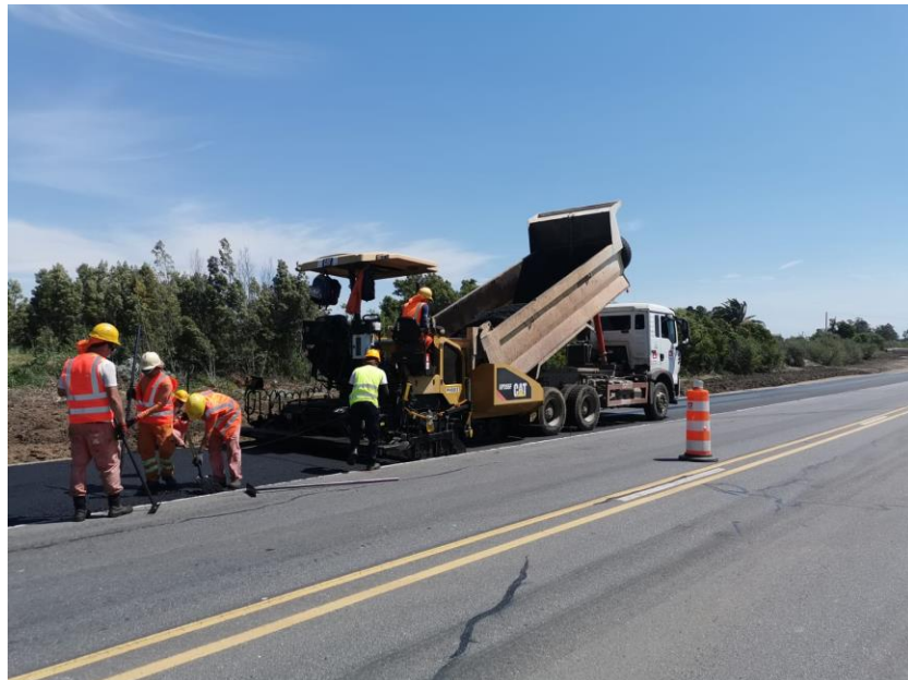
Imagen N°8, 9 y 10: Carpeta asfáltica ensanche 1 (progresiva 103900 a 105100).
