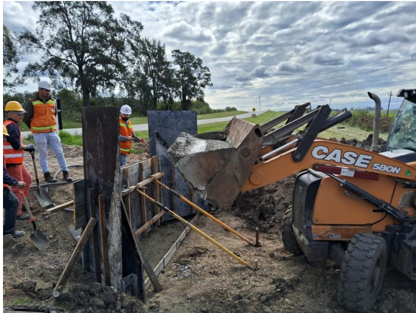
Imagen N°18: Construcción de cabezales de alargues de alcantarillas.
