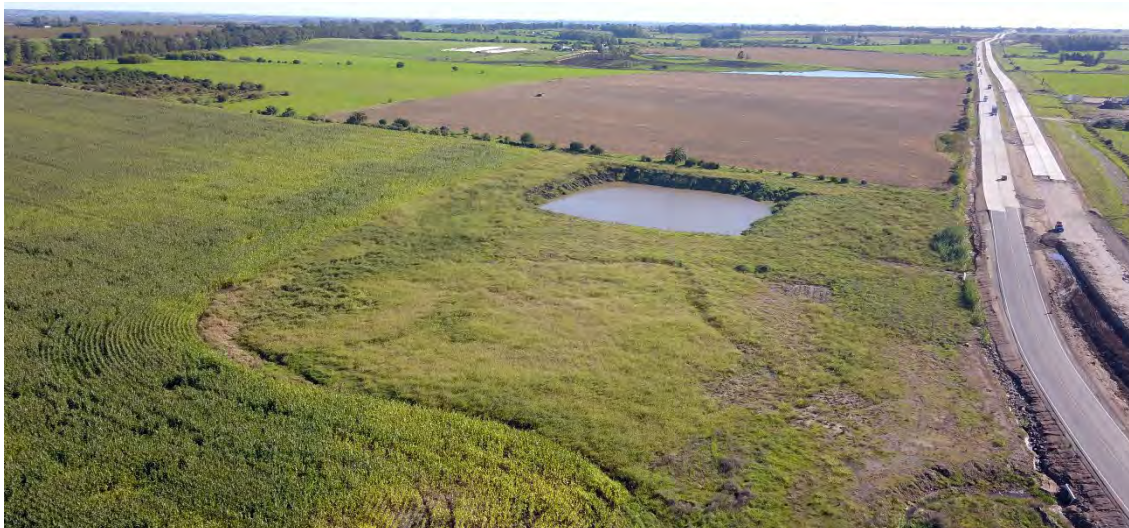
Foto 6. Vista de la cantera de Sur a Norte. En primer plano abajo a la derecha se distingue zona rehabilitada.
