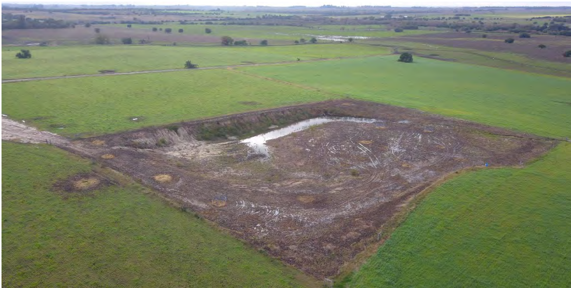
Foto 6. Condición de cierre (rehabilitación parcial).
