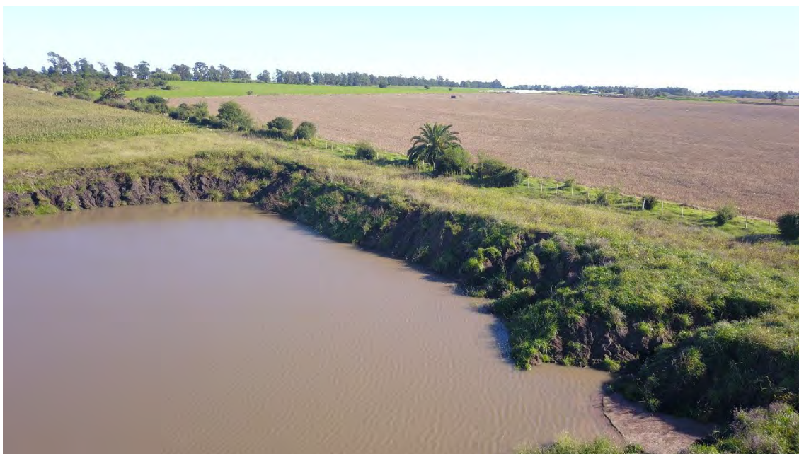
Foto 8. Situación de los taludes perimetrales. A medida que la vegetación se extiende completamente irá disminuyendo el riesgo de avance de los surcos de erosión.
