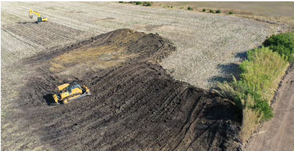
Cantera en operaciones de destape (7 de febrero del 2023).
