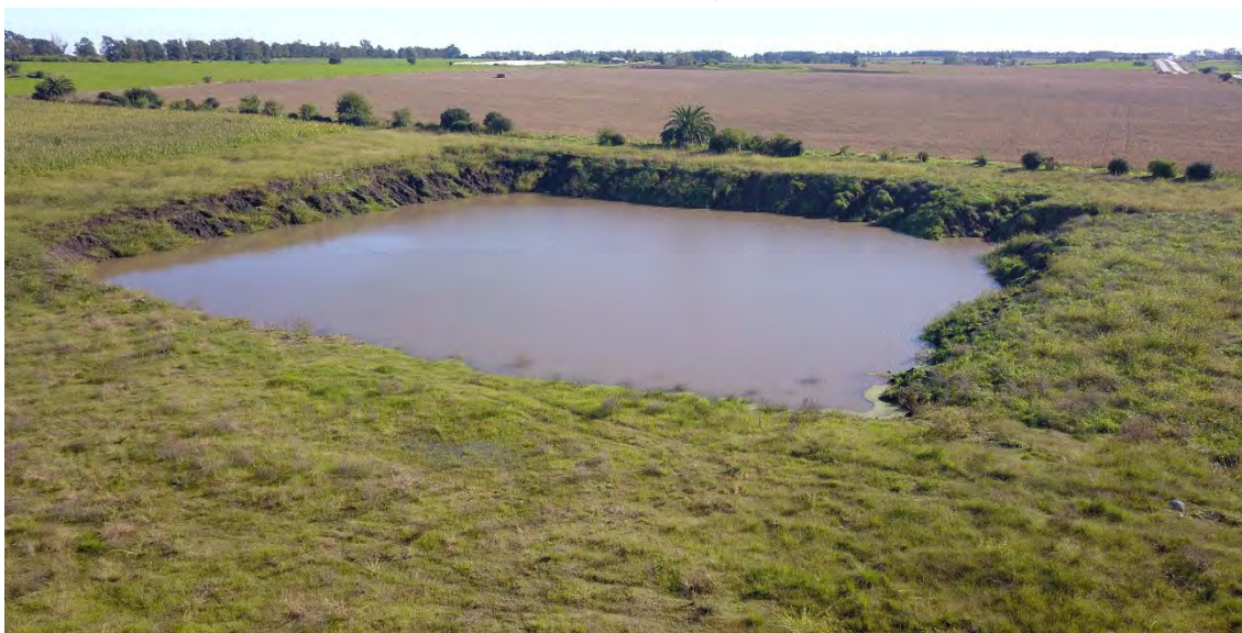
Foto 7. Zona de descarga de excesos del depósito de agua superficial. Sin riesgos de movimiento en masa de suelos hacia el curso receptor.
