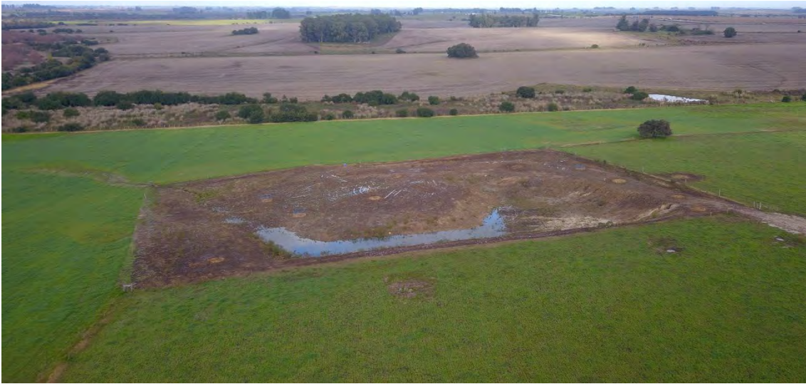
Foto 1: Situación de cierre de la cantera (rehabilitación parcial con depósito de agua superficial remanente).
