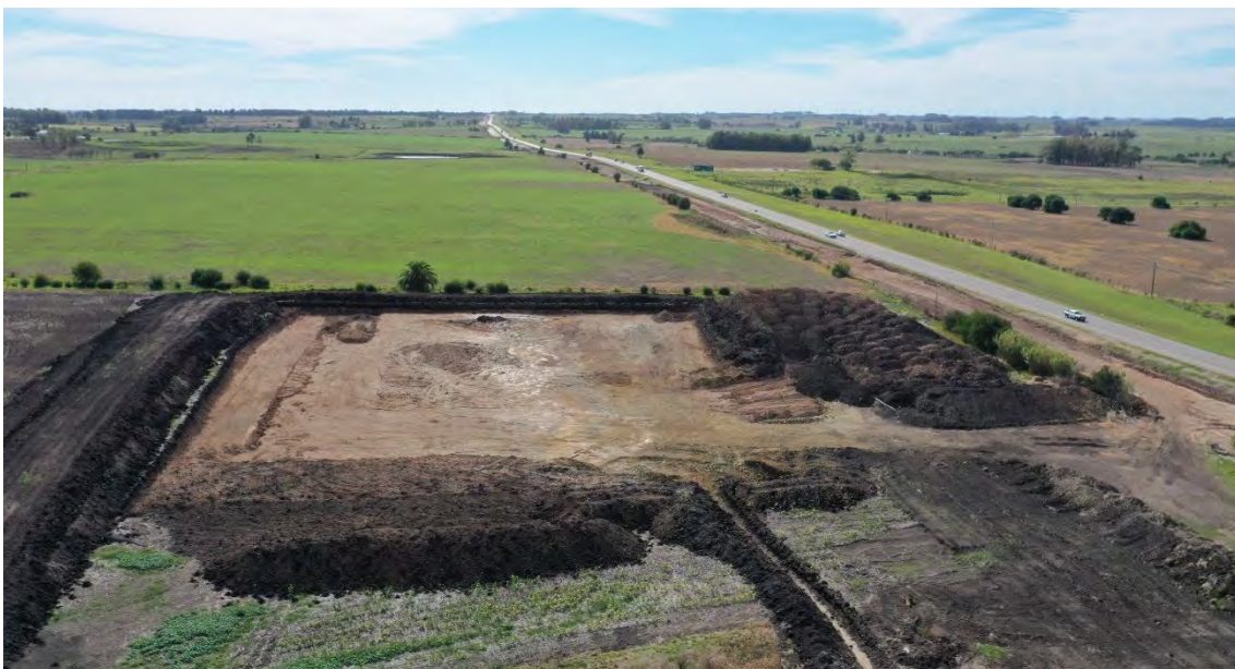
Vista de la cantera de Sur a Norte una vez finalizadas las tareas de destape y antes de comenzar la extracción de material útil.
