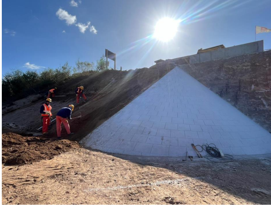
Ilustración 9: Ejecución del cuarto de cono del puente.
