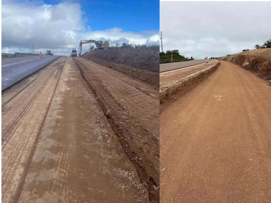
Ilustración 11 y 12: Ensanche del tercer carril en lado norte del puente.
