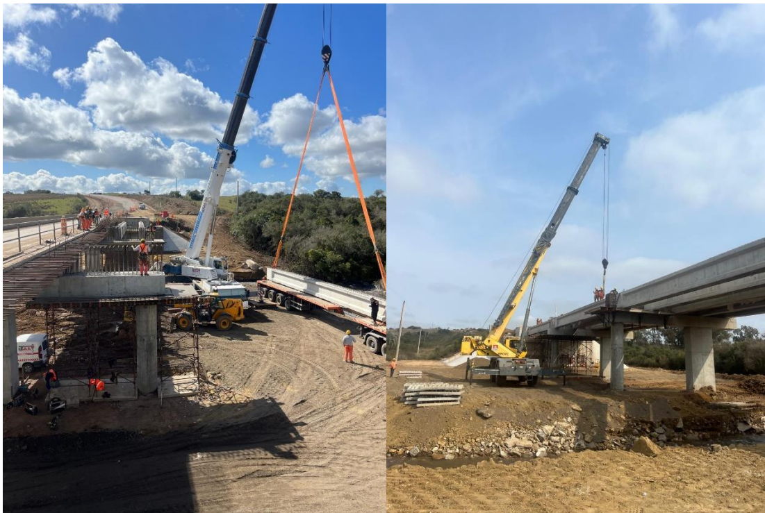
Ilustración 13 y 14: Montaje de vigas y losetas del puente.
