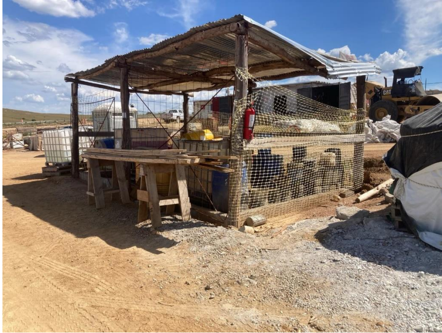
Ilustración 5: Recinto de Productos químicos.
