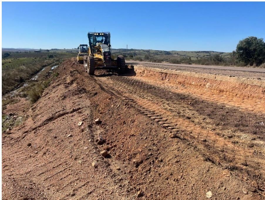
Ilustración 10: Ejecución del tercer carril.
