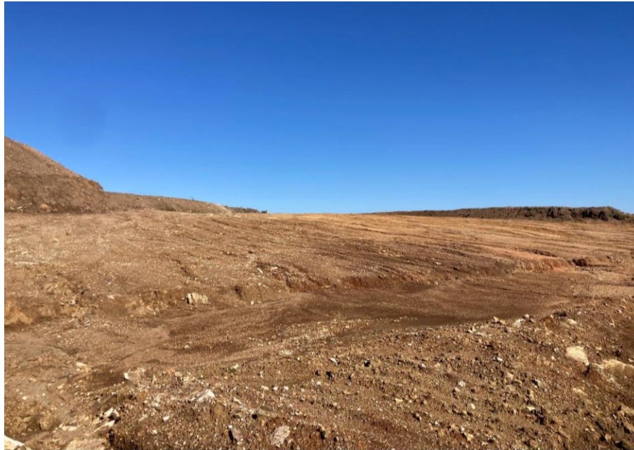
Ilustración 7: Vista de la cantera de obra pública utilizada para la obra.
