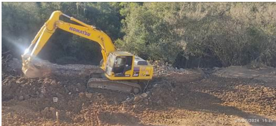
Foto 12.2-1 Explanada extendida sobre vegetación del entorno de obra.
