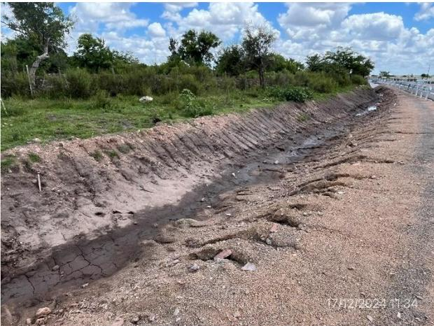
Foto 12.1-9, Ruta 81. Sector de faja pública con talud erosionado.
