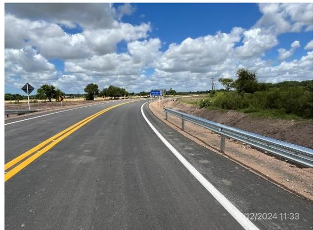
Foto 12.1-6, P01. Acceso Sur en mezcla asfáltica a nuevo puente de Ruta 81 sobre A° Solís Grande.
