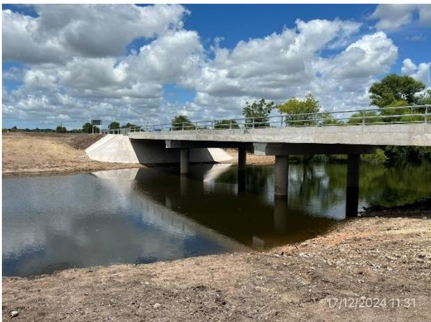
Foto 12.1-5, P01. La ataguía granular fue retirada. El curso recuperó sus condiciones naturales de escurrimiento.
