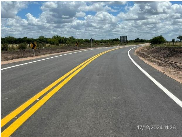
Foto 12.1-3, P01. Acceso Norte en mezcla asfáltica a nuevo puente de Ruta 81.
