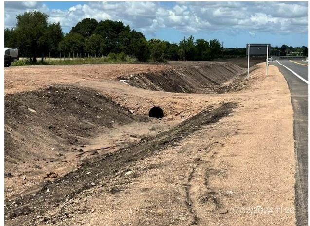
Foto 12.1-10, P02. Obrador abandonado. Se recuperaron las pendientes y los drenajes
