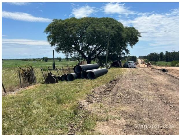
Foto 12.1-6. P04. Campamento provisorio. Acopio de tuberías para alcantarillas.
