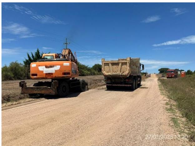
Foto 12.1-3. P04, frente de obra. Perfilado de recargo granular en ejecución, procedimientos apegados al PGA.
