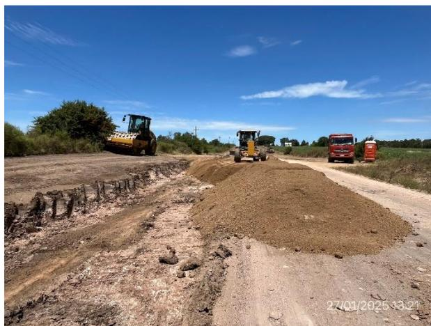
Foto 12.1-4. P04, frente de obra. Recargo granular y compactación en ejecución.
