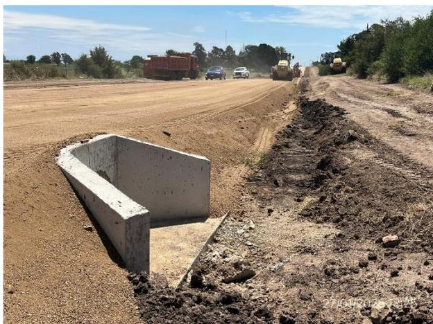
Foto 12.1-5. P04, frente de obra. Alcantarilla construida.
