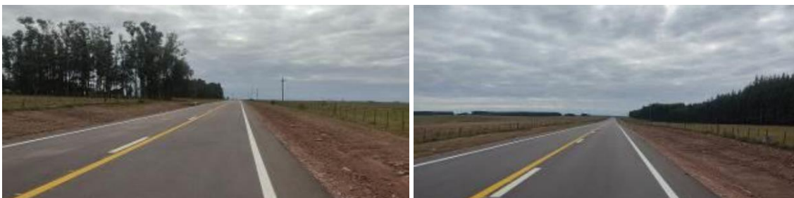
Imágenes del tramo de Obra
