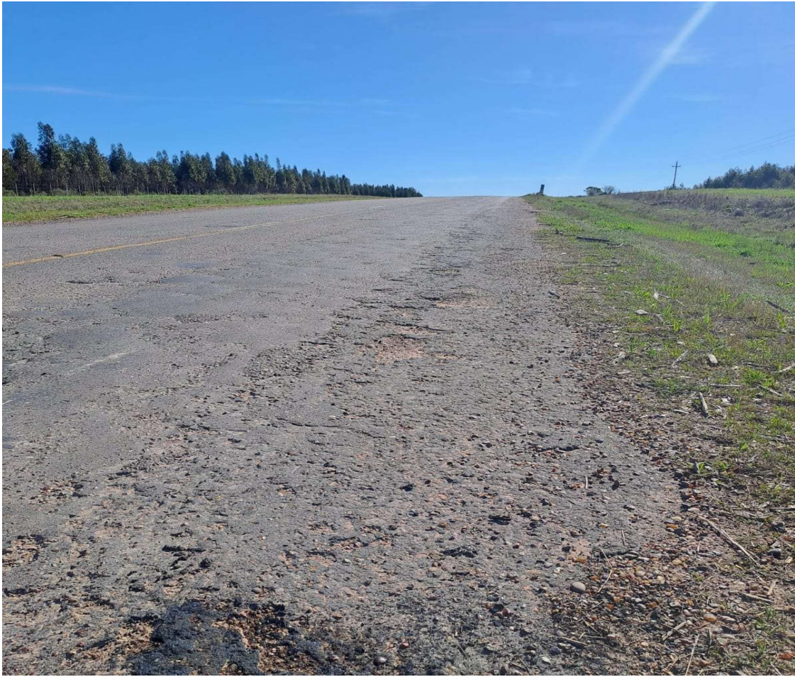
Tramo 313km000 al 48km000
