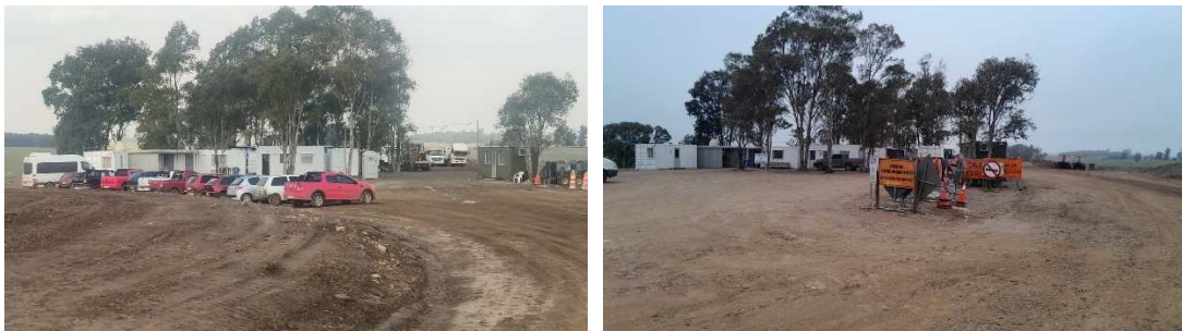
Imágenes de la implantación del obrador
