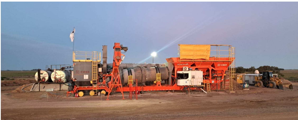
Imágenes de la implantación de la planta asfáltica
