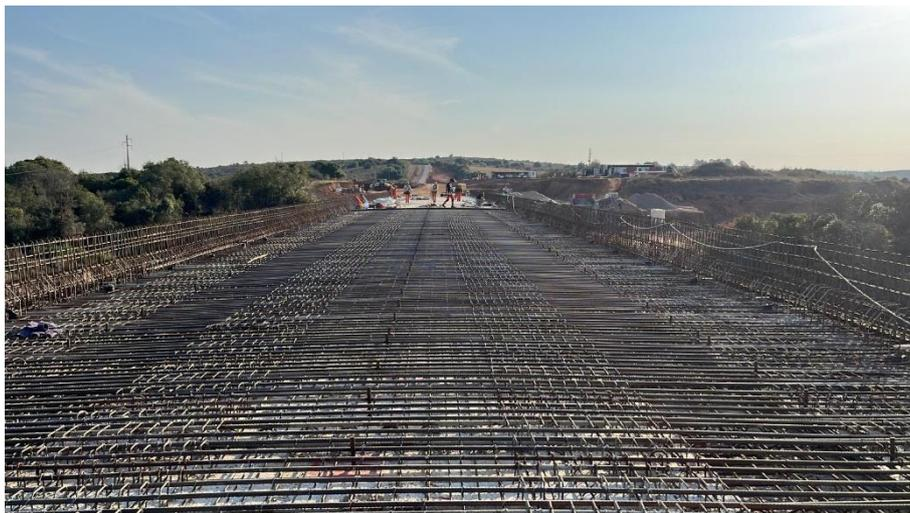
Imágenes N°13: Armado de losa del tablero del puente.
