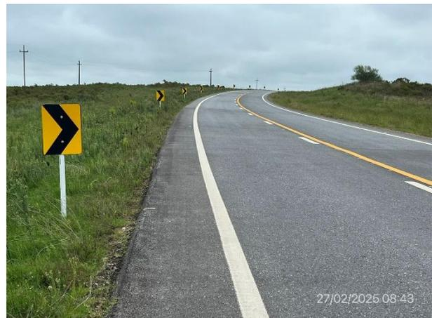
Foto 12.1-4, Obras terminadas en Ruta 6. Señalización horizontal y vertical terminadas.
