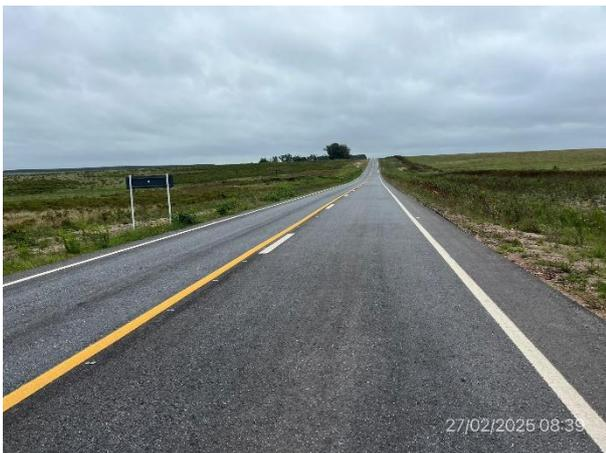
Foto 12.1-3, Obras terminadas en Ruta 6. Ensanche y nueva carpeta de rodadura en mezcla asfáltica ejecutados
