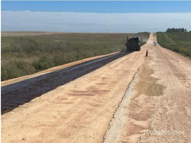
Foto 12.4-7, P06. Frente de obras, imprimado en ejecución.
