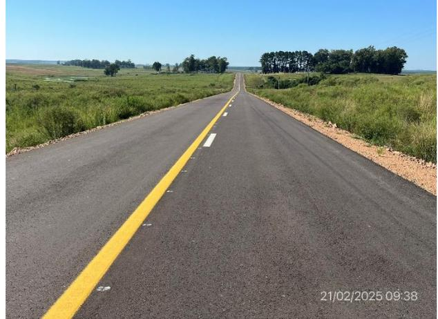
Foto 12.4-2, Ruta 27. Sector con carpeta asfáltica ejecutada y señalización horizontal parcialmente terminada.
