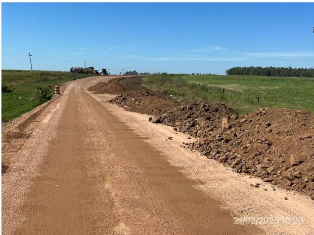
Foto 12.4-5, P06. Frente de obras, recargo granular y ensanche de base en ejecución.
