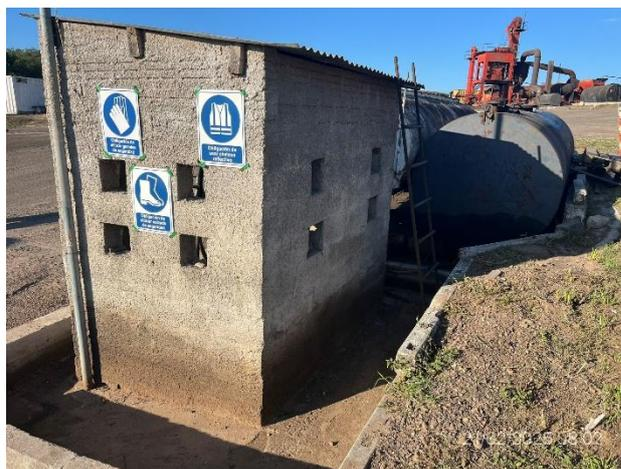
Foto 12.1-4, P03. Depósito de combustible y surtidor de combustible en local envallado.
