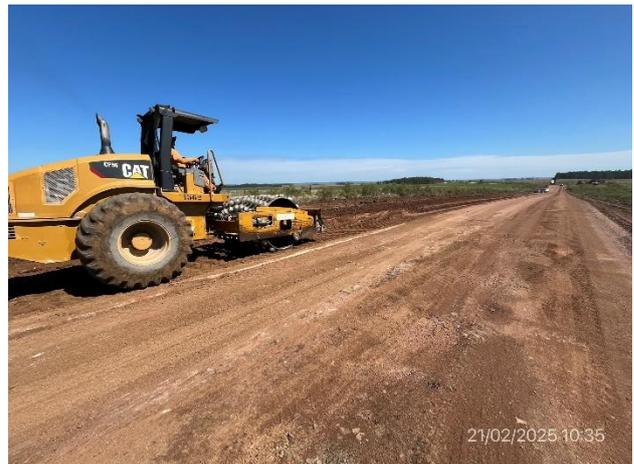
Foto 12.4-6, P06. Frente de obras, compactación de base granular en ejecución.
