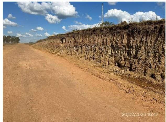
Foto 12.2-4, P07. Talud a conformar, Ruta 6 progresiva 351K300*. Sector con apertura de caja realizada y taludes a conformar.
