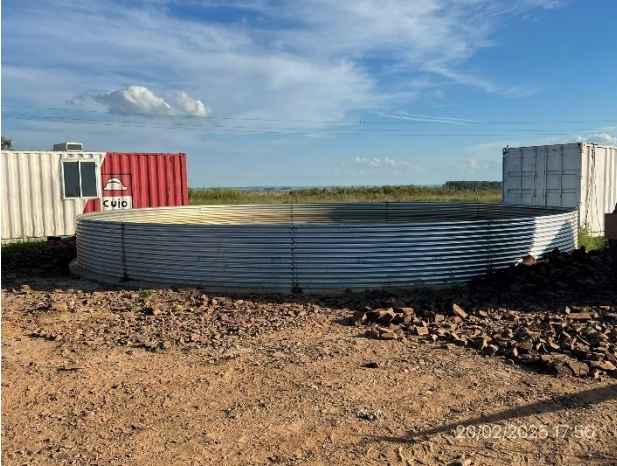
Foto 12.1-7, P03. Obrador, tamar para acopio de agua proveniente de toma autorizada.
