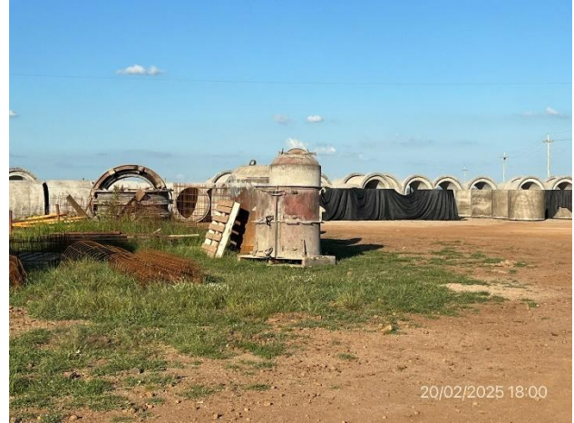
Foto 12.1-8, P03. Obrador, subcontratista Flagery SA. Planta de fabricación de tuberías de hormigón para alcantarillas. Buenas condiciones de orden y limpieza.
