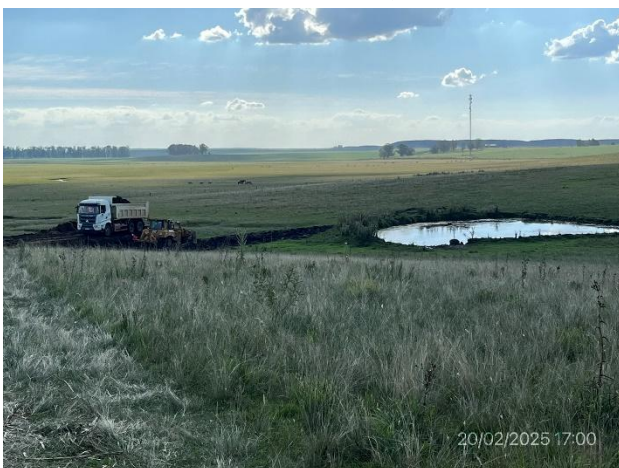
Foto 12.2-11, P06. Frente de obra, depósito de desmontes sobrantes. Padrón Rural N°10801, 12ª S.C. de Tacuarembó. Ruta 6 progresiva 345K200*.
