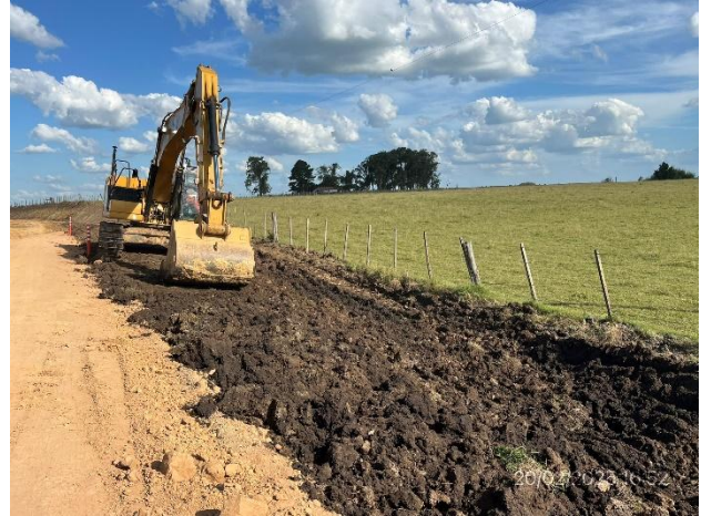
Foto 12.2-8, P05. Frente de obras, Ruta 6 progresiva 345K700*.
