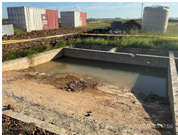
Foto 12.1-6, P03. Obrador, pileta de lavado de camiones mixer en condiciones adecuadas.
