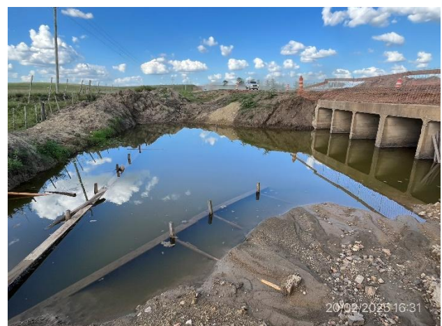
Foto 12.2-6, Ruta 6. Ensanche de alcantarilla en ejecución.
