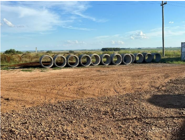
Foto 12.1-9, P03. Obrador, subcontratista Flagery SA. Explanada de acopio de tuberías.
