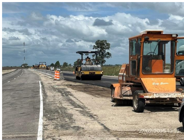
Foto 12.2-6, P07. Frente de obras, tendido de mezcla asfáltica. Ruta 5 progresiva 134K600, senda a (-).
