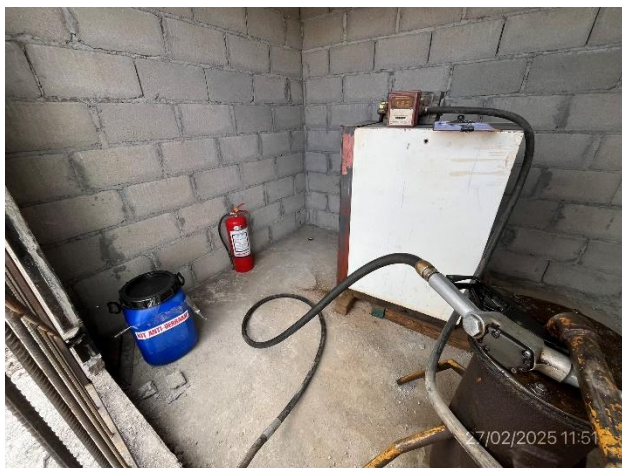
Foto 12.1-3, P03. Obrador, recinto cerrado y techado para alojar surtidor de combustible.
