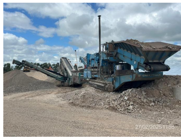
Foto 12.1-18, P04. Cantera de piedra, sector de trituración. Buenas condiciones de orden y limpieza.
