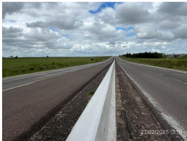
Foto 12.2-2. Ruta 5, tránsito habilitado en senda a (+). Senda a (-) con base negra y viga new jersey central ejecutadas
