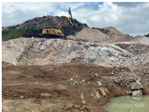
Foto 12.1-16, P04. Cantera de piedra, frente de ataque. Barrenado para próximas voladuras en ejecución.
