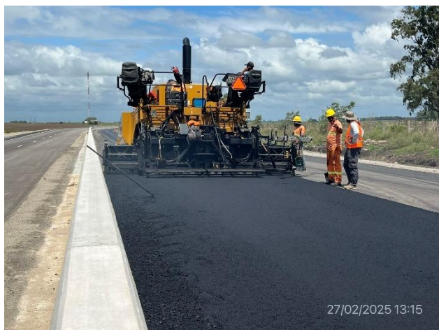
Foto 12.2-9, P07, Frente de obras. Tendido de capa de rodadura en ejecución.
