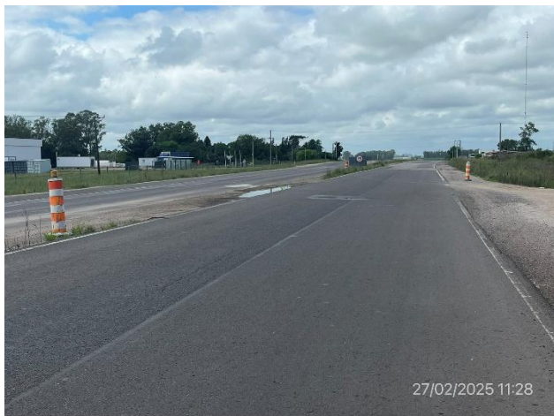
Foto 12.2-1. Inicio de tramo de obra terminado, Ruta 5 progresiva 175K500.
