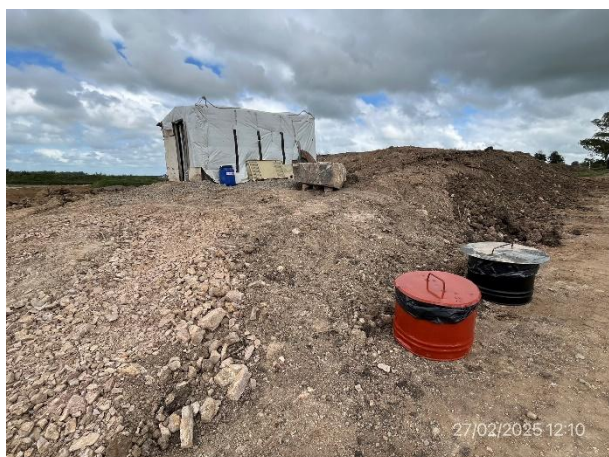
Foto 12.1-17, P04. Cantera de piedra, estación para acopio de residuos segregados por corriente de generación.
