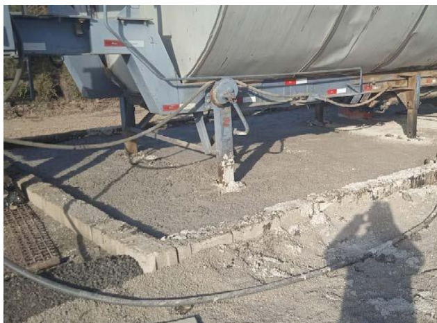
Foto 12.3-5. LA empresa RCA SA reparó el envallado perimetral y retiró los residuos oleosos contaminados.
