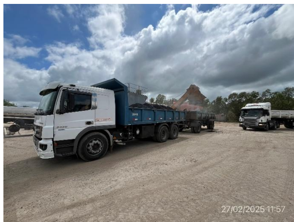
Foto 12.1-14, P03. Planta Asfáltica, explanada de carga y maniobras en buenas condiciones de orden y limpieza, libre de residuos
