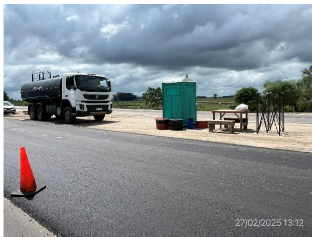
Foto 12.2-8, P07. Frente de obras, está presente la infraestructura para el acopio temporal de residuos.
