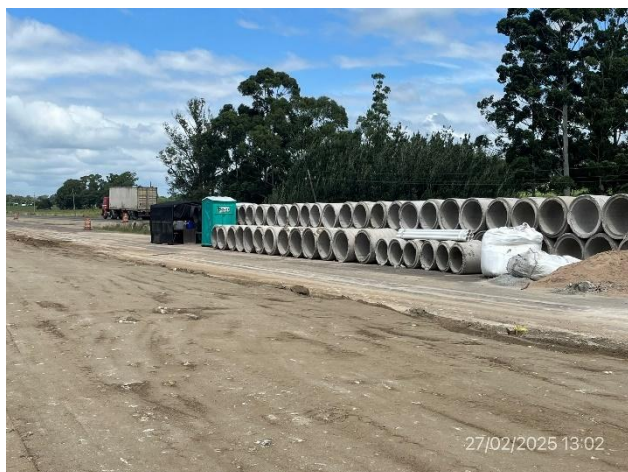
Foto 12.2-7, P07. Frente de obras, campamento móvil. Buenas condiciones de orden.
