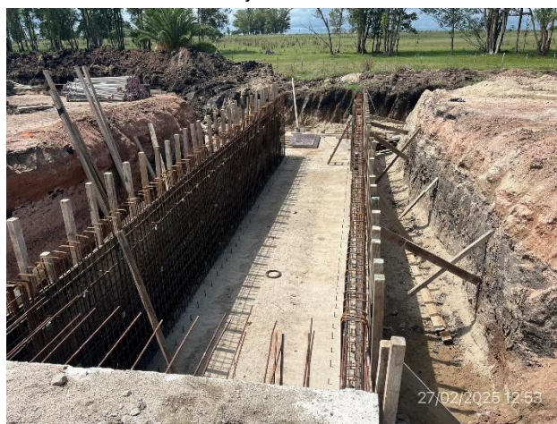
Foto 12.2-4, P08. Frente de obra con actividad suspendida, construcción de alargue de alcantarilla. Ruta 5 progresiva 145K100 a (+).
