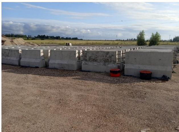
Foto 12.3-3. La empresa RCA SA instaló infraestructura para el acopio temporal de residuos en el sector de prefabricados.
