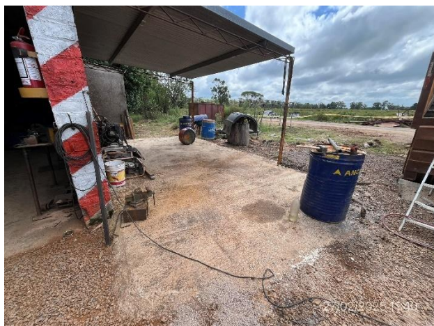
Foto 12.1-7, P03. Taller mecánico, se construyó explanada de trabajo en hormigón para tereas de mecánica.
