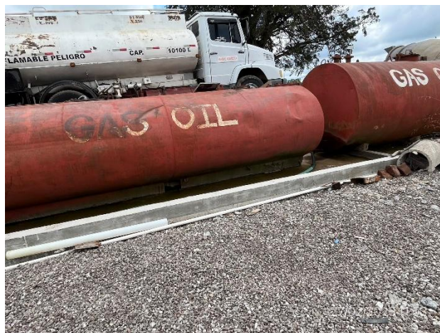
Foto 12.1-4, P03. Obrador, cisterna de combustible en recinto con envallado perimetral.
