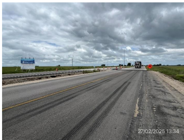
Foto 12.2-10, P02. Fin de tramo. Ruta 5 progresiva 133K500, empalme con contrato CREMAF II.
