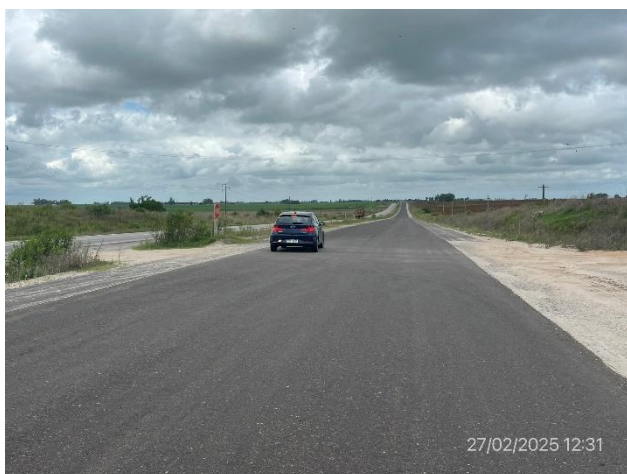
Foto 12.2-3. Ruta 5, senda a (-) con base negra ejecutada. Aún no está abierta al tránsito.
