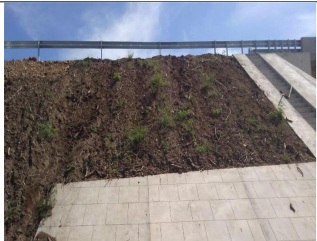
Foto 12.3-2, P01. Reparación de erosiones en taludes lado A+ hacia ruta 5.
