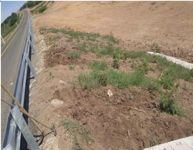
Foto 12.3-1, P01. Reparación de erosiones en taludes lado A- hacia ruta 5.
