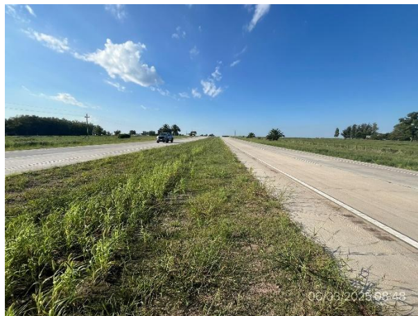
Foto 12.1-2. Ruta 5, cantero central perfilado y cubierto con suelo vegetal.
