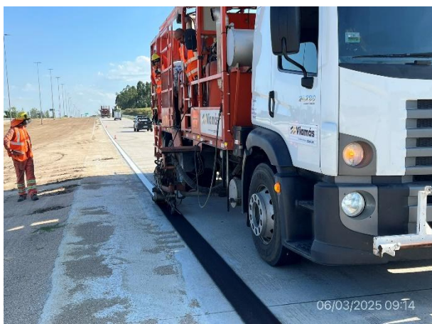
Foto 12.1-9, P11. Buenas condiciones de trabajo, zona libre de residuos.
