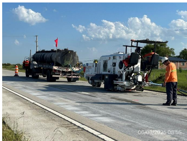
Foto 12.1-8, P11. Equipo de Vialmás SA, de señalización horizontal en ejecución.
