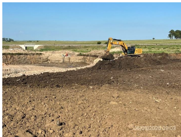
Foto 12.2-14, P04. Se está realizando el tendido de suelo de destape.
