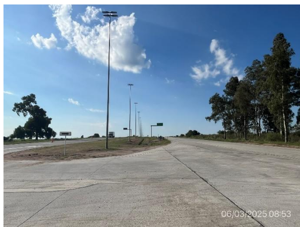
Foto 12.1-4. Retorno ejecutado y obras de iluminación terminadas.
