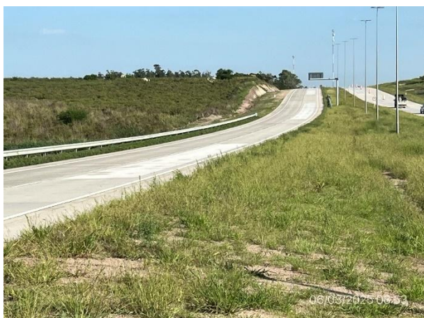
Foto 12.1-3. Ruta 5, las dos sendas están terminadas y abiertas al tránsito.
