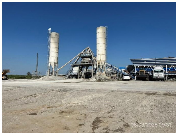
Foto 12.2-2, P03. Planta de hormigón con actividad suspendida. Buenas condiciones de orden y limpieza.
