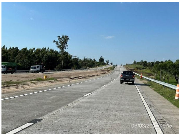
Foto 12.1-5, Ruta 5. Obras de defensas metálicas terminadas.
