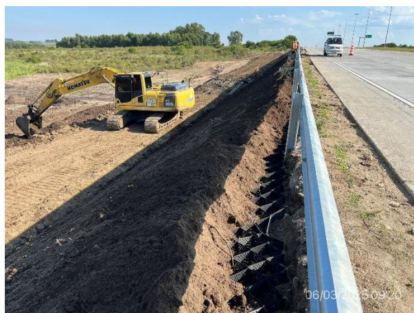
Foto 12.1-10, P12. Frente de obra de recuperación ambiental. Ruta 5 progresiva 115K700, senda a (-).
