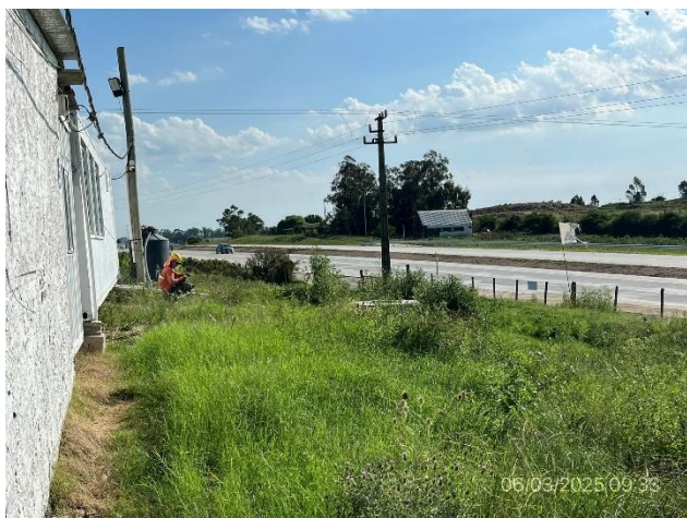
Foto 12.2-5, P03. Obrador, Depósito impermeable para recolección de aguas servidas
