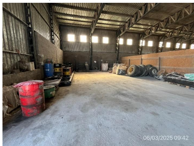
Foto 12.2-10, P03. Obrador, Sector techado y con pavimento impermeable para tareas de mantenimiento mecánico.
