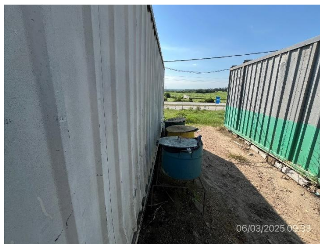
Foto 12.2-4, P03. Obrador, estación de recolección y acopio de residuos segregados por canal de generación.
