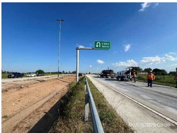
Foto 12.1-7, P11. Frente de obra subcontratista Vialmás SA. Ruta 5 progresiva 116K800, senda a (+).
