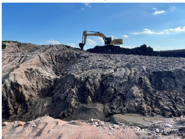
Foto 12.2-15, P04. Se está realizando el suavizado de los taludes en los frentes de ataque.
