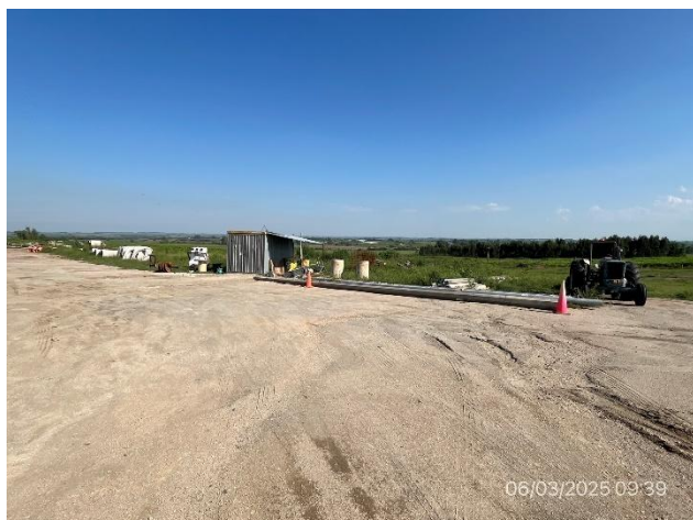
Foto 12.2-7, P03. Obrador, Sector subcontratista Cablex SA. Explanada y zona de trabajo limpias y ordenadas.
