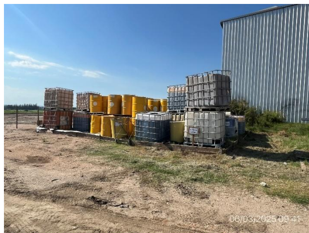
Foto 12.2-8, P03. Obrador, Sector de acopio de productos químicos con envallado correcto
