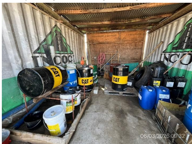
Foto 12.2-9, P03. Obrador, Sector techado y con envallado y pavimento impermeables para acopio de lubricantes usados y residuos peligrosos.
