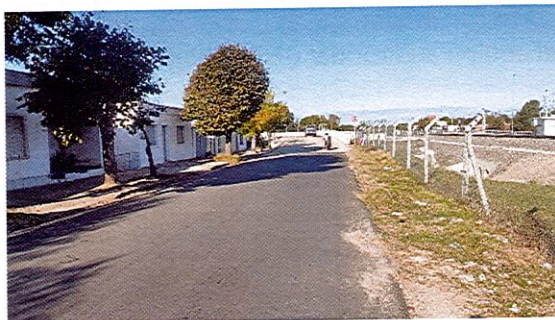
Ilustración 3 Obras terminadas calle 19 de junio
