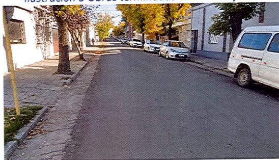
Ilustración 5 Obras terminadas calle José Batlle y Ordoñez
