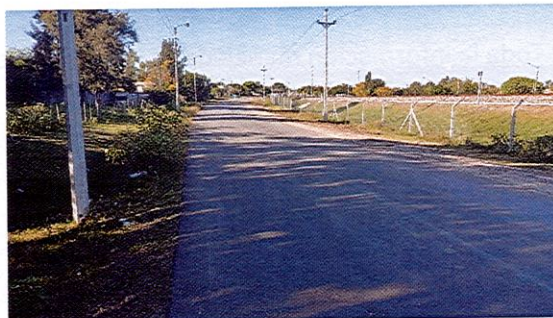
Ilustración 4 Obras terminadas calle 19 de junio
