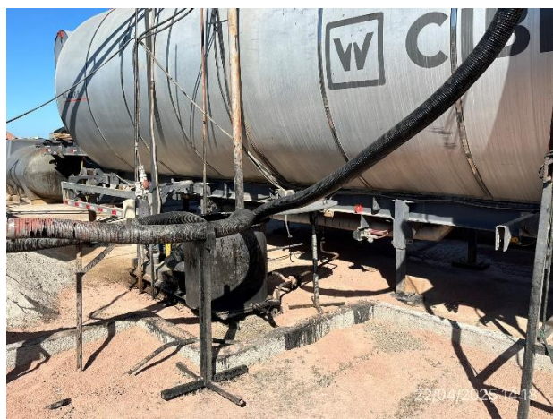
Foto 12.2-10, P03. Planta asfáltica. Envolvado perimetral correcto.
