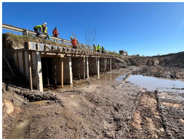
Foto 12.1-4, P05. Frente de obra, alcantarilla en construcción. Ruta 26 progresiva 404K600.
