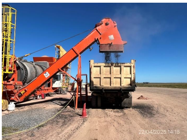
Foto 12.2-9, P03. Planta asfáltica. Carga de mezcla asfáltica en proceso
