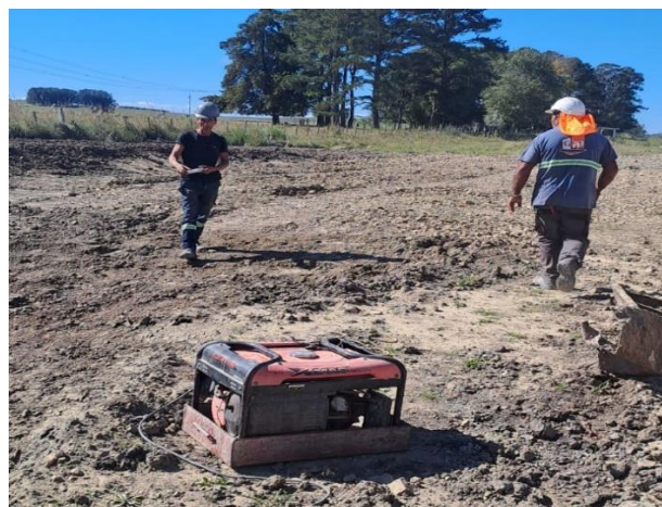
Foto 12.3-2, P05. Fronte de obra, alcantarilla en construcción. Ruta 26 progresiva 404K600. Se incorporó bandeja estanca bajo generador eléctrico en operación
