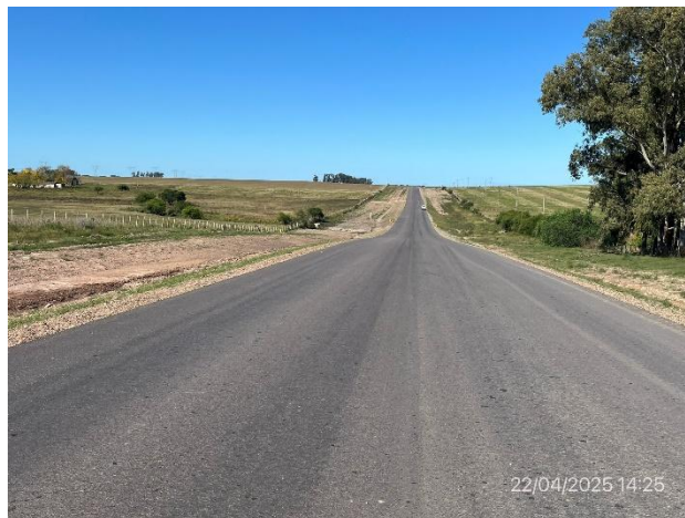
Foto 12.1-2. Sector de Ruta 26 con ensanche de base granular ejecutado
