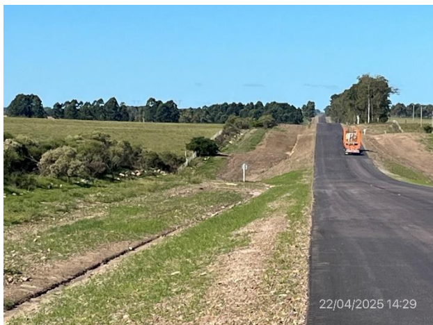
Foto 12.1-3. Sector de Ruta 26 con cunetas perfiladas y tapiz vegetal en crecimiento
