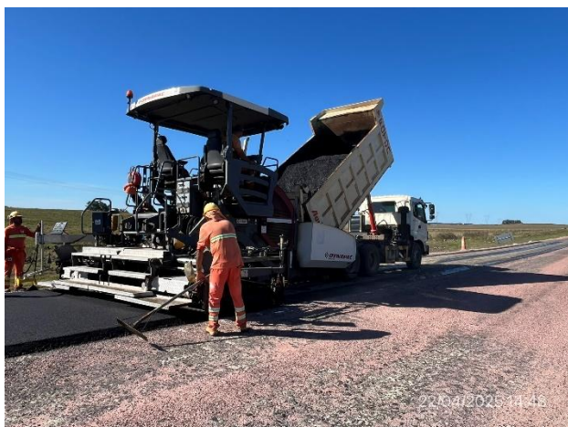
Foto 12.1-9, P06, Tareas de tendido de mezcla asfáltica
