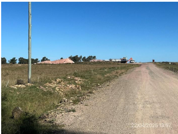
Foto 12.2-1, P03. Obrador, padrón 17654 de la 11ª SC de Cerro Largo. Ruta 26 PK 432K300 a (-).
