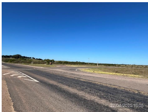
Foto 12.1-12. P02. Fin del tramo, Ruta 26 Progresiva 417K000. Se construirá una nueva rotonda en el empalme de Ruta 26 con Ruta 7.
