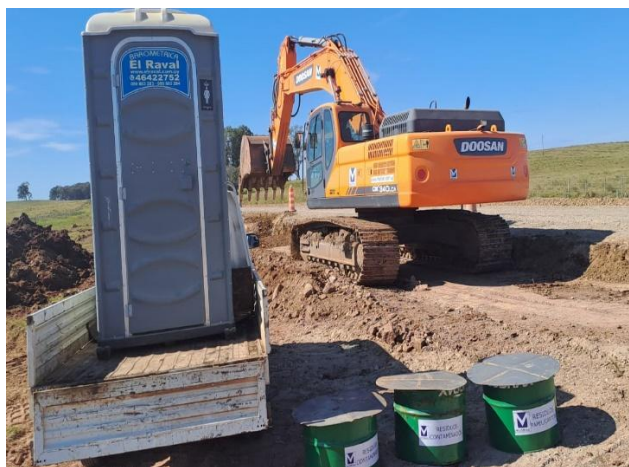
Foto 12.3-1, P06. Fronte de obra, tendido de mezcla asfáltica en ejecución. Ruta 26 progresiva 408K800. Se incorporó la infraestructura para acopio de residuos y los servicios de bienestar faltantes.
