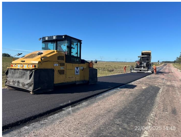
Foto 12.1-8, P06. Frente de obra, tendido de mezcla asfáltica en ejecución. Ruta 26 progresiva 408K800.
