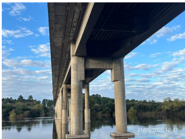
Foto 12.1-3, P01. Estructuras terminadas. Pilares engrosados y tablero superior ensanchado.
