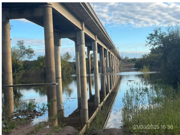
Foto 12.1-5, P01. Zona de ataguía granular, está pendiente la ejecución de batimetría.
