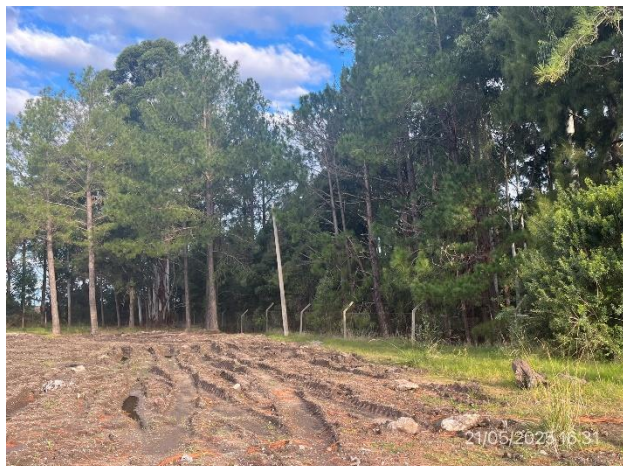
Foto 12.1- 7, P02. Obrador abandonado y restituído. Ruta 3 progresiva 186K000 a (+), padrón rural N°606 de la 2ª SC. de Durazno
