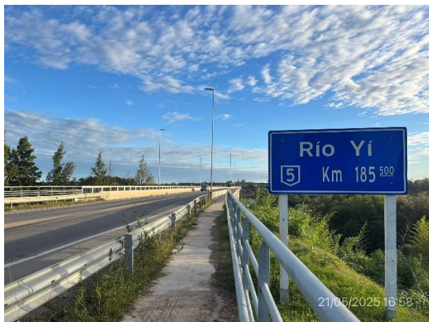
Foto 12.1-1, P01. Puente terminado sobre Río Yí. Ruta 5 progresiva 185K500.
