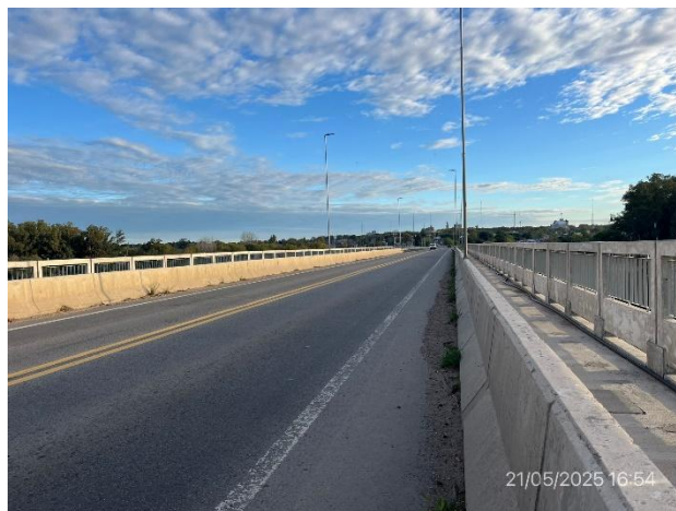
Foto 12.1-2, P01. Obra terminada con ciclovías laterales habilitadas e iluminación instalada.
