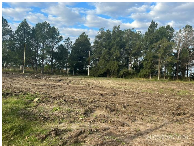
Foto 12.1-8, P02. Obrador restituído a MDN. Se realizó nivelación del terreno y aporte de suelo vegetal.
