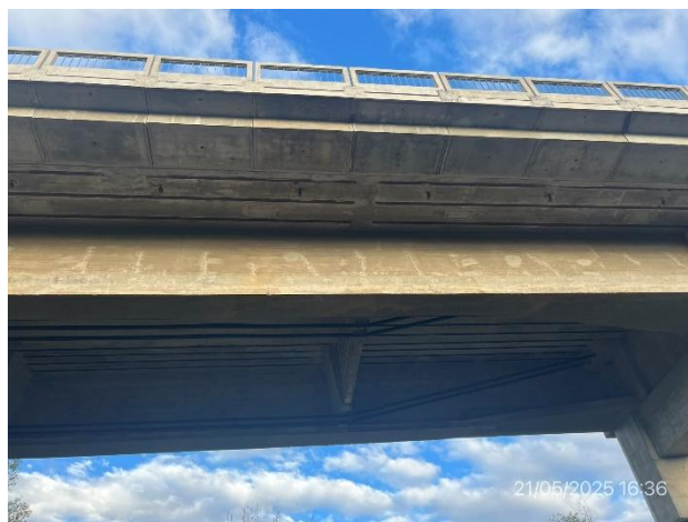
Foto 12.1-4, P01. Refuerzos exteriores de tablero y vigas colocados.
