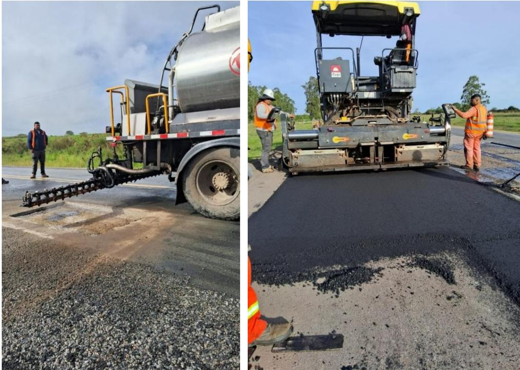
Imagen N°6: Riego de adherencia en reparaciones de baches Ruta 2. Imagen N°7: Reparaciones por roturas en calzada Ruta 12.
