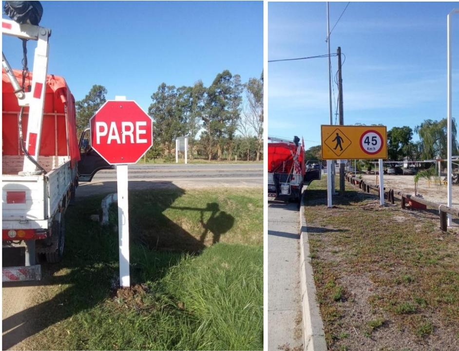
Imagen N°10: Colocación de nueva señalización vertical ruta 2.
