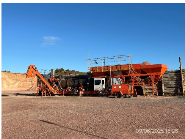
Foto 12.2-3, P03. Planta asfáltica con actividad suspendida, y explanada de maniobras y acopio de áridos
