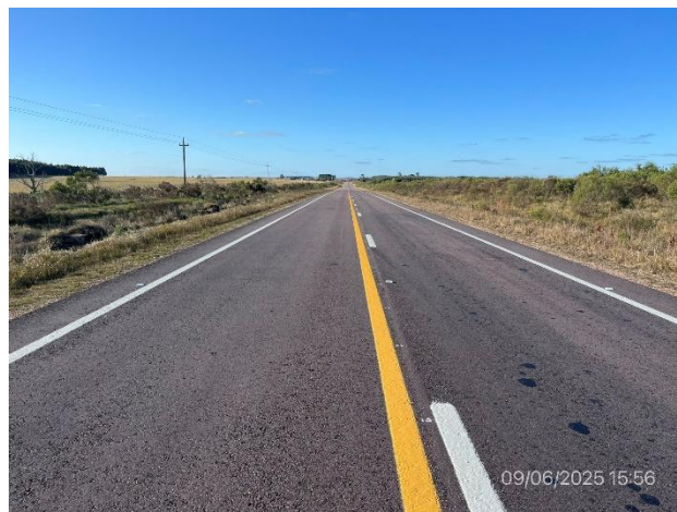
Foto 12.1-2. Tramo de Ruta 7 con tareas terminadas. Nueva calzada en mezcla asfáltica ejecutada.
