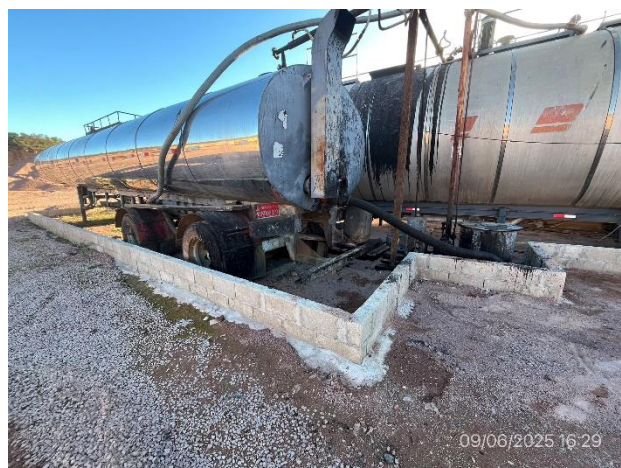
Foto 12.2-4, P03. Planta asfáltica, envallado perimetral correcto para contención de eventuales derrames.
