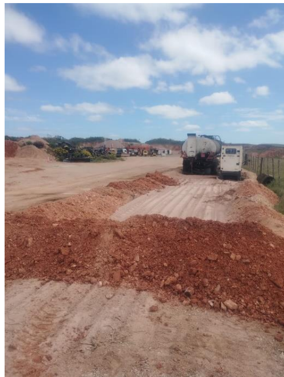
Foto 12.3-6, P03. Se acondicionó el envallado de la zona del tanque de asfalto.
