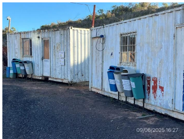
Foto 12.2-2, P03. Estación correcta para acopio temporal de residuos segregados por corriente de generación.
