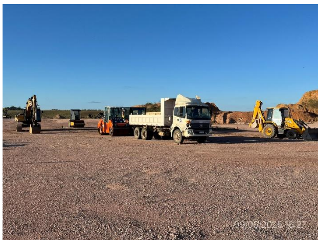
Foto 12.2-1, P03. Obrador y Planta Asfáltica sin actividad. Padrón rural N° 8942, 8ª SC. de Treinta y Tres.
