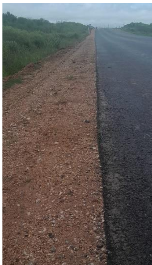
Foto 12.3-4., Ruta 7 progresiva 290K500 a (+), se retiraron los residuos de asfalto.
