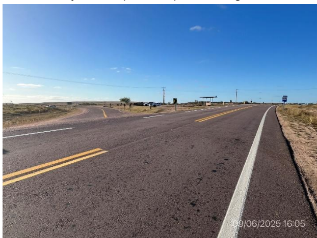
Foto 12.1-5 Ruta 7, empalme con Ruta 38. Obras de señalización horizontal y vertical terminadas.
