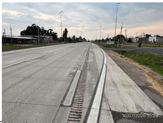
Foto 12.2-8, Obras terminadas en Ruta 8. Iluminación ejecutada.
