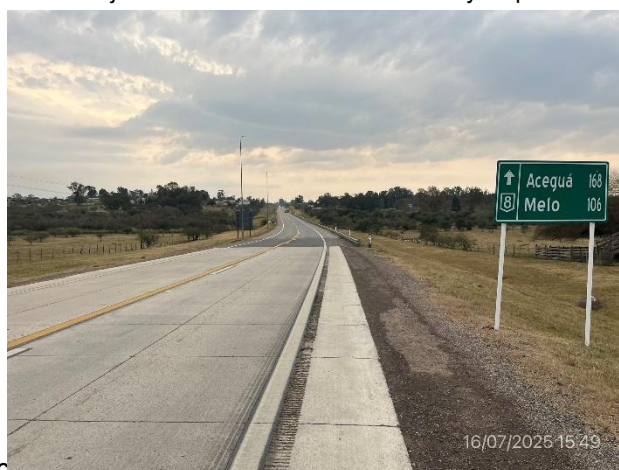
Foto 12.2-12, P02. Fin de tramo, Ruta 8 progresiva 288K000. Rotonda de empalme con Ruta 17
