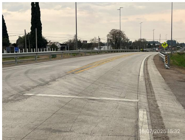
Foto 12.2-4. Obras terminadas en Ruta 8. Señalización y defensas metálicas ejecutadas.
