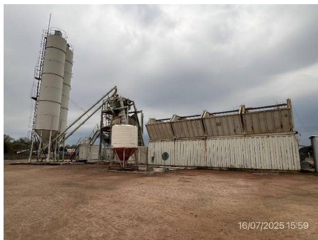
Foto 12.1-4, P03. Planta de hormigón sin desmantelar, permanece en el predio de MTOP.
