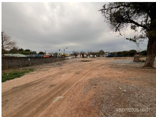
Foto 12.1-3, P03. Obrador abandonado. Las instalaciones provisionales de CVC SA fueron desmanteladas y retiradas.
