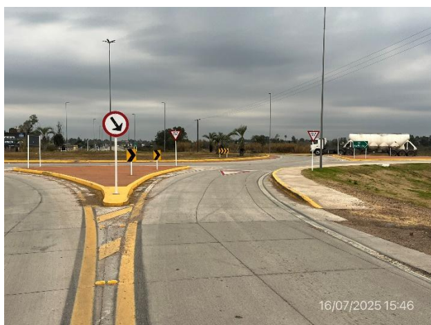
Foto 12.2-11, P02. Fin de tramo, rotonda de empalme con Ruta 17
