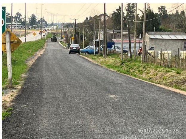
Foto 12.2-7, Obras terminadas en Ruta 8. Calle lateral de Villa Sara ejecutada con carpeta de rodadura en tratamiento bituminoso.
