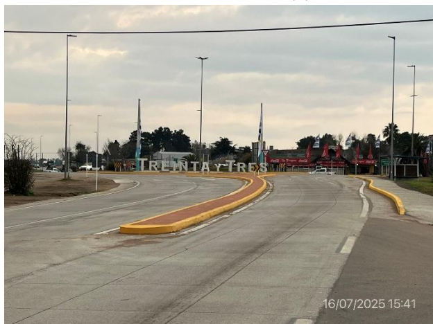
Foto 12.2-5, Obras terminadas en Ruta 8. Rotonda de empalme con Br. Fructuoso del Puerto ejecutada.
