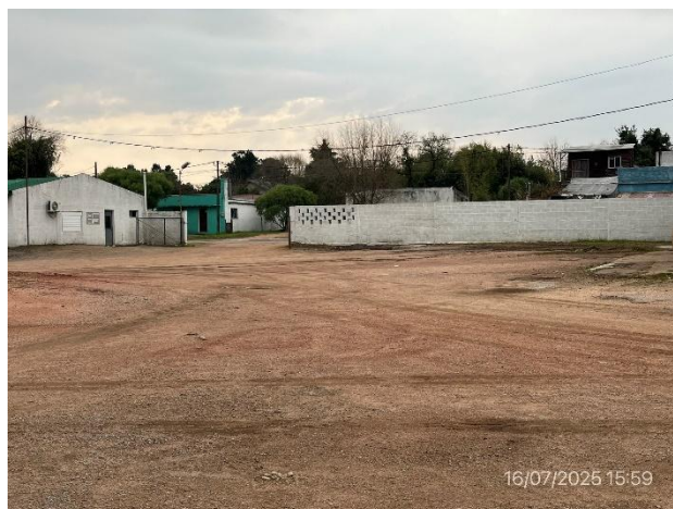
Foto 12.1-2, P03. Obrador abandonado. Explanada de maniobras despejada y libre de residuos.
