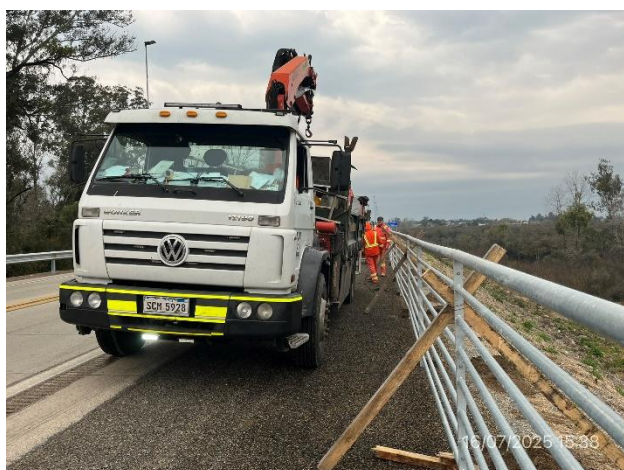
Foto 12.2-9, P04. Frente de obras de defensas metálicas, puente sobre río Olimar. Ruta 8 progresiva 283K700 a (-).
