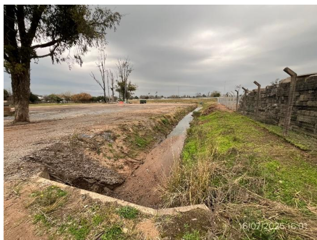
Foto 12.1-6, P03. Cañada interna al predio tributaria del A° Yermal. Zona libre de residuos.
