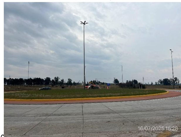
Foto 12.2-6. Obras terminadas en Ruta 8. Rotonda de empalme con acceso INIA y CURE ejecutada.
