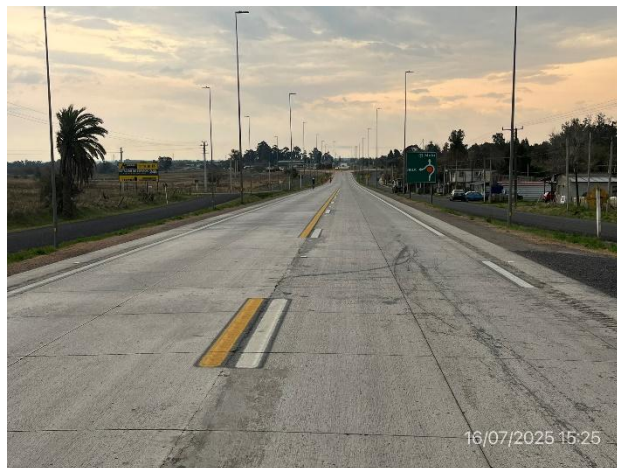
Foto 12.2-2, Obras de travesía de Ruta 8 a Villa Sara culminadas. Nueva calzada en hormigón ejecutada.
