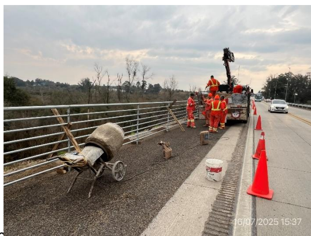
Foto 12.2-10, P04. Defensas metálicas en proceso de montaje. Buenas condiciones de orden y limpieza.
