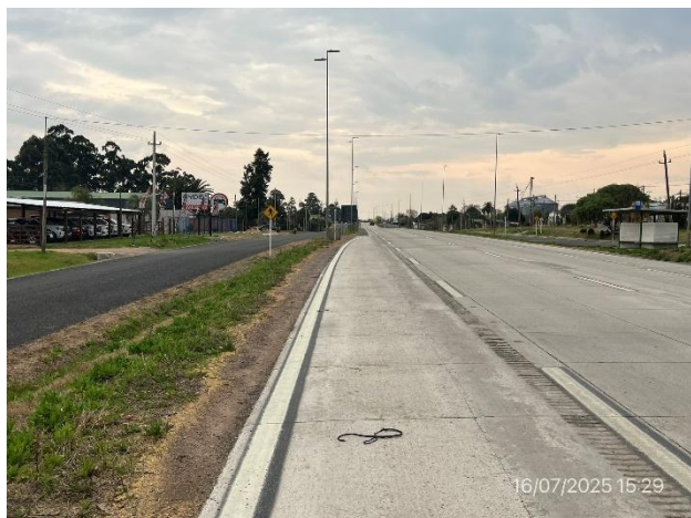
Foto 12.2-3. Obras terminadas en Ruta 8. Dársena de giro terminada en senda a (+).
