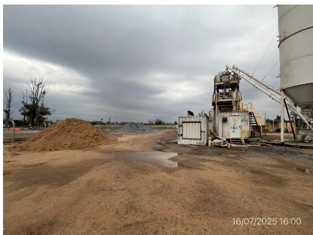
Foto 12.1-5, P03. Planta de hormigón sin desmantelar. Sector libre de residuos, zona limpia y ordenada.
