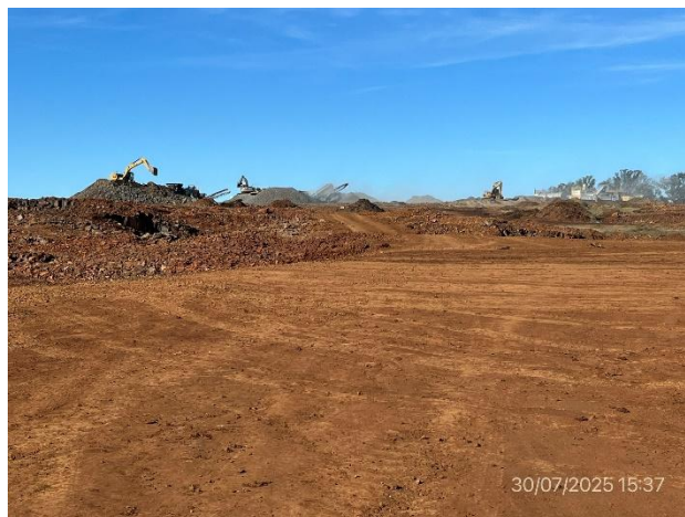
Foto 12.1-14, P03. Cantera de piedra. Acopio de material triturado. Explanada de acceso ordenada y libre de residuos.
