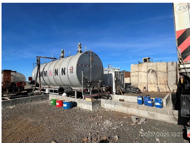
Foto 12.1-11, P03. Planta de asfalto, envallado perimetral correcto. Está disponible la infraestructura para el acopio temporal de residuos
