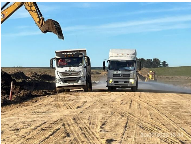
Foto 12.2-19, P09. Movimiento de suelos en ejecución.
