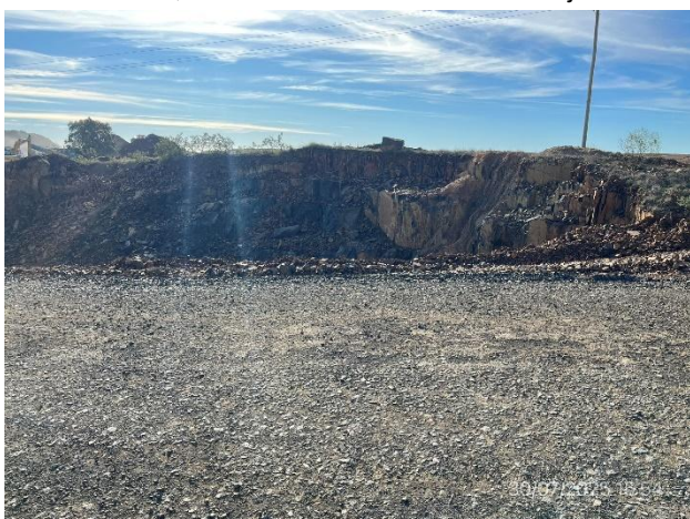
Foto 12.2-21, P07. Ruta 6 progresiva 307K400 a (-).
