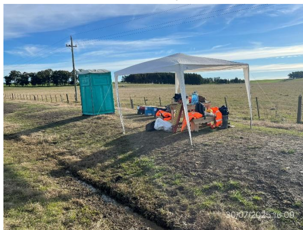
Foto 12.2-16, P08. Campamento provisorio, buenas condiciones de orden y limpieza. Instalaciones correctas.
