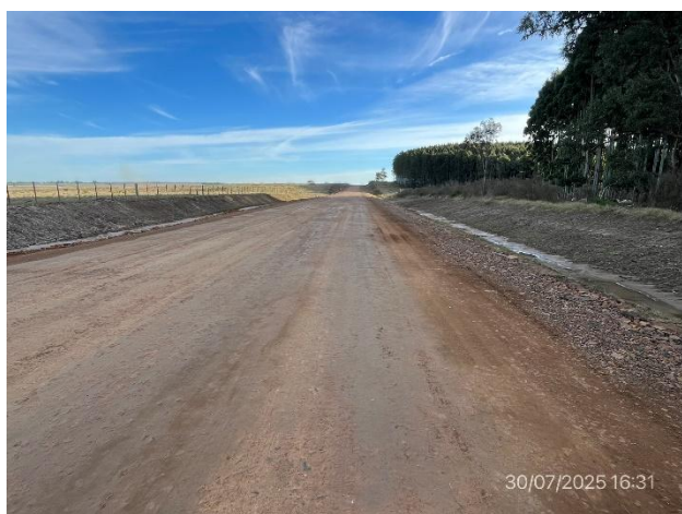
Foto 12.2-17, Nueva traza de Ruta 6. Sub-base granular perfilada.
