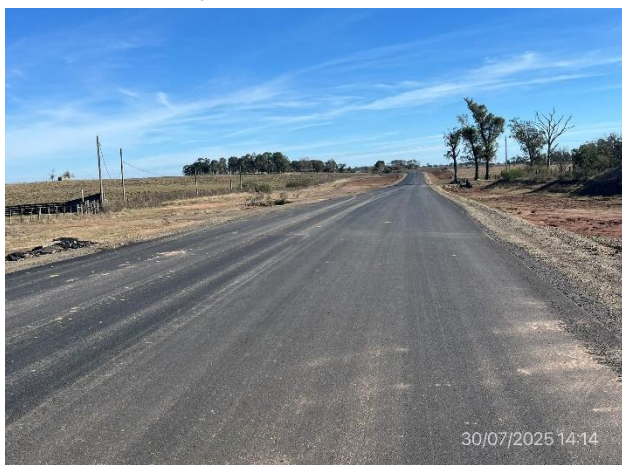
Foto 12.2-3, Ruta 6. Sector con carpeta de rodadura ejecutada.
