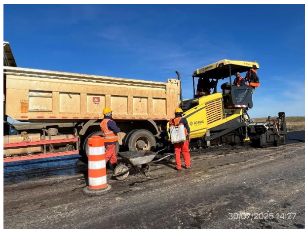
Foto 12.2-4, P04. Frente de obras, tendido de mezcla asfáltica. Ruta 6 progresiva 316K100.
