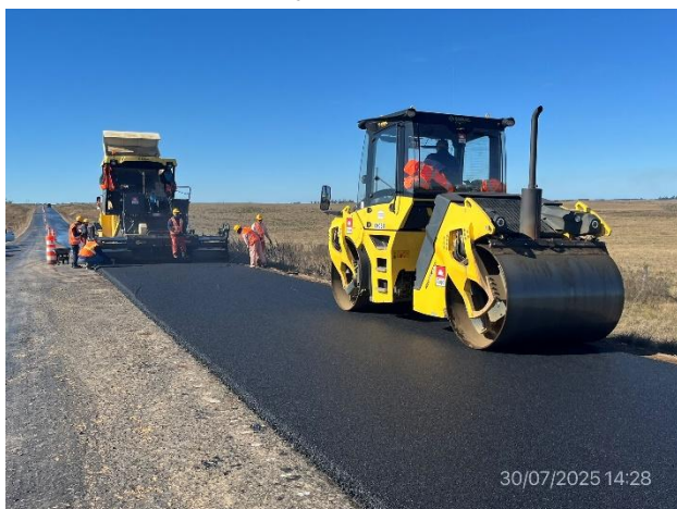
Foto 12.2-5, P04. Compactación de carpeta de rodadura en ejecución,
