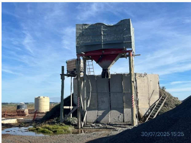
Foto 12.1-7, P03. Obrador, planta de hormigón.
