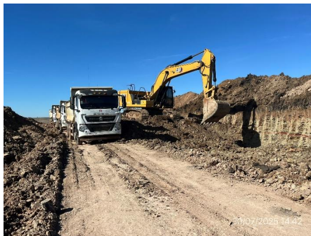
Foto 12.2-8, P05. Frente de obras, desmonte a terraplén en sector expropiado. Ruta 6 progresiva 313K300 a (+).
