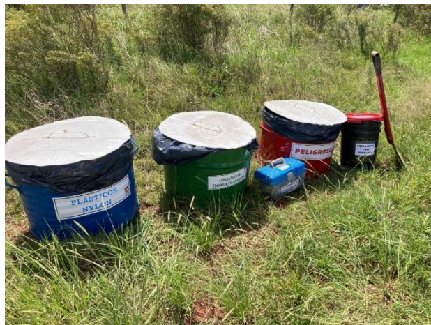
Foto 12.3-2, Frente de obras. Se incorporaron recipientes para el acopio temporal de residuos y se completó el kit para actuación ante derrames.
