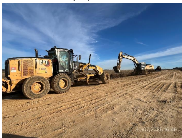
Foto 12.2-18, P09. Frente de obra, fin de avance de apertura de caja y reconfiguración altimétrica y planimétrica. Ruta 6 progresiva 276K200.
