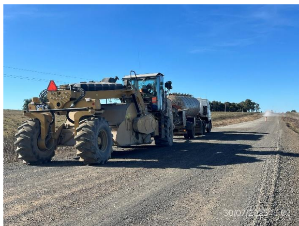
Foto 12.2-12, P06. Cementado y perfilado de base granular en ejecución.
