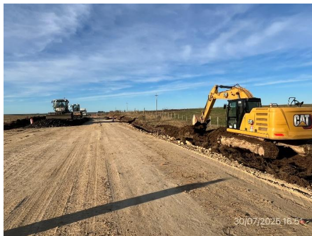
Foto 12.2-20, P09. Perfilado de drenajes en ejecución.
