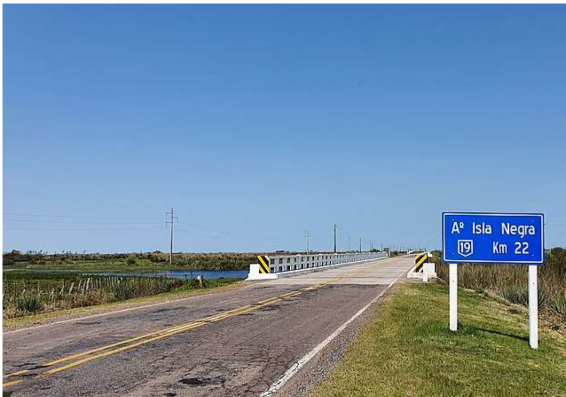
Ruta 19, tramo: 19k300 – 26k500
