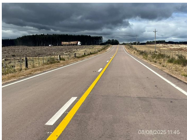
Foto 12.2-1, P01. Inicio del tramo, C no a la Balsa progresiva 20K200.
