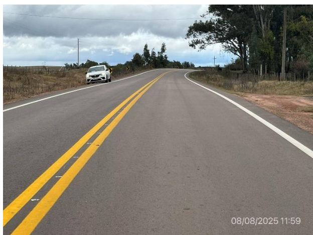
Foto 12.2-5, P02. Fin del tramo, C no a la Balsa progresiva 30K500.
