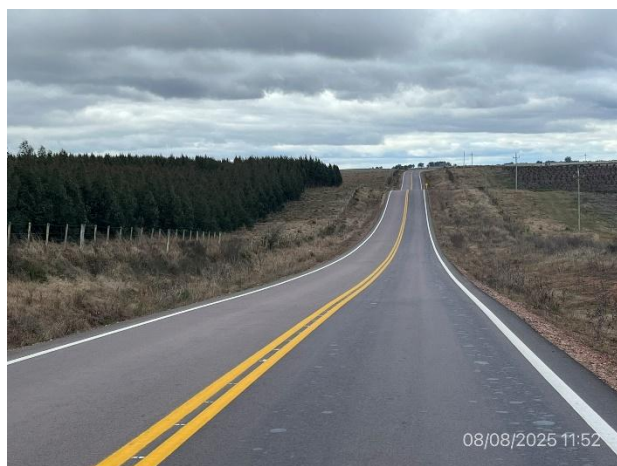
Foto 12.2-2, C no a la Balsa. Obras terminadas, carpeta asfáltica ejecutada.
