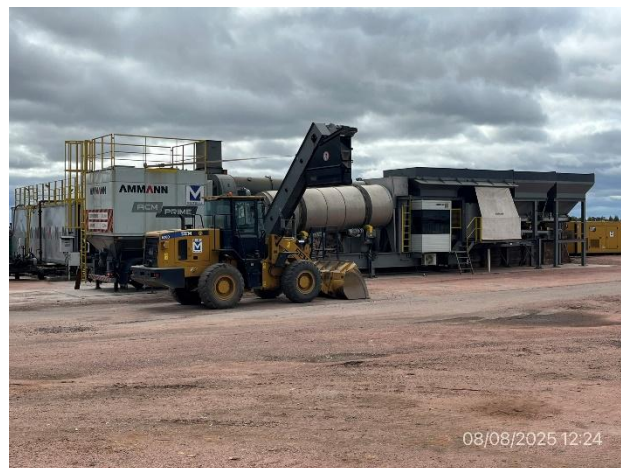
Foto 12.1-4, P03. Planta asfáltica, explanada de maniobras ordenada y libre de ROCs u otros residuos.
