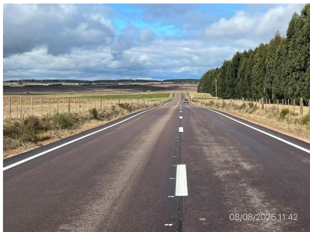
Foto 12.2-3 C no a la Balsa. Obras de señalización horizontal terminadas.
