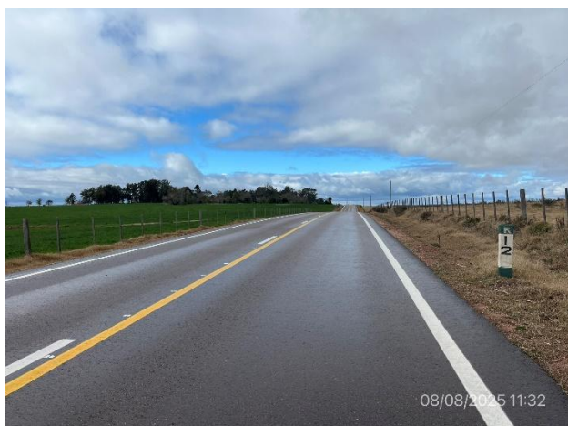
Foto 12.2-1, P01. Inicio del tramo, C no a la Balsa progresiva 12K000.
