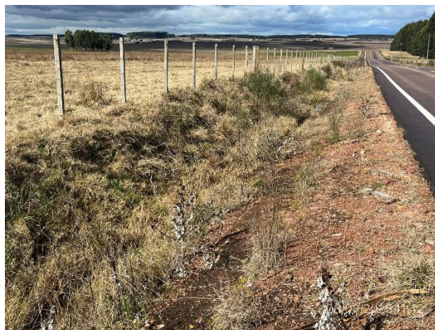
Foto 12.2-4, C no a la Balsa. Faja pública buenas condiciones de escurrimiento con empastado incipiente.
