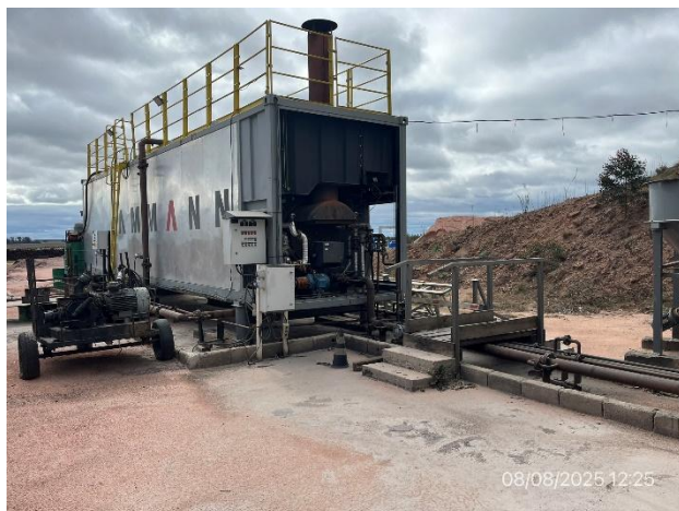
Foto 12.1-3, P03. Planta asfáltica sin actividad con envallado perimetral correcto.
