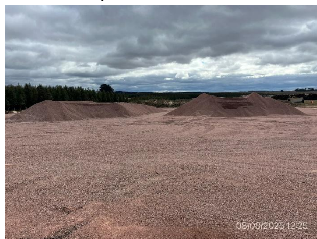
Foto 12.1-6, P03. Obrador, acopios de material triturado permanecen para ser utilizados en futuros contratos.
