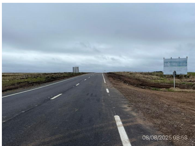
Foto 12.2-5, P01. Inicio de tramo. Ruta 20 progresiva 138K500.
