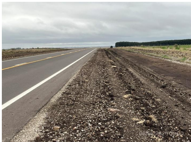
Foto 12.2-3. Ruta 20, faja pública con drenajes conformados y tapiz vegetal en crecimiento.
