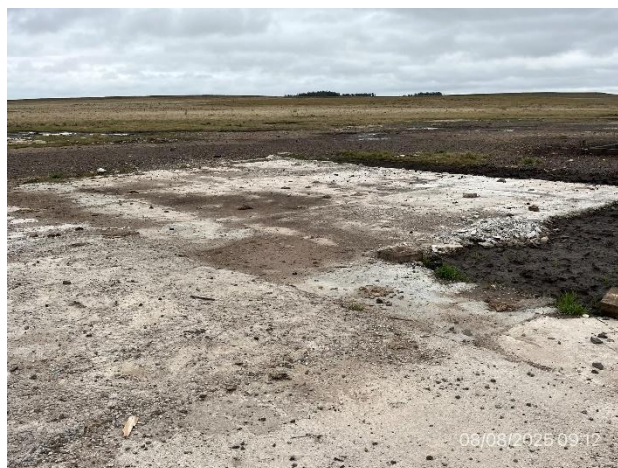
Foto 12.1-16, P04. Obrador, plateas de hormigón permanecen como mejoras para el propietario.
