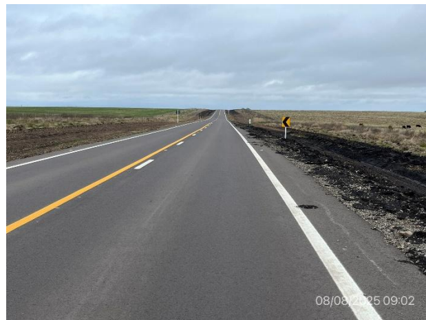
Foto 12.2-4. Ruta 20, faja pública con tendido de tierra negra en taludes y contrataludes.
