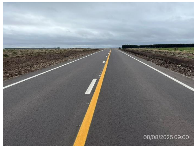
Foto 12.2-2. Ruta 20, obras terminadas y señalización horizontal ejecutada.
