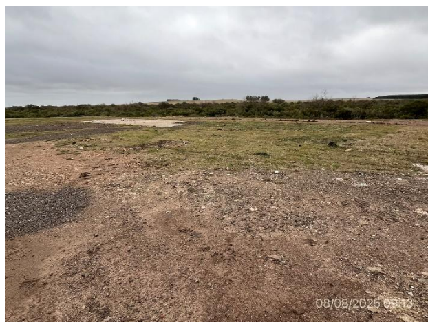
Foto 12.1-17, P04. Obrador, caminería interna y plataforma granular permanecen como mejoras para el propietario.
