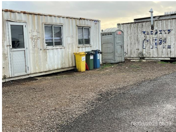
Foto 12.1-2, P03. Obrador, infraestructura correcta para el acopio temporal de residuos segregados desde origen.
