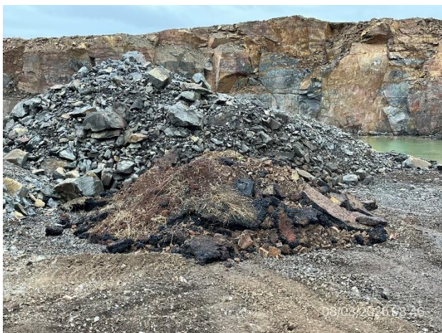
Foto 12.1-13, P03. Cantera, se dispusieron restos de RAP mezclados con acopio de material bruto.
