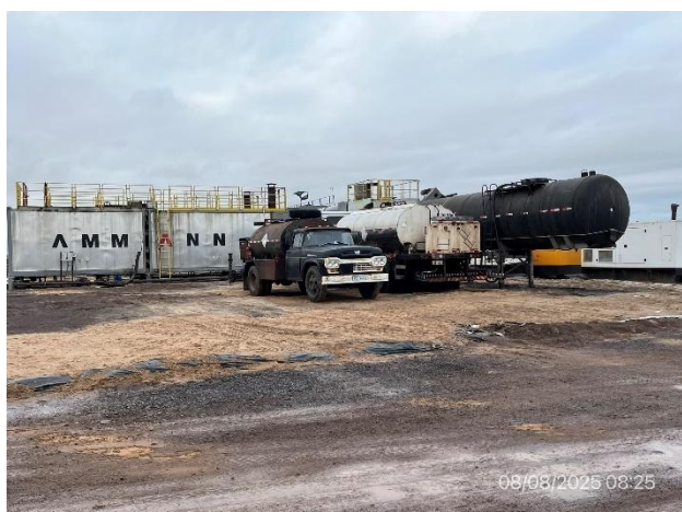
Foto 12.1-9, P03. Planta asfáltica, no hay envallado perimetral para contención de eventuales derrames.
