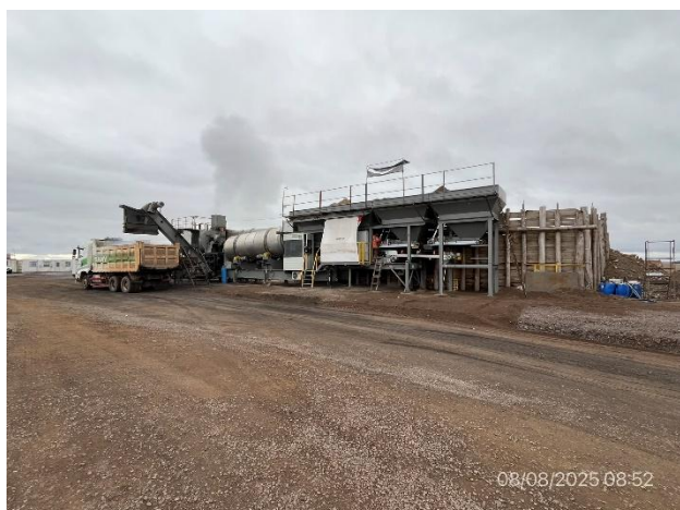
Foto 12.1-7, P03. Planta asfáltica en operación. Explanada de maniobras.
