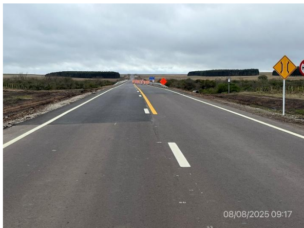
Foto 12.2-1, P02. Fin de tramo, Ruta 20 progresiva 147K200. Acceso Oeste a puente sobre A° Salsipuedes.
