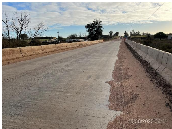
Foto 12.1-6, P01. Estructura del tablero superior terminada. Restan por ejecutar carpeta de rodadura y señalización.
