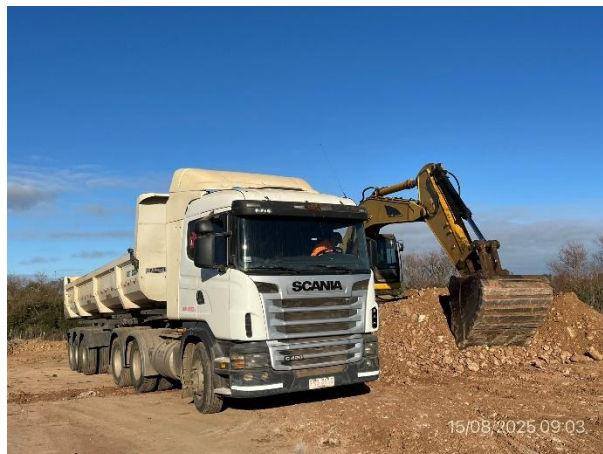
Foto 12.2-2, P02. Explanada de acopio de áridos y estacionamiento de maquinaria.
