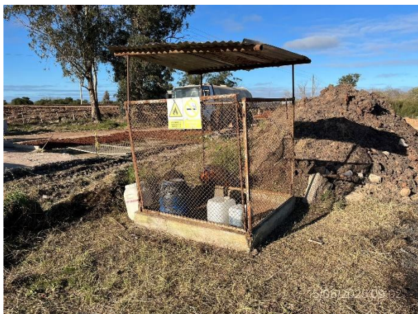
Foto 12.2-5, P02. Sector envallado para alojar tarrinas de lubricantes, buenas condiciones de limpieza.
