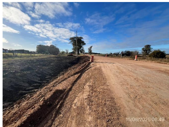
Foto 12.1-8, P01. Acceso a puente sobre A° Pedernal, conformación de drenajes en ejecución
