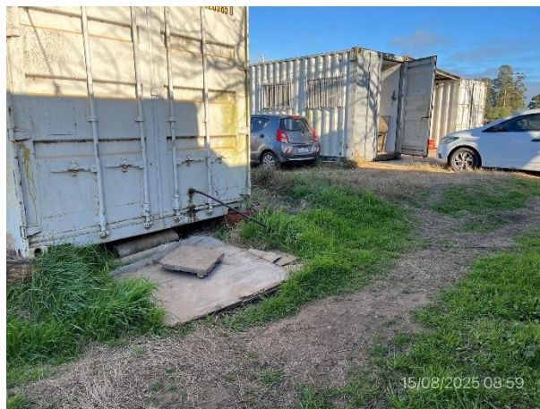
Foto 12.2-4, P02. Infraestructura de subcontrato Ingeniería Pacífico SA inaccesible y pendiente de ser desmontada.
