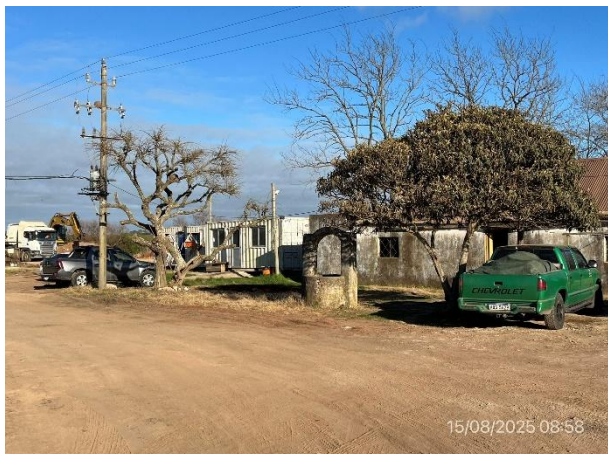
Foto 12.2-1, P02. Obrador. padrón rural N° 55335, 10ª SC. de Canelones. Ruta 7 progresiva 76K000 a (-). Cuenta infraestructura para acopio segregado de residuos.
