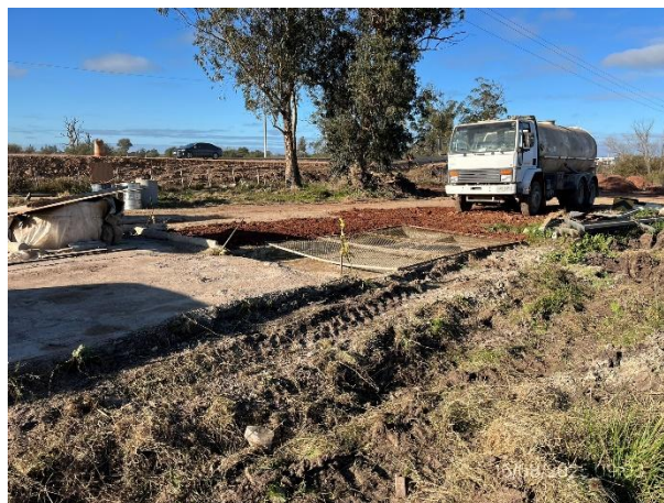
Foto 12.2-6, P02. Pileta de lavado de camiones mixer, pendiente de ser desmantelada.
