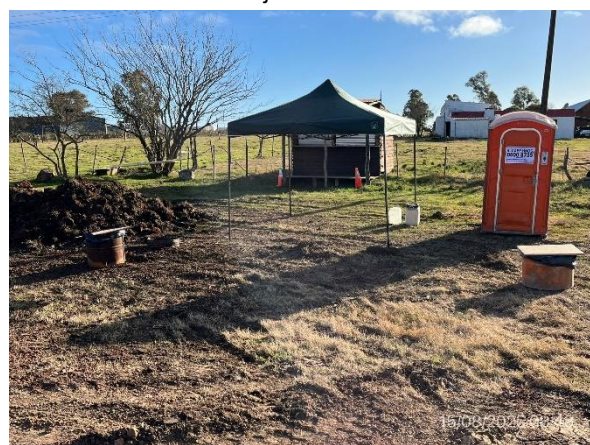
Foto 12.1-12, P04, Campamento móvil, infraestructura adecuada en buenas condiciones de orden y limpieza
