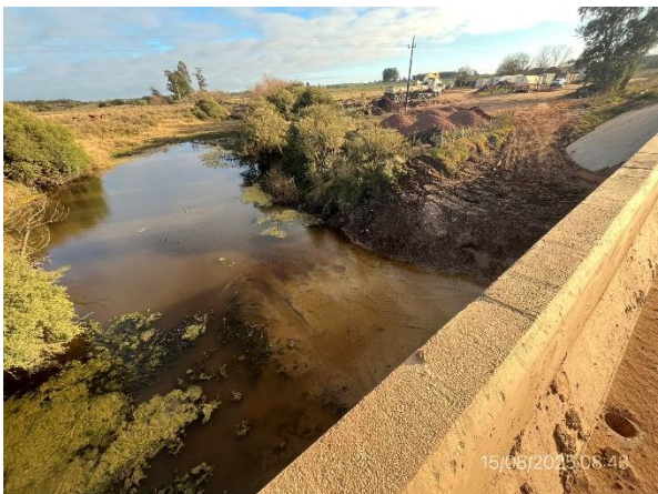
Foto 12.1-3, P01. La ataguía provisional fue removida. A° Pedernal con buenas condiciones de escurrimiento.
