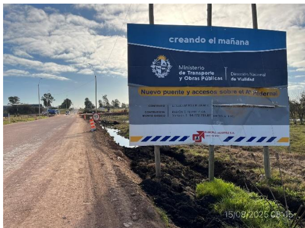
Foto 12.1-7, P01. Accesos en ejecución a puente sobre A° Pedernal .
