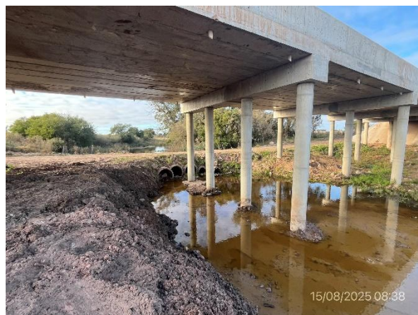
Foto 12.1-2, P01. Entubado de A° Pedernal y camino provisional permanecen por indicación de DNV - MTOP.
