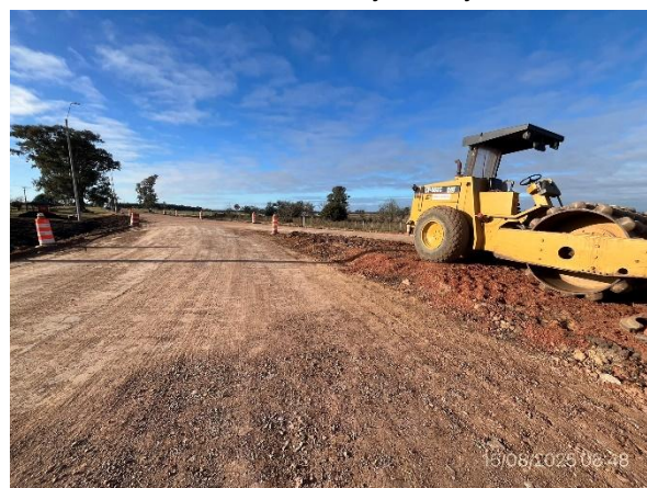
Foto 12.1-10, P04. Compactación de base granular en ejecución.
