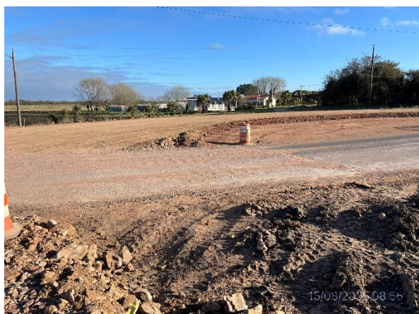
Foto 12.1-9, P04. Rotonda de Rutas 7 y 80 en ejecución
