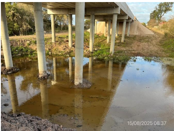
Foto 12.1-5, P01. Superestructura terminada
