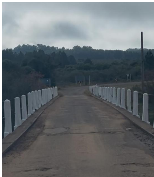
Imagen 2 – Baranda de puentes pintadas
