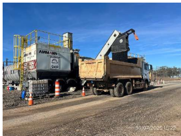
Foto 12.1-12, P03. Planta de asfalto. Proceso de carga y transporte. Se coloca producto biodegradable para evitar adherencias de mezcla asfáltica a la caja del camión.
