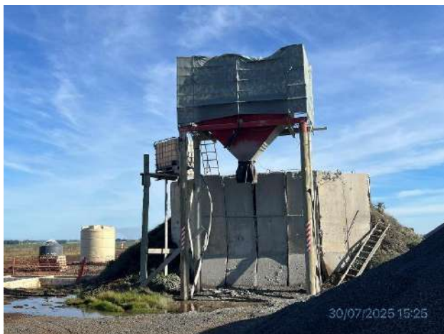
Foto 12.1-7, P03. Obrador, planta de hormigón.
