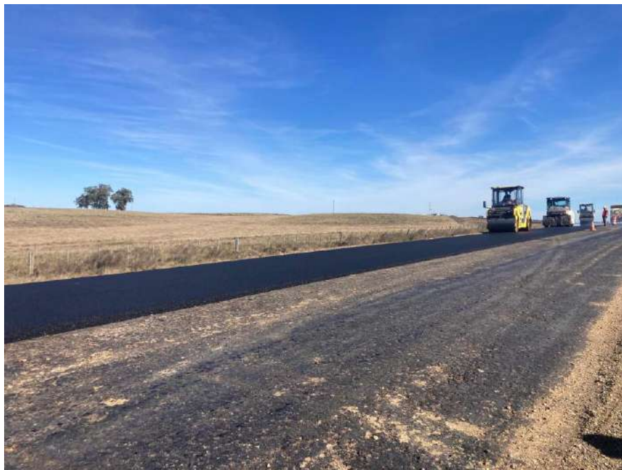
Imagen N°12: Ejecución de carpeta asfáltica.
