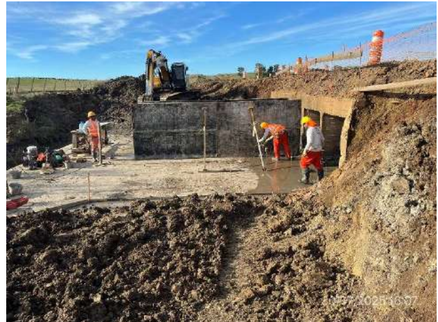
Foto 12.2-14, P08. Frente de obras, alcantarilla en construcción. Ruta 6 progresiva 303K500.
