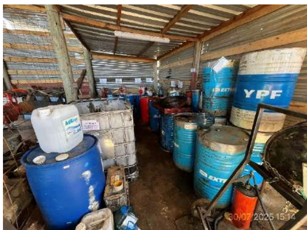
Foto 12.1-5, P03. Obrador, acopio de lubricantes y residuos contaminantes en local con techado y envallado correctos.
