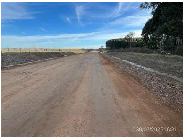
Foto 12.2-17, Nueva traza de Ruta 6. Sub-base granular perfilada.
