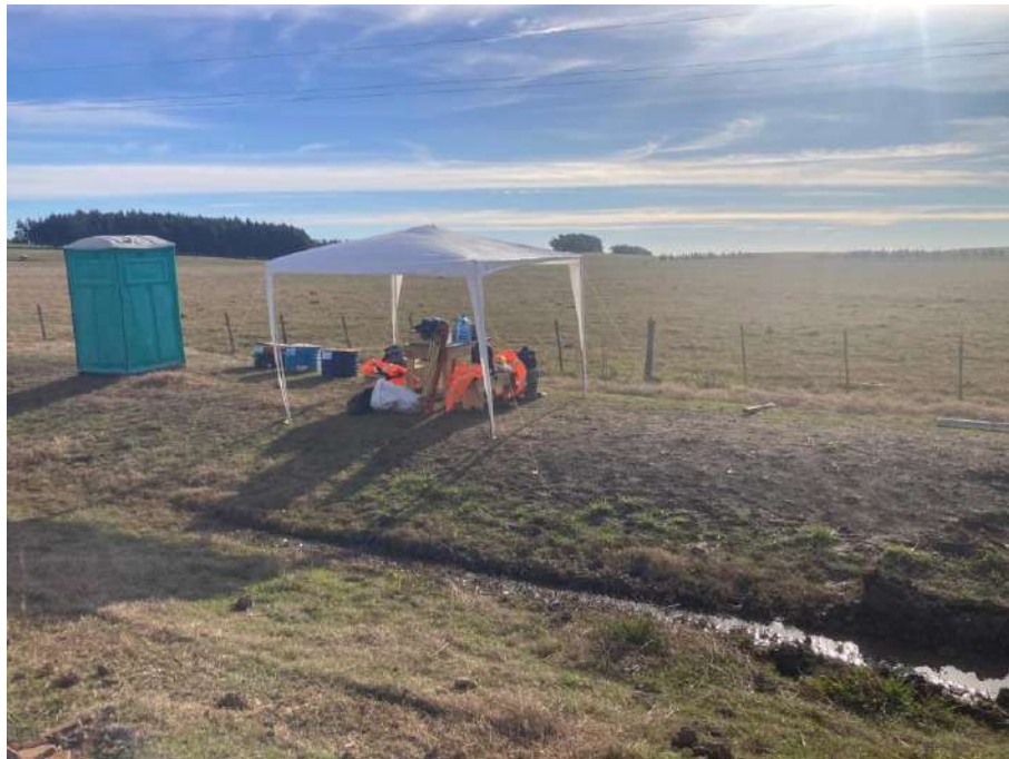
Imagen N°16: Obrador provisorio en frente de alcantarilla tipo H.
