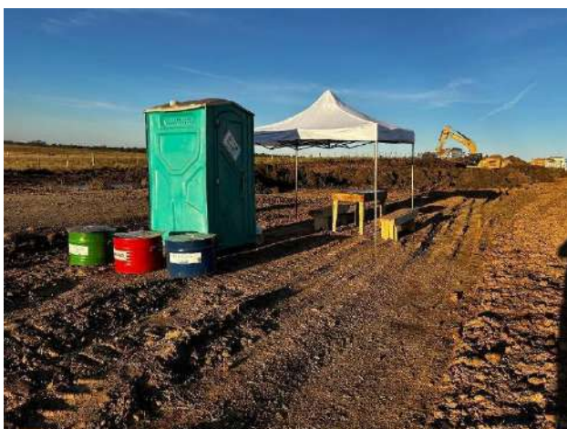
Foto 12.4-3,. P05. Se instaló el campamento móvil, con servicios de bienestar e infraestructura para el acopio temporal de residuos
