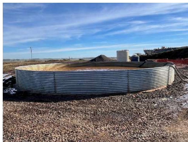
Foto 12.1-6, P03. Obrador, tajamar para acopio de agua proveniente de toma autorizada.
