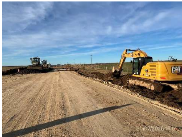
Foto 12.2-20, P09. Perfilado de drenajes en ejecución.
