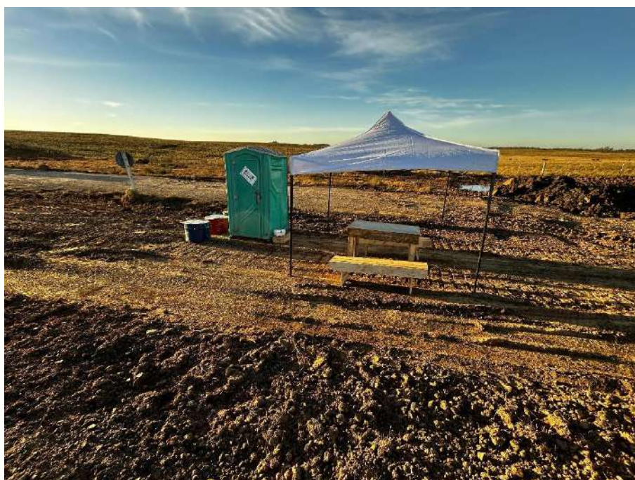
Foto Nº 9 y 10: Se agrega campamento provisorio en prog 314+000 km, zona de excavación.
