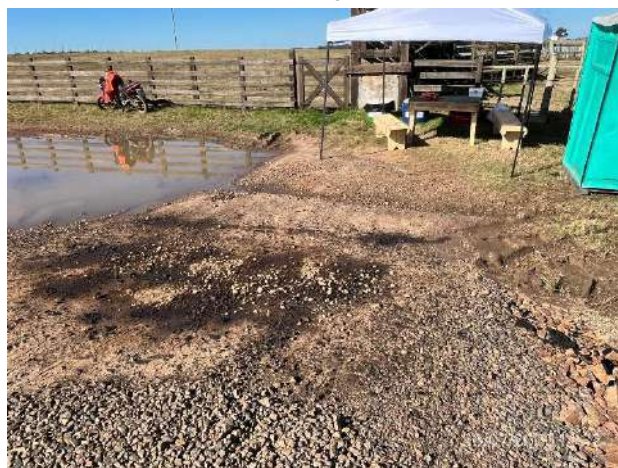
Foto 12.2-6, P04. Derrames oleosos pendiente de recolección y disposición final como residuo contaminado.
