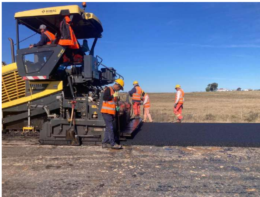
Imagen N°11: Ejecución de carpeta asfáltica.
