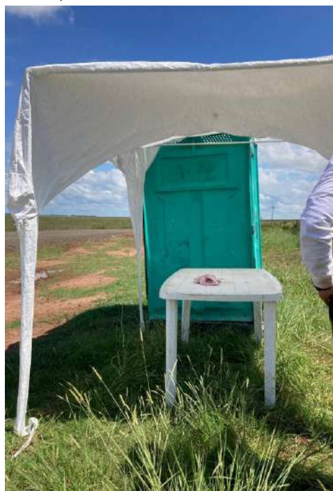
Foto 12.3-4, Frente de obras. Se incorporaron los servicios de bienestar para los operarios: zona de resguardo, gazebo con mesa y baño químico.
