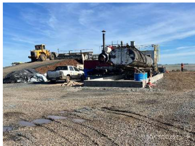
Foto 12.1-10, P03. Planta de asfalto, explanada en buenas condiciones de orden y limpieza.
