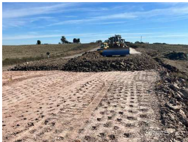
Foto 12.2-10, P06. Frente de obras, terraplén en construcción. Ruta 6 progresiva 312K400 a (-).
