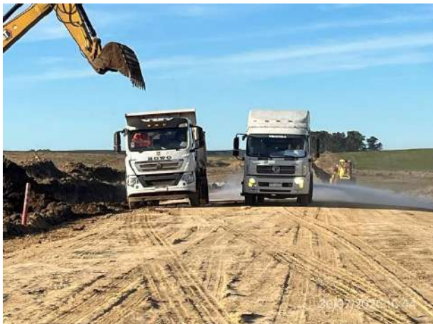
Foto 12.2-19, P09. Movimiento de suelos en ejecución.
