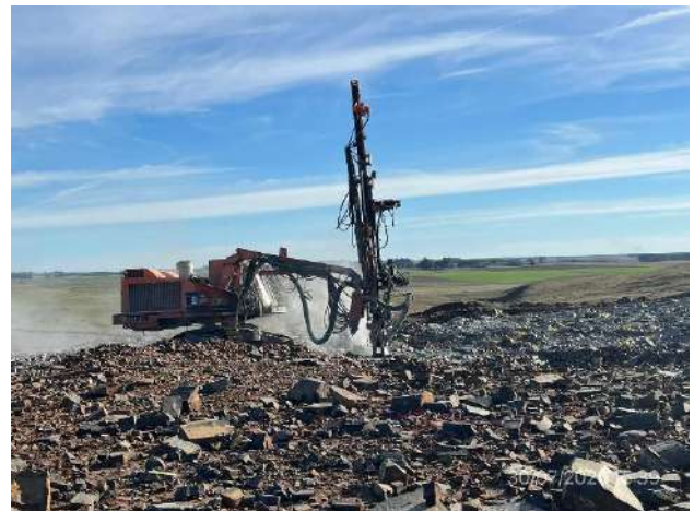
Foto 12.1-16, P03. Cantera de piedra, subcontratista Pinsey SA en proceso de perforación para ejecución de voladuras.
