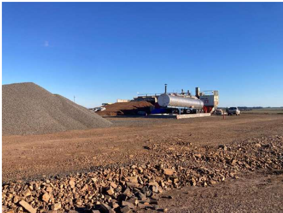
Imagen N°5: Ejecución de la bandeja para la planta asfáltica.
