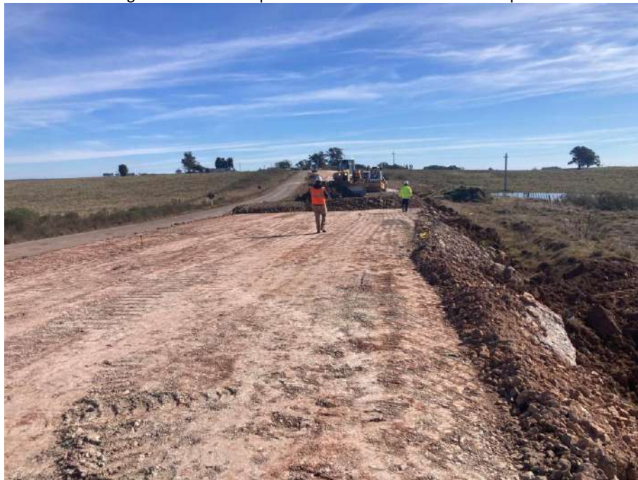
Imagen N°17: Ejecución de ensanche.
