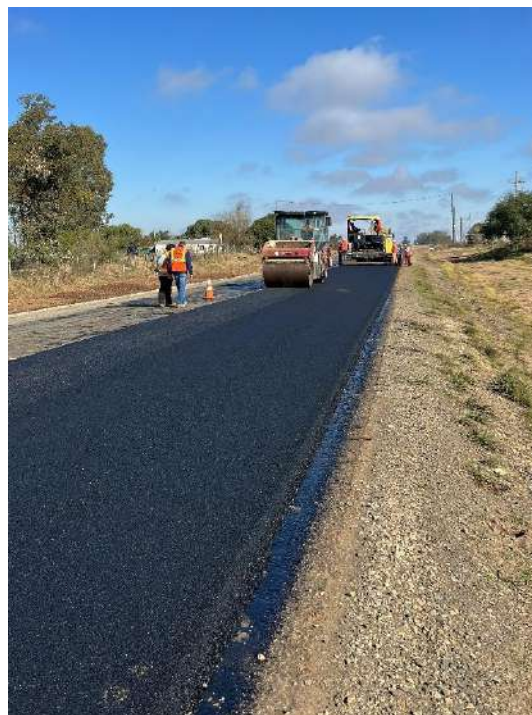
Imagen N°9 y 10: Ejecución de carpeta asfáltica.
