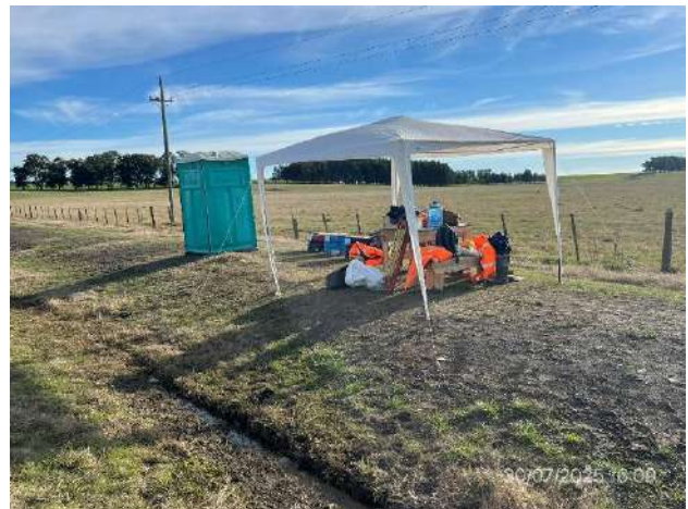
Foto 12.2-16, P08. Campamento provisorio, buenas condiciones de orden y limpieza. Instalaciones correctas.
