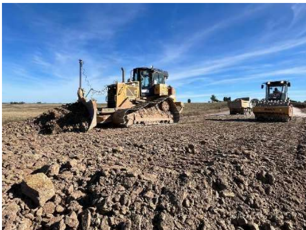
Foto 12.2-11, P06. Frente de obra, recarga de base granular en ejecución.
