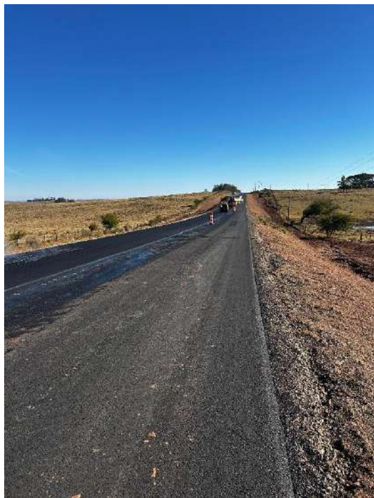
Imagen N°9 y 10: Ejecución de carpeta asfáltica.
