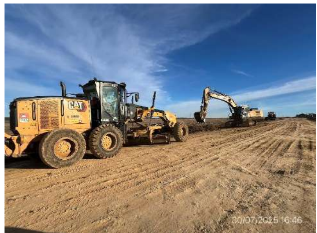
Foto 12.2-18, P09. Frente de obra, fin de avance de apertura de caja y reconfiguración altimétrica y planimétrica. Ruta 6 progresiva 276K200.
