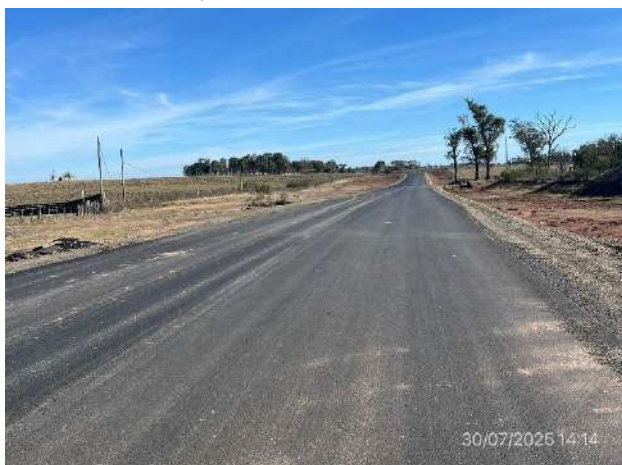
Foto 12.2-3, Ruta 6. Sector con carpeta de rodadura ejecutada.
