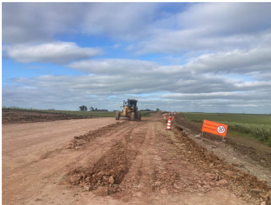
Imagen N°18: Ensanche de plataforma.
