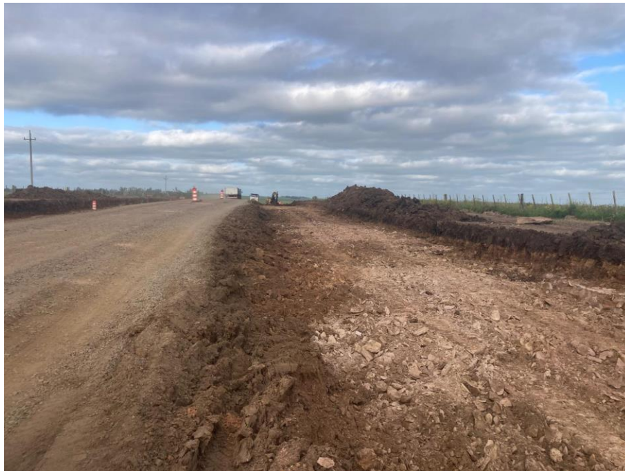
Imagen N°19 y 20: Ejecución del diente para ensanche de plataforma.
