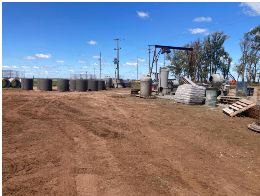
Imagen N°7: Subcontrato de canos de hormigón para alcantarillas.
