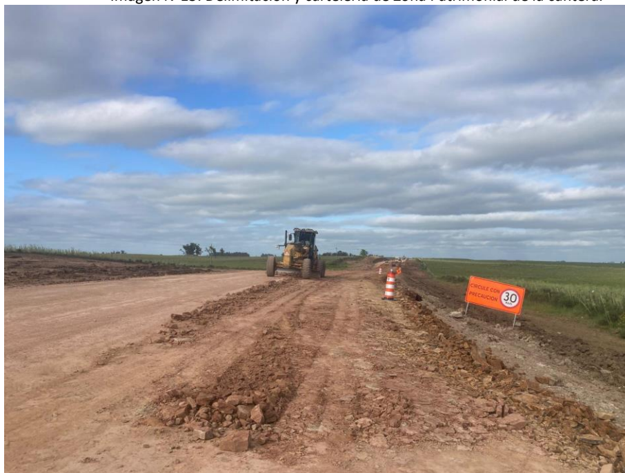
Imagen N°14: Ensanche de plataforma.
