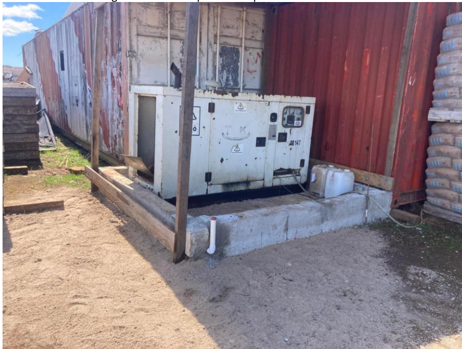
Imagen N°4: Bandeja impermeable para generador.
