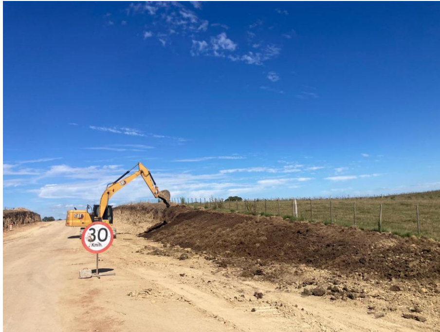
Imagen N°13: Adecuación de taludes.
