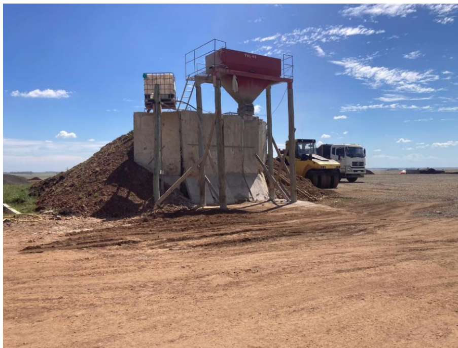
Imagen N°11: Planta de fabricación de hormigón.
