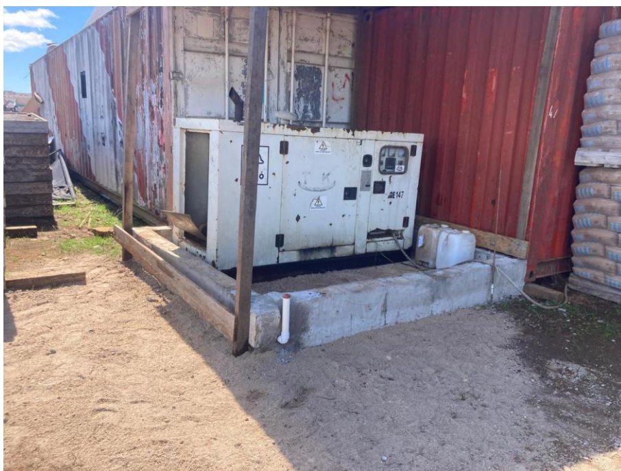
Imagen N°4: Bandeja impermeable para generador.
