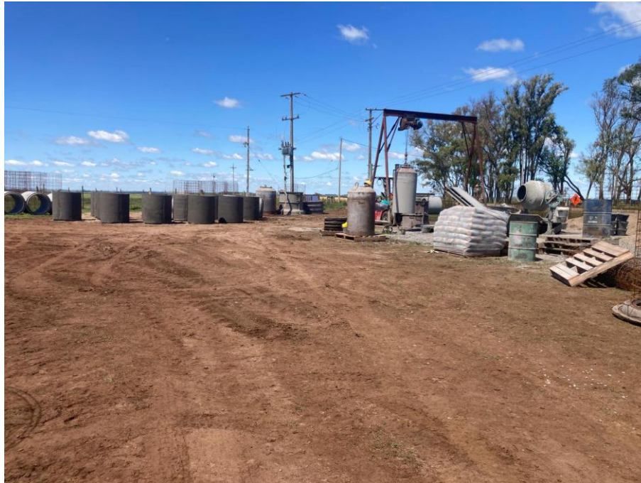
Imagen N°7: Subcontrato de caños de hormigón para alcantarillas.
