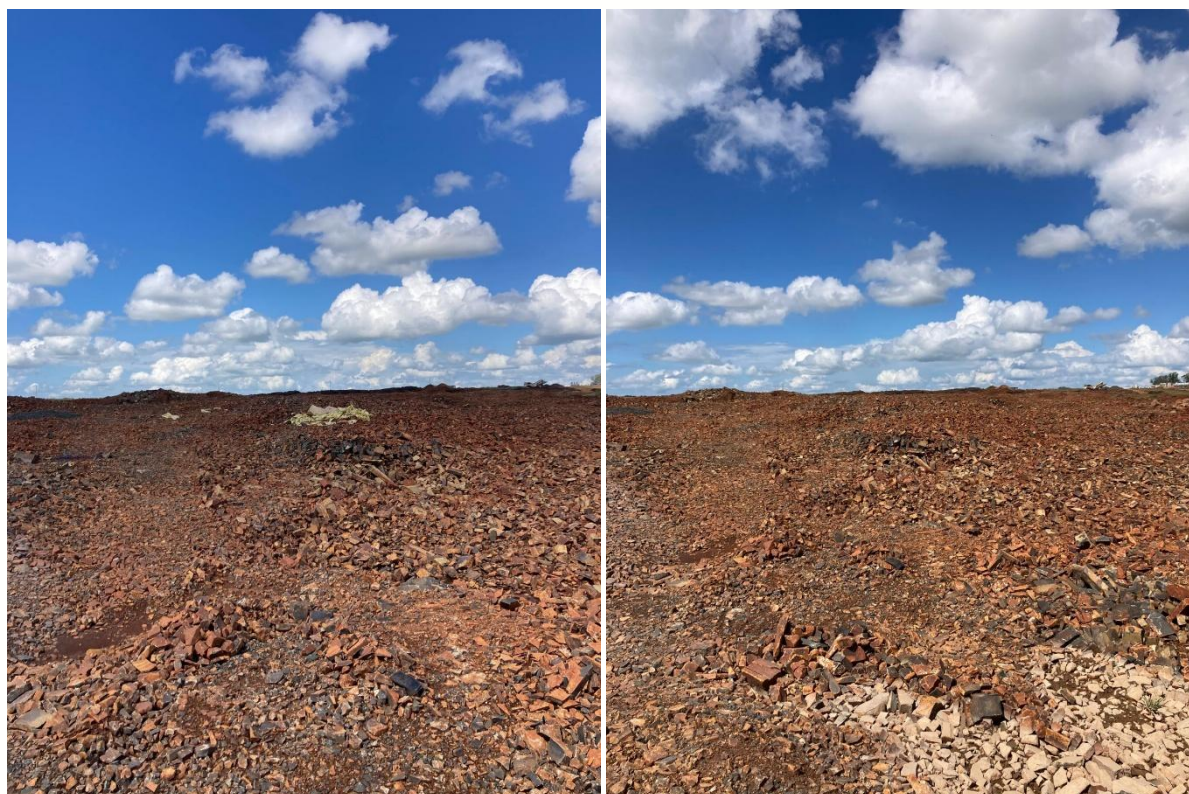
Foto N°7: Imagen donde estaban los residuos en la cantera en la zona de explotación. Foto N°8: Una vez recolectados los residuos.
