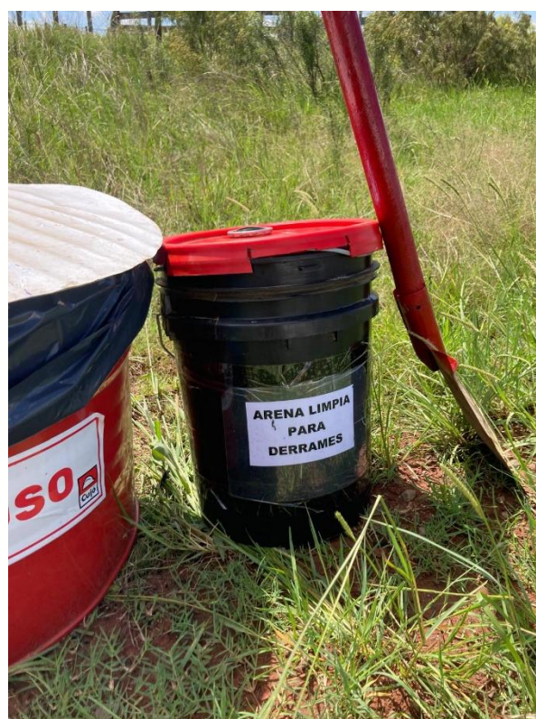
Foto N°2 Y 3: Recipiente cerrado con arena para contener derrames y pala.
