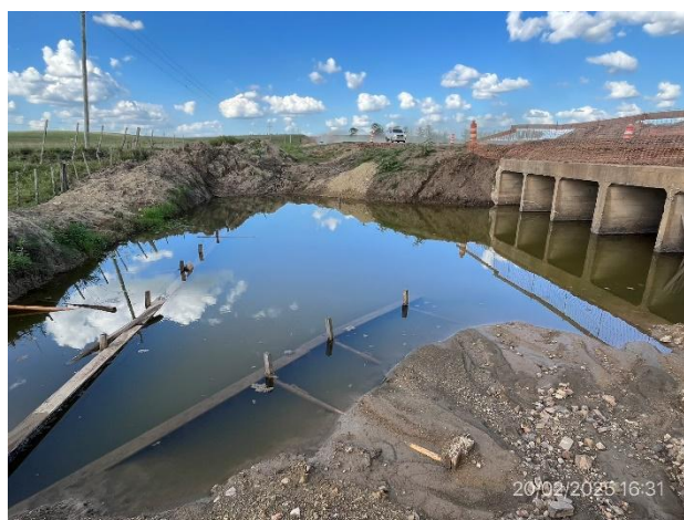
Foto 12.2-6, Ruta 6. Ensanche de alcantarilla en ejecución.
