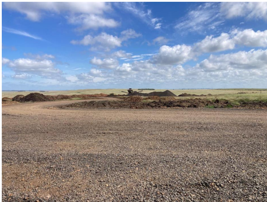
Imagen N°8: Trabajos en la cantera del padrón 18365 de Tacuarembó.
