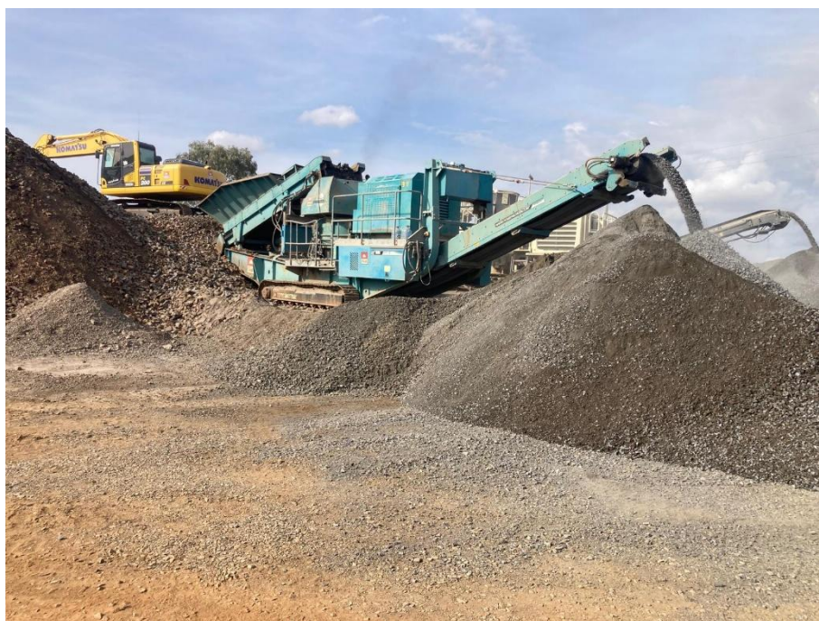
Imagen N°7: Trabajos en la cantera del padrón 18365 de Tacuarembó.
