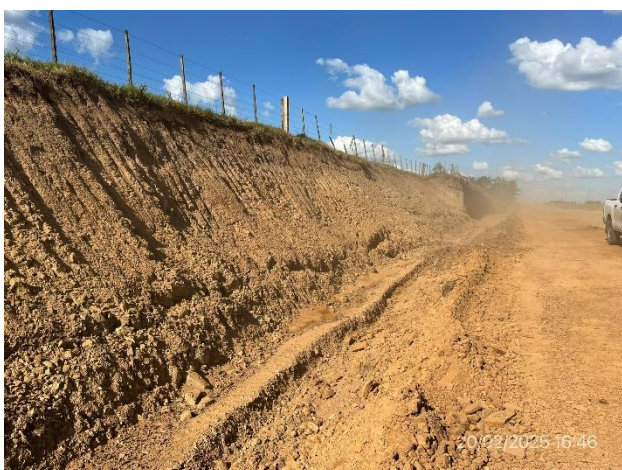
Foto 12.2-5, P07. Con la obra inconclusa, existe gran diferencia de nivel con el terreno lindero y el alambrado está inestable
