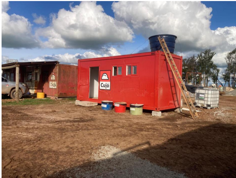
Imagen N°2: Instalaciones de baños.
