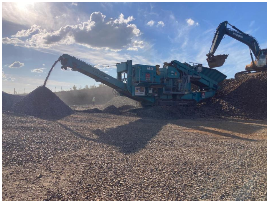
Imagen N°6: Trabajos en la cantera del padrón 18365 de Tacuarembó.
