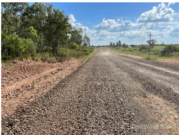
Foto 12.2-3, Ruta 6. Sector con excavación y sub-base granular ejecutadas para ensanche de plataforma.
