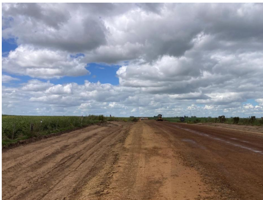
Imagen N°9: Riego y compactación de la ruta.
