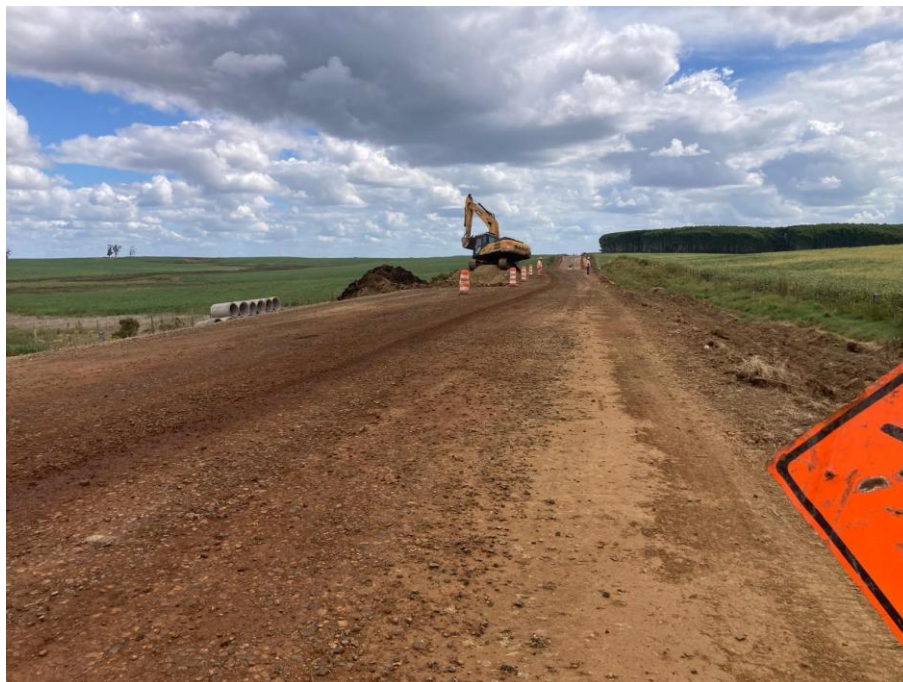
Imagen N°10: Alargue de alcantarillas.
