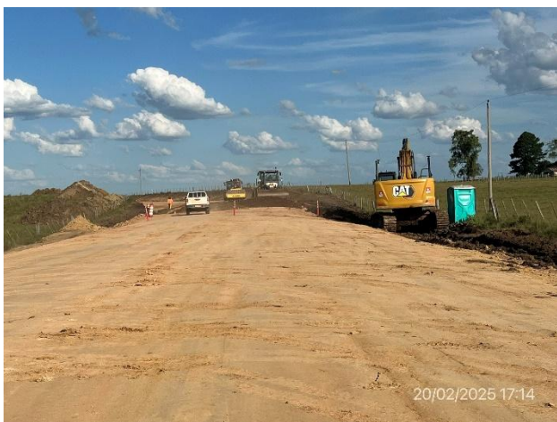
Foto 12.2-9, P05. Frente de obra, tareas de ensanche y recargo granular en ejecución. Baño químico dispuesto en el frente de trabajo.
