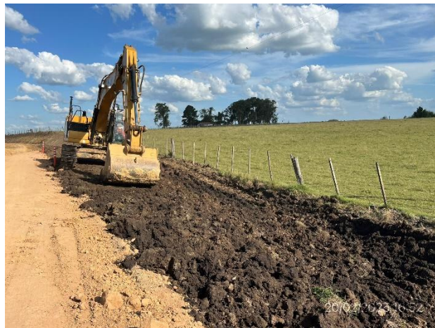
Foto 12.2-8, P05. Frente de obras, Ruta 6 progresiva 345K700*.
