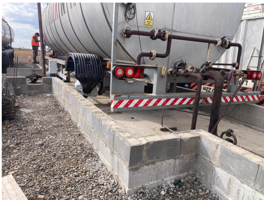
Imagen N°13: Ejecución de la bandeja para la planta asfáltica.
