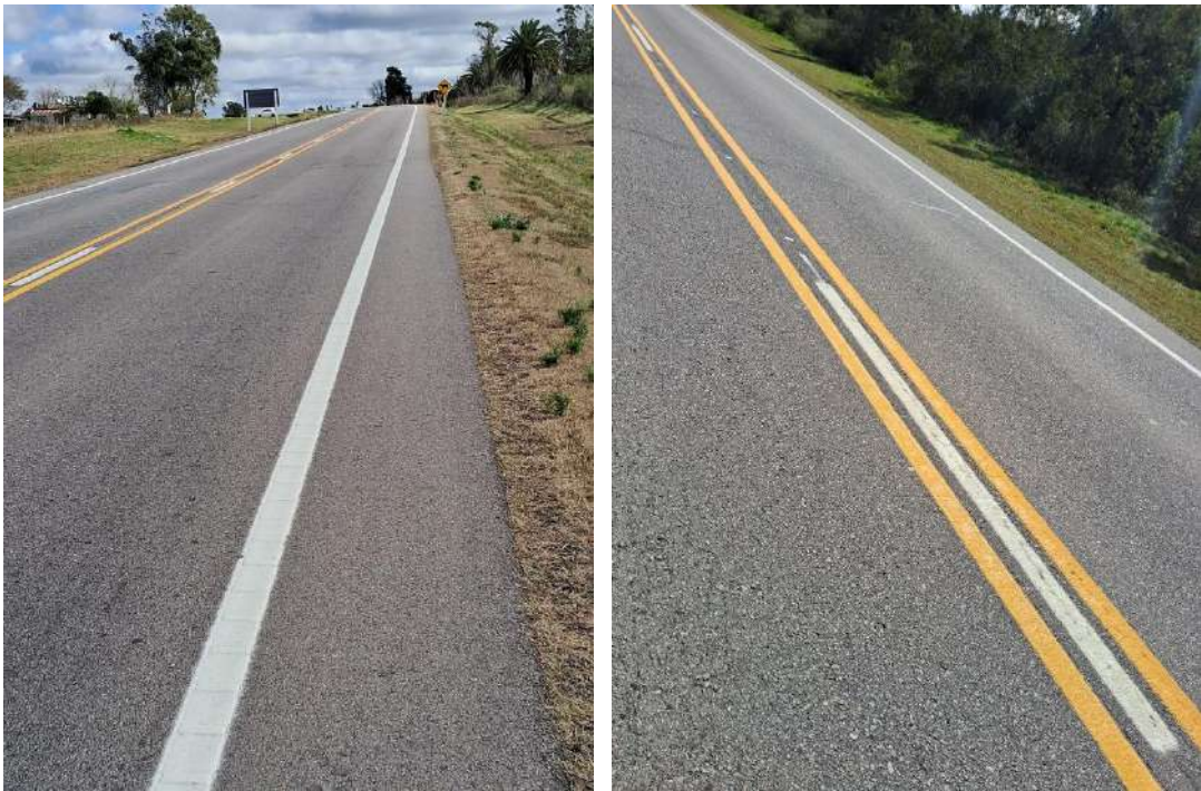
Imagen N°12: Pintura de eje y de borde ruta 12.
