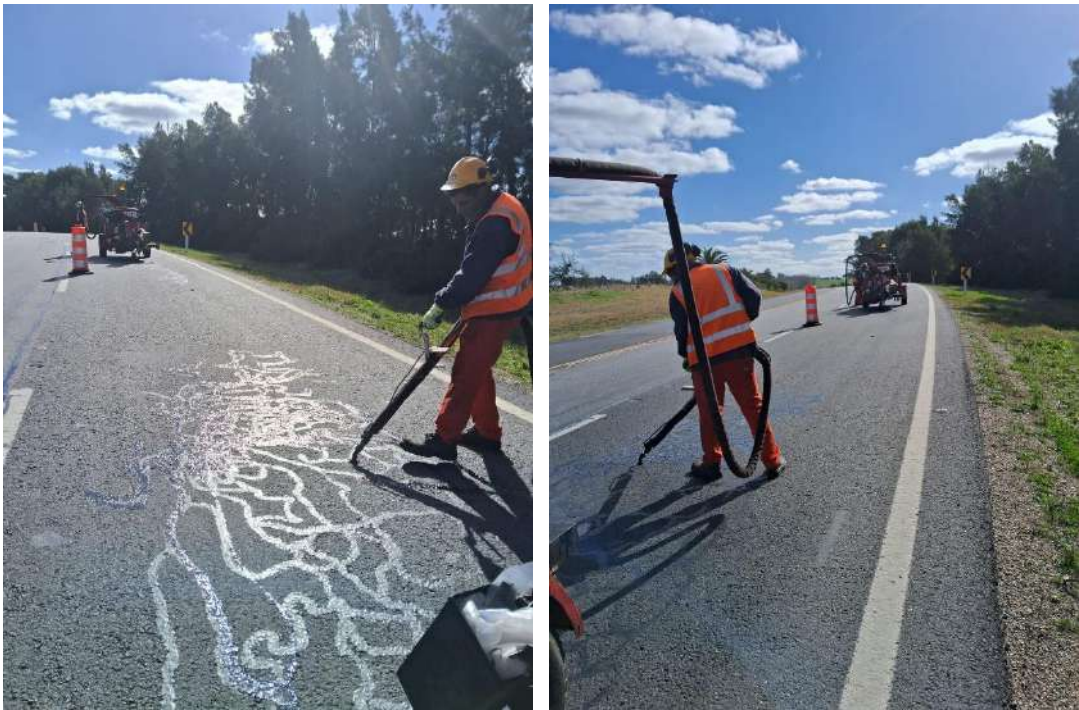
Imagen N°21: sellado por puenteo ruta 23.
