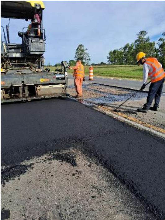
Imagen N°17 y 18: Reparaciones en calzada por rotura.
