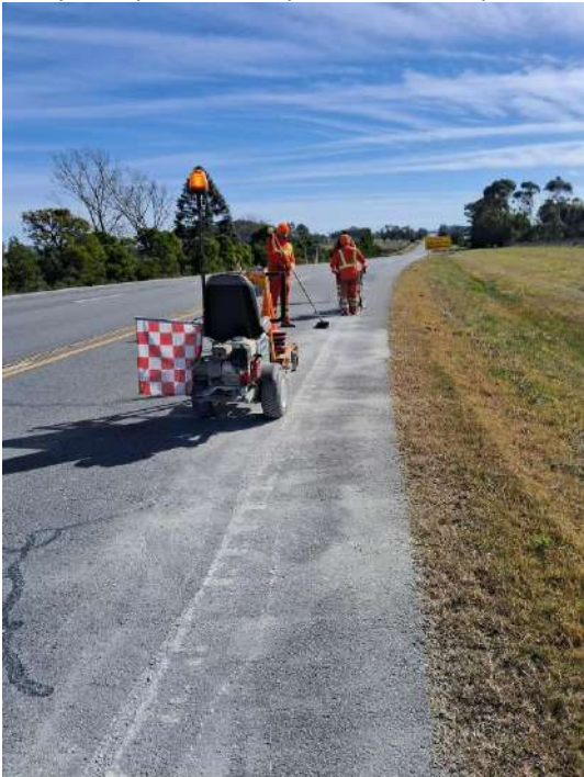
Imagen N°9: Fresado de línea de borde en deterioro.
