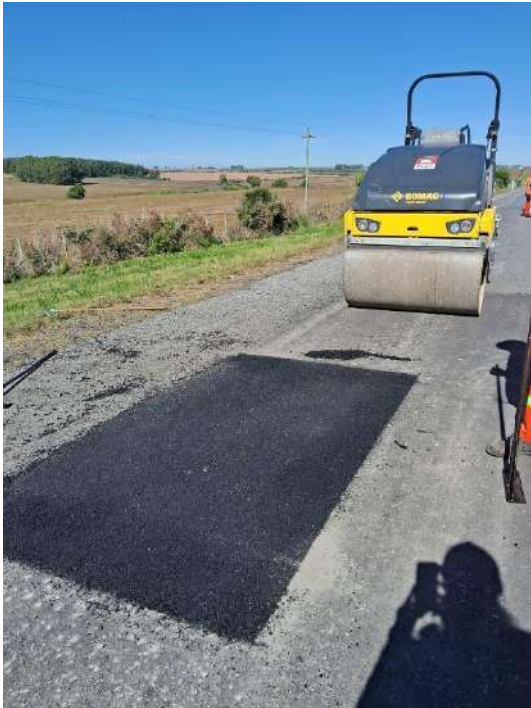
Imagen N°17 y 18: Reparaciones en calzada por rotura.
