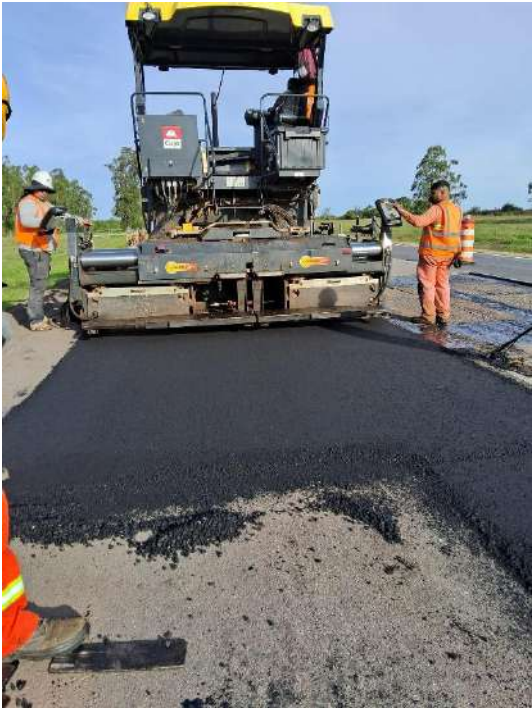
Imagen N°19: Reparaciones en calzada por rotura.
