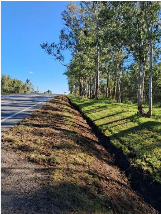
Imagen N°6: Calzada con tierra negra entre banquina y cuneta.
