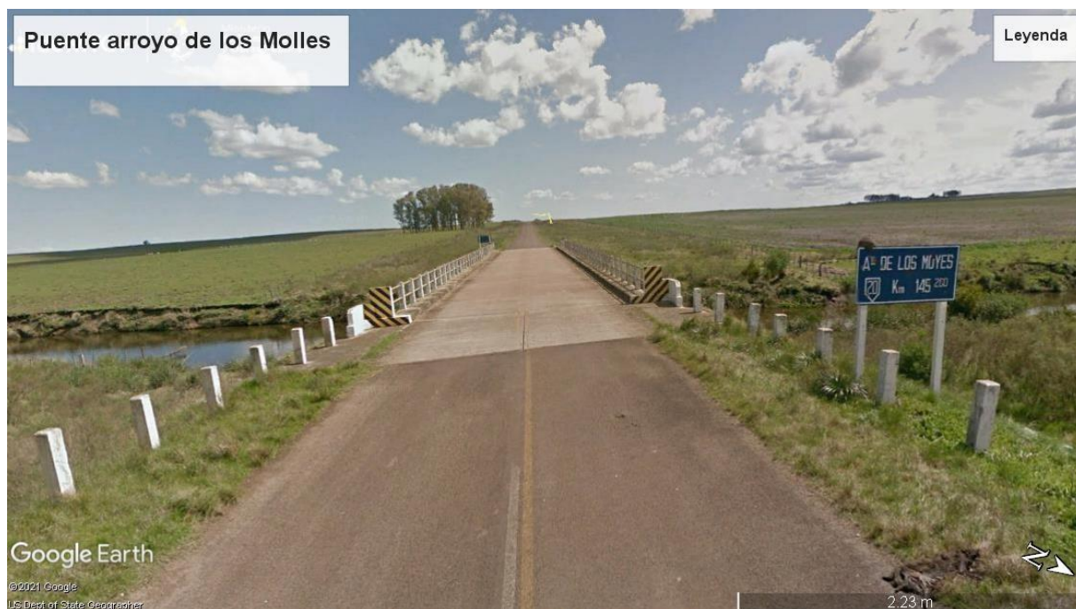
Ilustración 2-1 Situación actual Puente arroyo de los Molles
