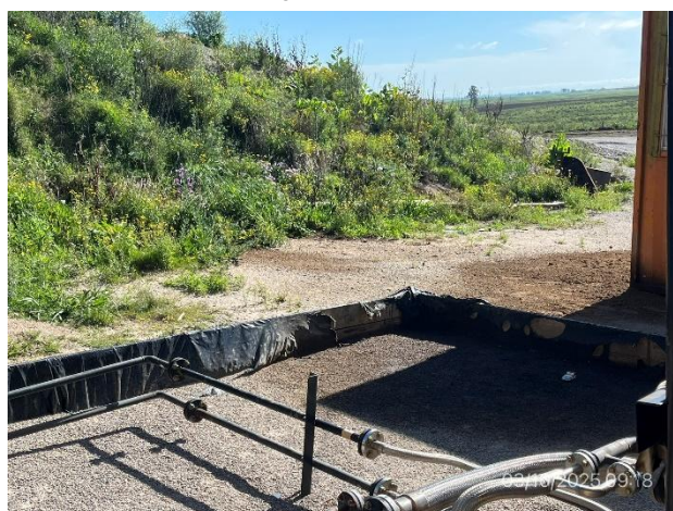
Foto 12.1-4, P03. Planta asfáltica, el envallado perimetral es precario y no garantiza la estanqueidad.
