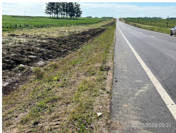
Foto 12.2-4, Ruta 56. Obras terminadas, faja pública con recuperación ambiental realizada. Buenas condiciones de drenaje y empastado vegetal en crecimiento en cunetas.
