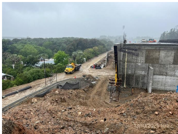
Foto 12.1-2, P01. Puente en obra. Estribos y tablero superior del puente en ejecución
