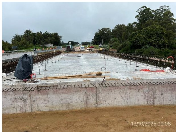
Foto 12.3-2, P03. Puente en obra, losa de tablero superior construida
