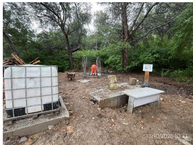
Foto 12.1-8, P01. Campamento provisorio, pileta para lavado de elementos en contacto con hormigón.
