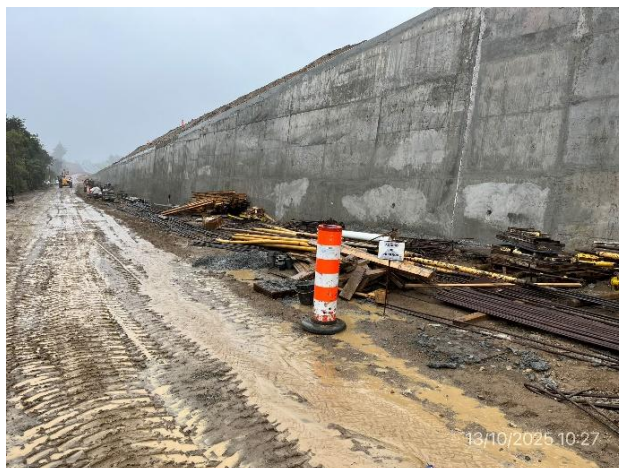
Foto 12.1-4, P01. Puente en obra. Acceso lateral, acopio de armaduras con buenas condiciones de orden
