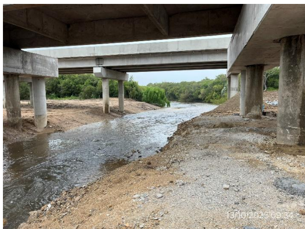
Foto 12.2-5, P02. A° Garzón, ataguía granular pendiente de ser removida. El curso de agua está limpio.
