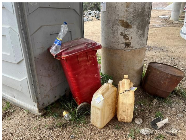
Foto 12.2-6, P02. infraestructura precaria para acopio temporal de residuos y bidones con lubricantes apoyados sobre suelo desnudo.
