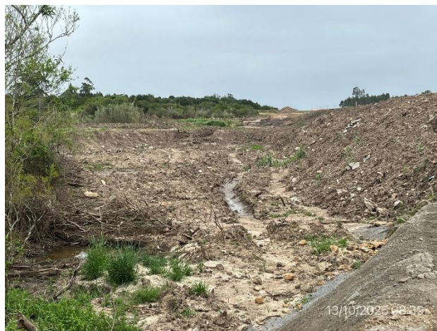
Foto 12.4-8, P04. Puente en obra, se ejecutó una excavación a préstamo que genera un desnivel con el terreno circundante.
