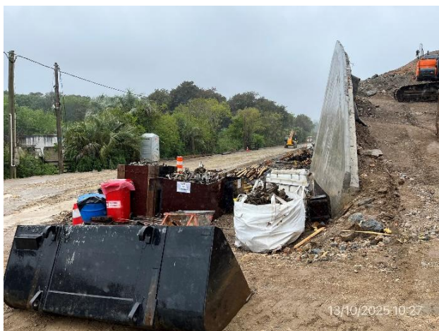
Foto 12.1-5, P01. Puente en obra, dotado de infraestructura para acopio temporal de residuos segregados en origen.
