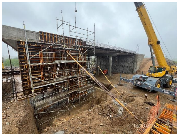
Foto 12.1-6, P01. Puente en obra. Movimiento de suelo y excavaciones en ejecución.
