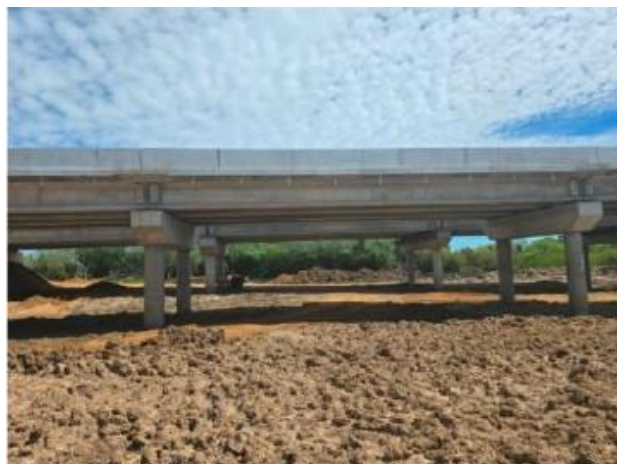
Foto 12.5-8. P04. Se retiraron los ROCs en la planicie de inundación del puente.
