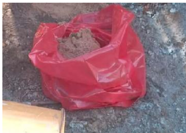
Foto 12.5-2, P01. Se recogió con arena y se embolsó como residuo peligroso para disposición final el derrame de productos químicos
