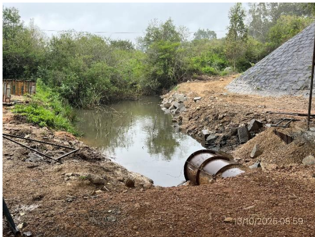
Foto 12.3-3, P03. Puente en obra, ataguía granular construida y curso de agua entubado.
