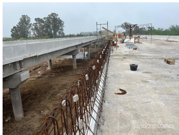
Foto 12.4-6, P04. Puente en obra, obras de tablero superior en ejecución. Buenas condiciones de orden y limpieza.
