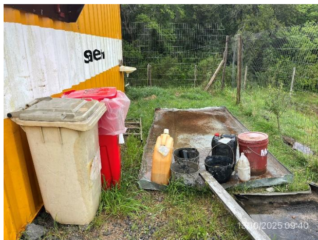
Foto 12.2-10, P02. Obrador provisorio, está presente la infraestructura para acopio de residuos segregados desde origen y los lubricantes se apoyan sobre bandeja estanca.
