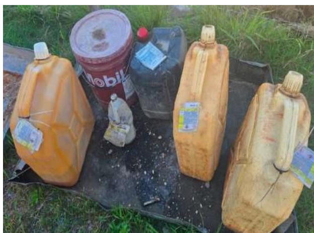
Foto 12.5-3, P02. Se colocó bandeja de contención bajo botellas y bidones con productos químicos.
