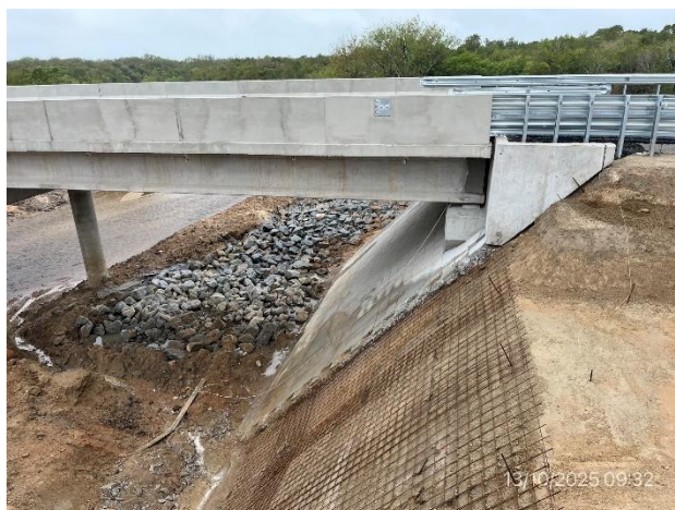
Foto 12.2-4, P02. Puente senda a (-), construcción de revestimientos de cuartos de cono
