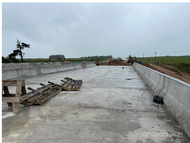
Foto 12.2-3, P02. Puente senda a (-), tablero y vigas New Jersey terminados.
