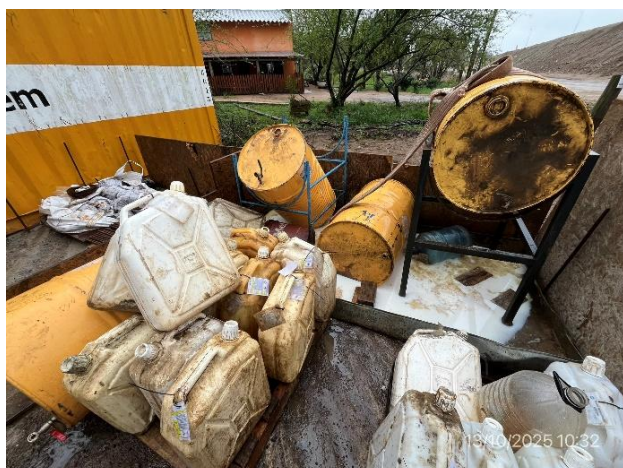
Foto 12.1-11, P01. Campamento provisorio, envallado a cielo abierto con derrames de productos químicos diluidos con aguas pluviales, pendientes de disposición final.
