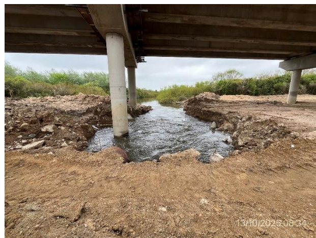
Foto 12.4-2, P04. Puente en obra, ataguía granular construida y curso de agua entubado
