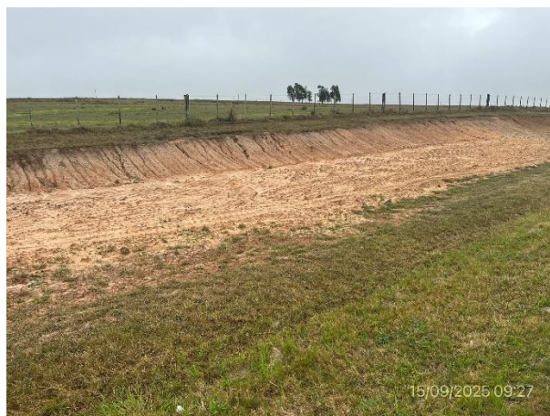
Foto 12.1-10. Ruta 9, hay erosiones atribuibles al escurrimiento pluvial sobre suelo desnudo en los taludes de la faja pública, senda a (-).
