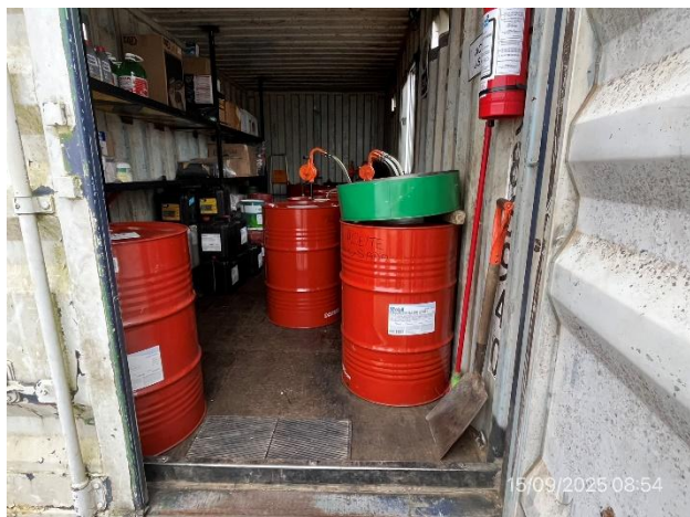
Foto 12.2-3, P05. Depósito de lubricantes envallado y cerrado, en buenas condiciones de limpieza.
