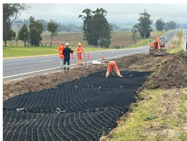
Foto 12.1-6. Ruta 9. Colocación en curso de geogrillas en cantero central.
