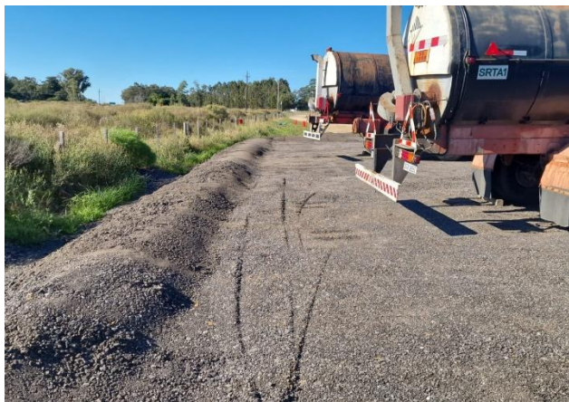
Foto 12.3-1. P03, obrador. Ruta 9 progresiva 173K400 a (-). Se agregó cordoneta perimetral para contener eventuales derrames de las cisternas de emulsión. .
