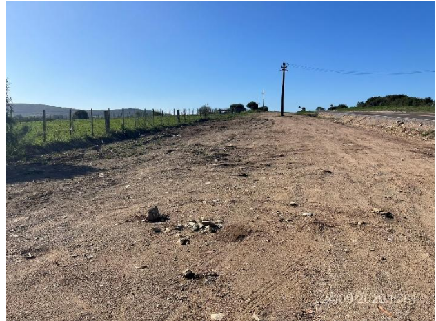
Foto 12.1-2, P04. Campamento provisorio desmontado, se retiraron todas las infraestructuras y se homogeneizó el suelo natural. El empastado está en crecimiento.
