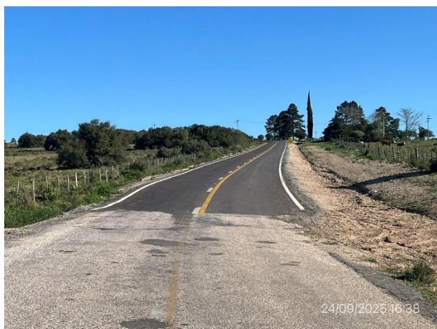
Foto 12.2-5, P02. Fin del tramo, variante A° Canelones, Ruta 12 progresiva 374K650.
