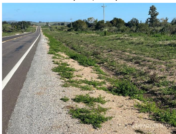
Foto 12.2-4, Ruta 12. Faja pública con desagües correctos y cunetas con empastado vegetal incipiente.
