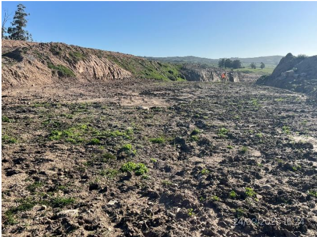
Foto 12.3-1, P03. Cantera y obrador abandonados de Grinor SA. Padrón N°27338, 4ª S.C. de Maldonado. Ruta 12 progresiva 386K700.
