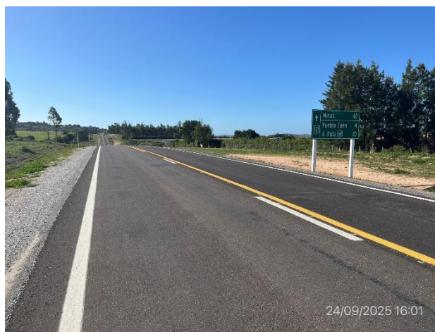
Foto 12.2-2, Ruta 12. Obras terminadas, calzada ensanchada y banquetas ejecutadas.
