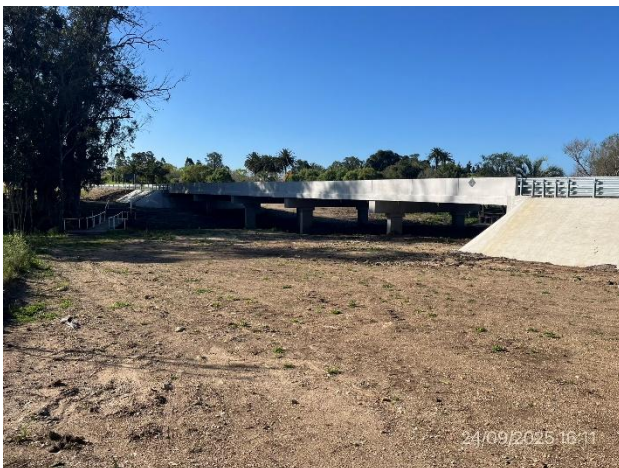
Foto 12.1-9, P05. Estructuras terminadas. Puente peatonal de acceso al parque en buenas condiciones.
