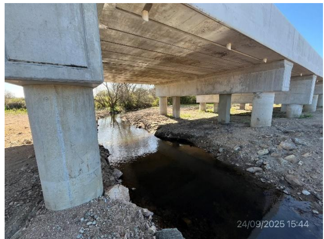
Foto 12.1-6, P04. Estructuras terminadas. Curso de agua limpio, en buenas condiciones de escurrimiento.
