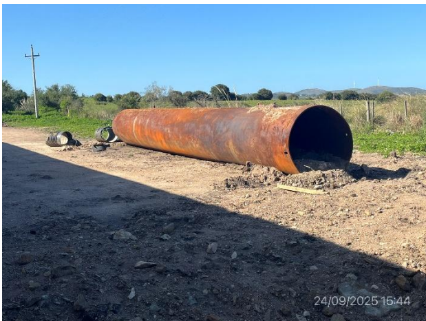
Foto 12.1-5, P04. Planicie de inundación, permanece por retirar un encofrado metálico y algunos ROCs.
