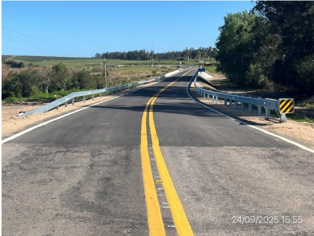
Foto 12.1-1, P04 Puente terminado sobre A° Sarandí, Ruta 12 progresiva 387K100. Carpeta de rodadura y obras de defensas y de señalización terminadas.
