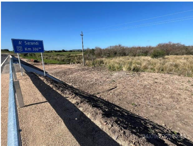
Foto 12.1-3, P04. Se perfilan los taludes de la senda a (+) con acopio granula preexistente.
