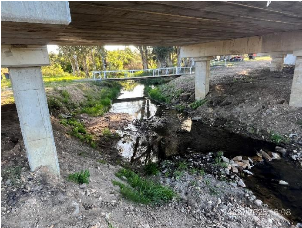
Foto 12.1-7, P05. Puente terminado sobre A° Pintado. Ruta 12 progresiva 378K900. Se retiraron el entubado y la ataguía granular.
