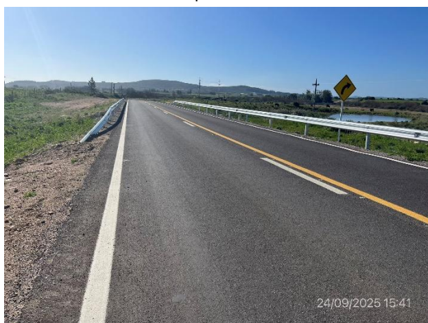
Foto 12.2-3, Ruta 12. Obras de señalización y defensas metálicas terminadas.
