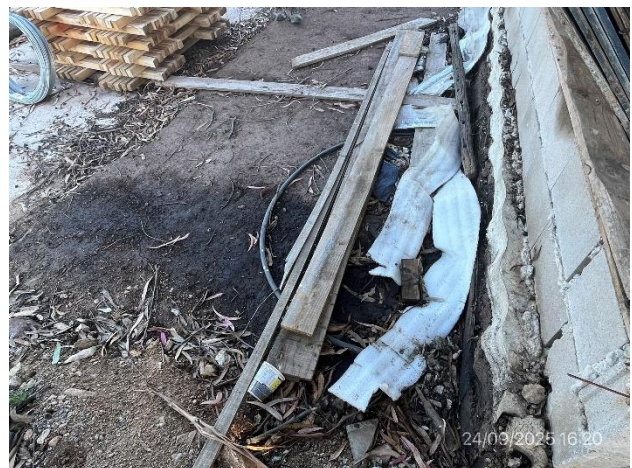
Foto 12.3-4, P03. Quedan residuos oleosos pendientes de retiro y disposición final como residuos contaminantes.
