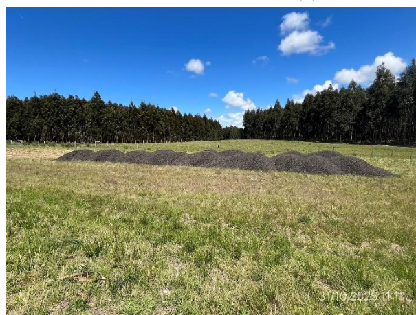
Foto 12.2-4. Acopio de RAP en faja pública. Ruta 5 progresiva 226K700 a (-)
