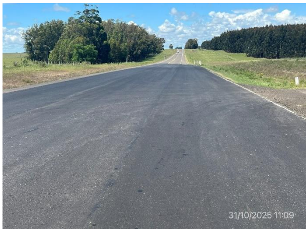
Foto 12.2-1, Ruta 5. Bacheo de calzada ejecutado en ambas sendas.
