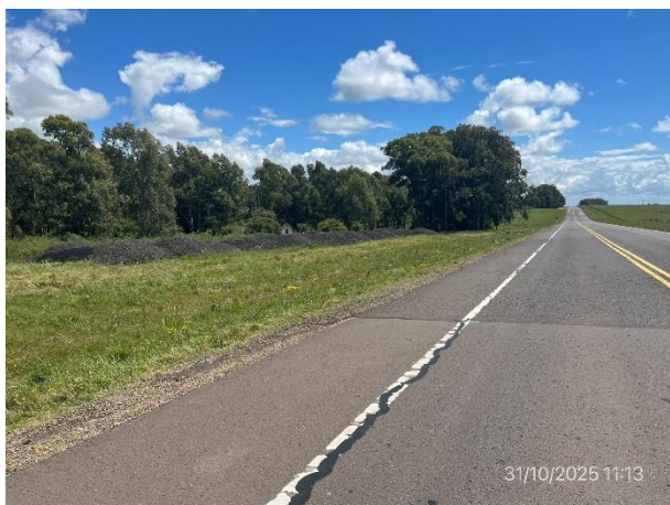
Foto 12.2-5. Acopio de RAP en faja pública. Ruta 5 progresiva 225K500 a (-).
