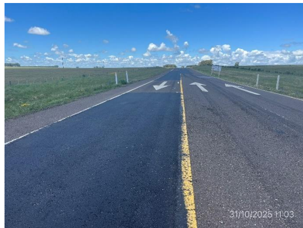
Foto 12.2-2, Ruta 5. Bacheo de calzada ejecutado en terceros carriles, senda a (+).
