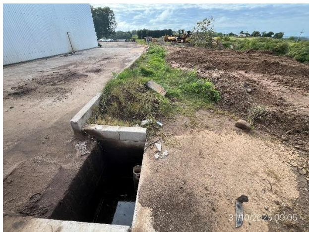
Foto 12.1-7, P02. Zona de lavado de camiones con pendiente hacia cámara de recolección de aguas oleosas.
