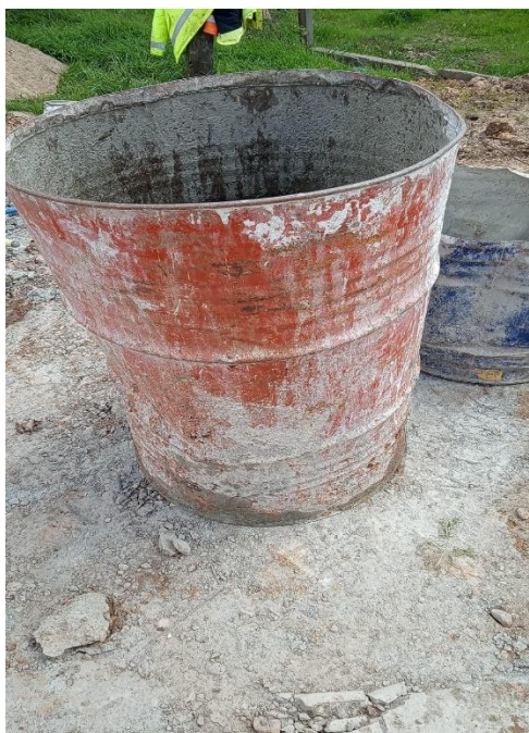
Foto 12.3-1. Empalme DTP con Ruta 26, se colocaron tarrinas para lavado de herramientas.
