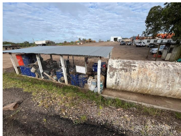
Foto 12.1-6, P02. Recinto de acopio de lubricantes cerrado, techado y con envallado perimetral estanco.
