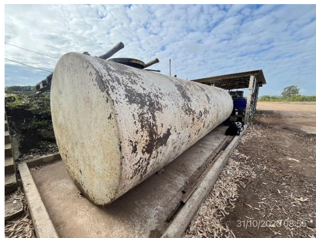
Foto 12.1-4, P02. Depósito y surtidor de combustible. El envallado perimetral no cubre el 110% de su volumen.
